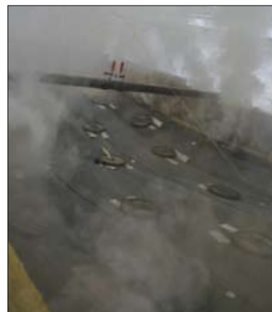
Fot. 5 | Dach z hydroizolacją w postaci papy oraz termoizolacją w postaci płyt EPS podczas badania odporności ogniowej
