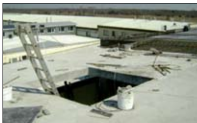
Fot. 11 | Brak zabezpieczenia otworu technologicznego w stropie (fot. autor)
