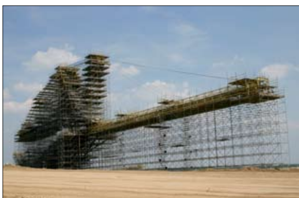
Fot. 4 | Rusztowania modułowe do prac renowacyjnych koparki na terenie kopalni odkrywkowej Tagebau Reichwalde
