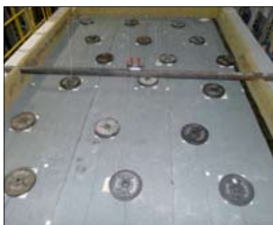
Fot. 1 | Dach (z rozmieszczonym obciążeniem) z hydroizolacją w postaci papy przed badaniem odporności ogniowej
