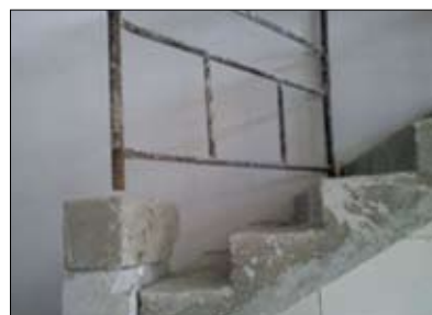
Fot. 15 | Nieprawidłowe posadowienie rusztowania warszawskiego na schodach (fot. autor)
