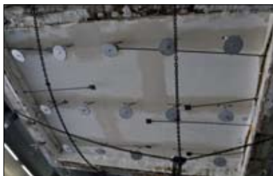
Fot. 23 | Dach z nośnymi belkami drewnianymi (wewnątrz elementu) przed badaniem odporności ogniowej
