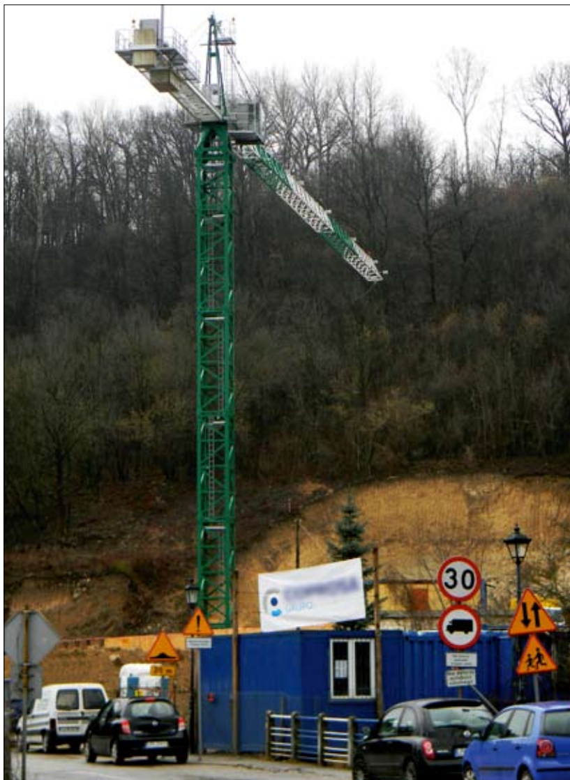
Fot. 2 | Pod Górą Trzech Krzyży pojawił się żuraw oraz ogromny wykop pod fundamenty i piwnice nowej szkoły
