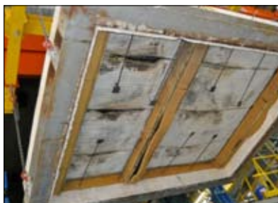
Fot. 18 | Dach z płyt warstwowych z rdzeniem typu PUR od dołu po badaniu odporności ogniowej
