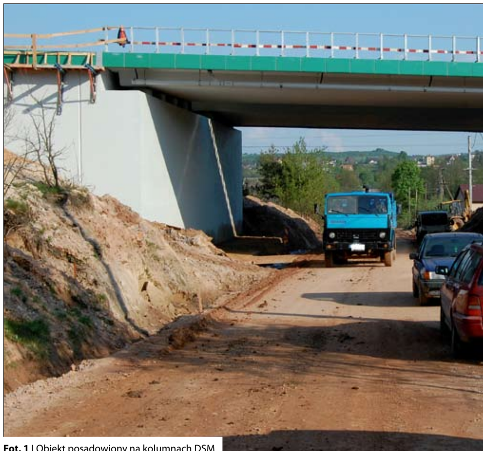
Fot. 1 | Obiekt posadowiony na kolumnach DSM
