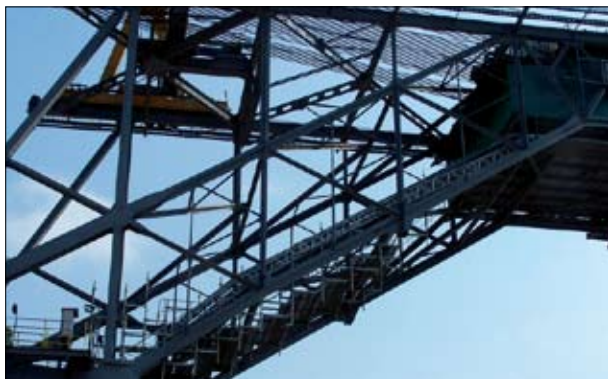
Fot. 3 | Rusztowania modułowe przy remoncie koparek w Kopalni Węgla Brunatnego „Bełchatów”
