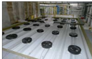
Fot. 25 | Dach w postaci stalowej blachy trapezowej przed badaniem odporności ogniowej
