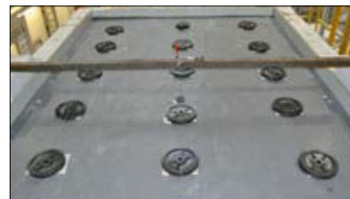
Fot. 2 | Dach (z rozmieszczonym obciążeniem) z hydroizolacją w postaci membrany PVC przed badaniem odporności ogniowej
