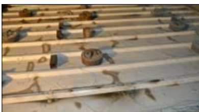
Fot. 15 | Dach z płyt warstwowych z rdzeniem typu PIR od góry podczas badania odporności ogniowej
