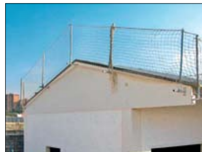
Fot. 5 | Siatka typu U (stanowi zabezpieczenie krawędzi) [7]
