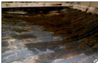
Fot. 10 | Blacha trapezowa po demontażu warstw dachowych po badaniu odporności ogniowej
