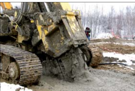
Fot. 8 | Maszyna w czasie wykonywania ciągłej ściany
