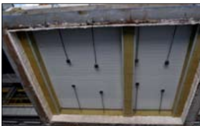
Fot. 13 | Dach z płyt warstwowych od spodu przed badaniem odporności ogniowej
