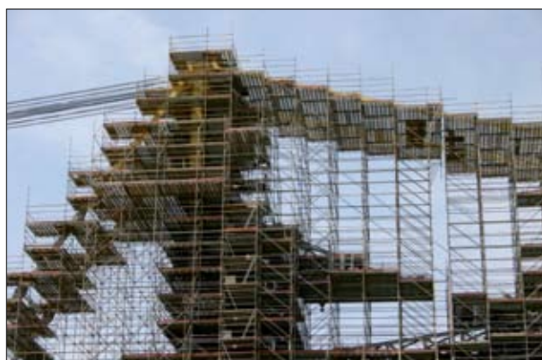
Fot. 4 | Rusztowania modułowe do prac renowacyjnych koparki na terenie kopalni odkrywkowej Tagebau Reichwalde
