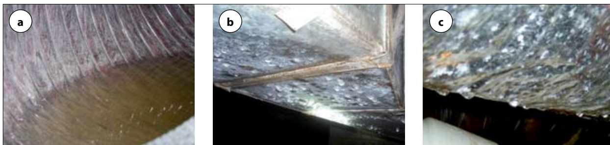
Fot. 1 | Zawilgocenie instalacji wentylacyjnej w wyniku kondensacji pary wodnej: a) obecność wody oraz ślady zagrzybienia w przewodzie elastycznym [3], b) kondensacja pary wodnej na zewnętrznej powierzchni niez izolowanego przewodu wentylacyjnego [2] (dzięki uprzejmości Dream Home Consultants, LLC), c) kondensacja na przewodzie z uszkodzoną (zgniecioną) izolacją [1]
