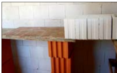
Fot. 12 | Nieprawidłowo wykonany pomost roboczy (fot. autor)
