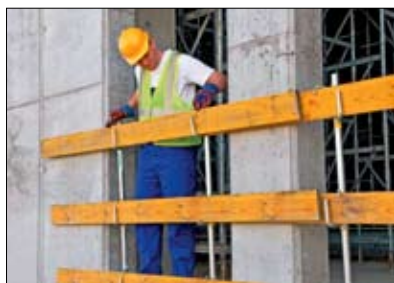
Fot. 1 | Pracownik mocujący poręcz w balustradzie ochronnej [5]
