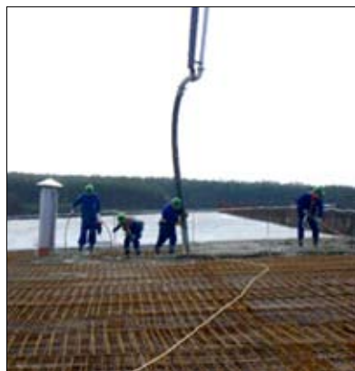
Fot. 10 | Nieprawidłowe zabezpieczenie stanowiska pracy na stropie (fot. autor)
