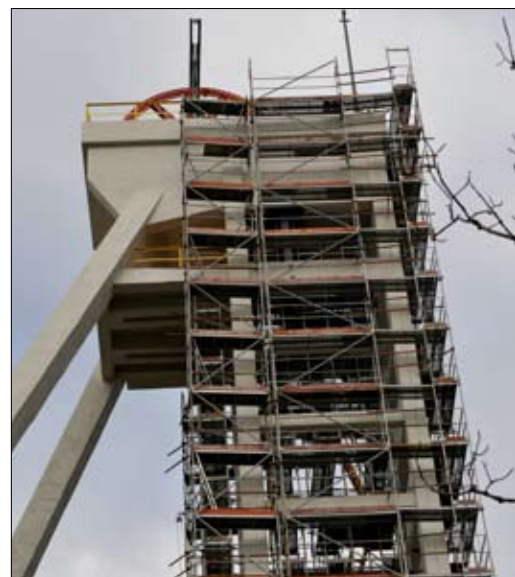
Fot. 1 | Rusztowania zamontowane przy remoncie konstrukcji szybu „Prezydent” w Chorzowie
