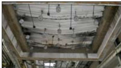
Fot. 12 | Dach warstwowy z termoizolacją z płyt typu PIR po badaniu odporności ogniowej od strony nagrzewanej
