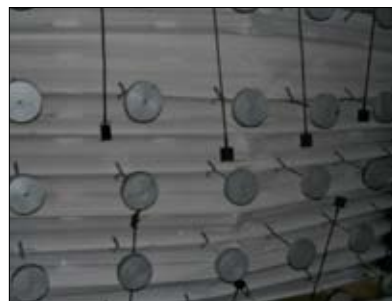
Fot. 28 | Dach w postaci stalowej blachy trapezowej po badaniu odporności ogniowej od strony nagrzewanej (widoczne charakterystyczne „przełamanie” blachy w połowie rozpiętości elementu)
