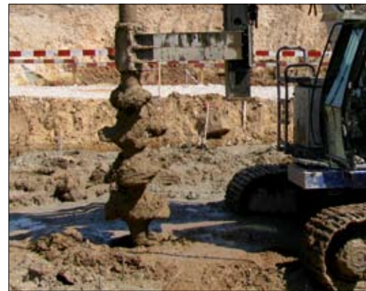
Fot. 3 | Mieszadło oblepione cząstkami gruntu spoistego
