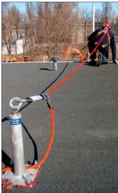
Fot. 7 | Pracownik wykorzystujący szelki bezpieczeństwa z linką, hamulcem i kotwą [5]
