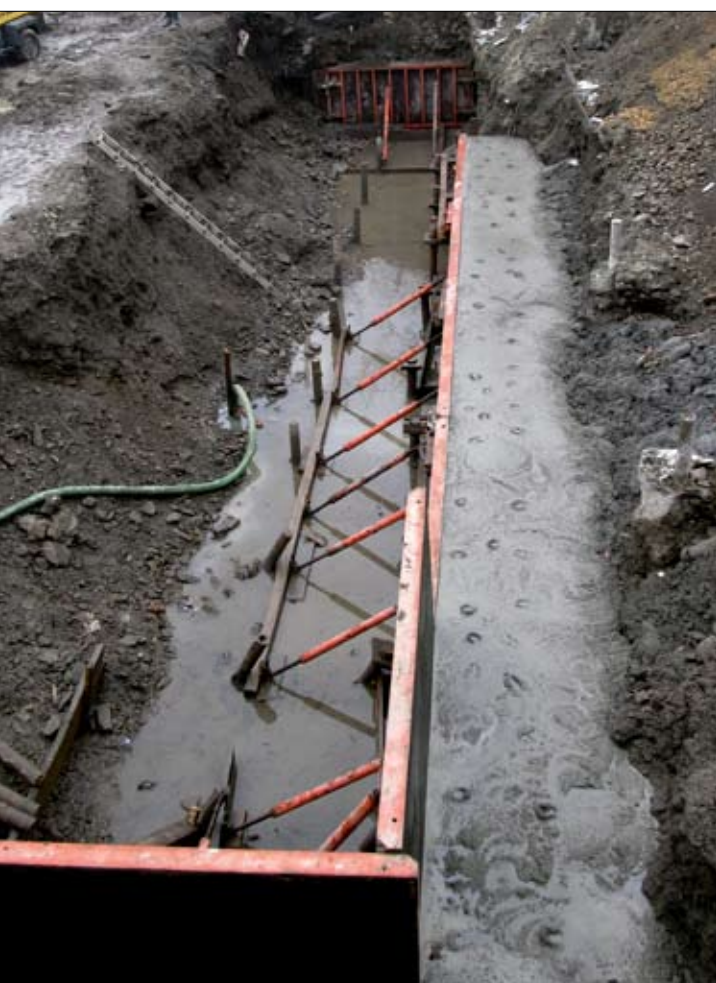
Fot. 10 | Wykop zabezpieczony przed napływem wody – ściana z cementogruntu
