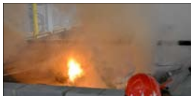
Fot. 7 | Dach z hydroizolacją w postaci membrany PVC oraz termoizolacją w postaci płyt typu PIR w czasie osiągnięcia kryterium szczelności ogniowej w badaniu odporności ogniowej
