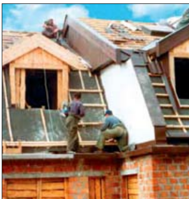
Fot. 9 | Wykonywanie prac dekarских bez zabezpieczeń [6]
