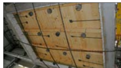
Fot. 3 | Dach od spodu (z rozmieszczonym obciążeniem) przed badaniem odporności ogniowej
