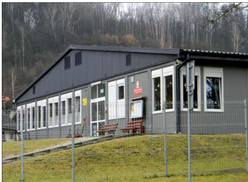
Fot. 1 | Tymczasowa szkoła kontenerowa
