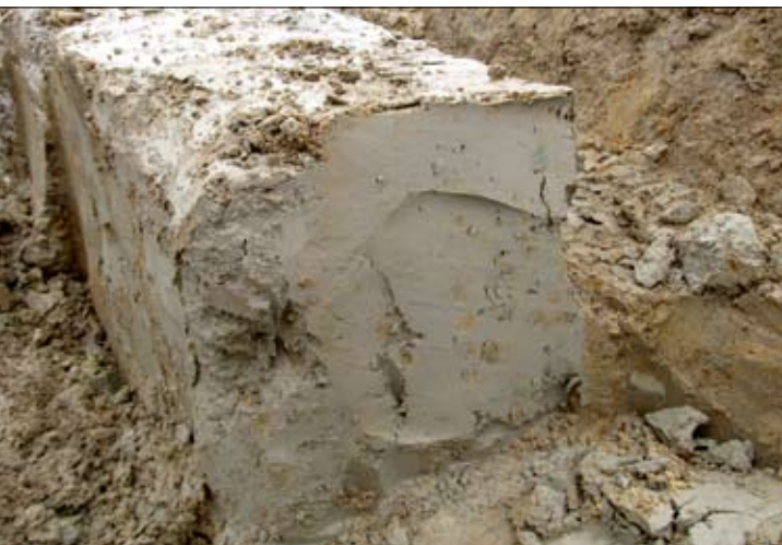
Fot. 9 | Jednorodność wymieszania cementogruntu w ciągłej ścianie
