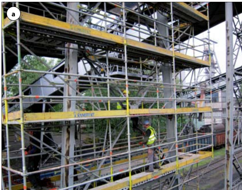
Fot. 2 | Rusztowania zamontowane przy remoncie taśmociągu węglowego w KWK „Borynia-Zofiówka-Jastrzębie”: a) fragment konstrukcji, b) poglądowy rysunek montażowy
