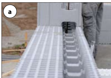
Fot. 1 a) kształtki styropianowe systemu Izodom (www.izodom.pl), b) deskowanie traconie ściany zewnętrznej w technologii Ekobud [8]
