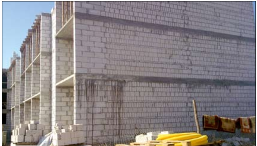
Fot. 8 | Brak odpowiedniego przewiązania elementów murowych i niedopuszczalne murowanie z pozostałości po dociętych elementach oraz z cegieł na sztorc (fot. L. Misiewicz)
