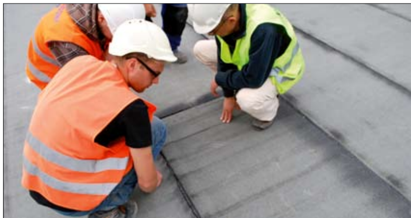
Fot. 4 | Odbiór jakościowy hydroizolacji (autor Natalia Zborowska)
