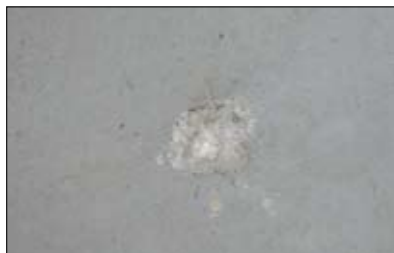
Fot. 5 | Odprysk posadzki spowodowany reakcją alkaliczną kruszywa z cementem
