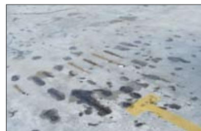
Fot. 12 | Liniowe delaminacje warstwy utwardzonej spowodowane korozją zbrojenia ułożonego zbyt blisko powierzchni
