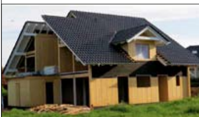
Fot. 7 | Początek budowy, montaż ścian, stropu i dachu (archiwum firmy Hüttemann)
