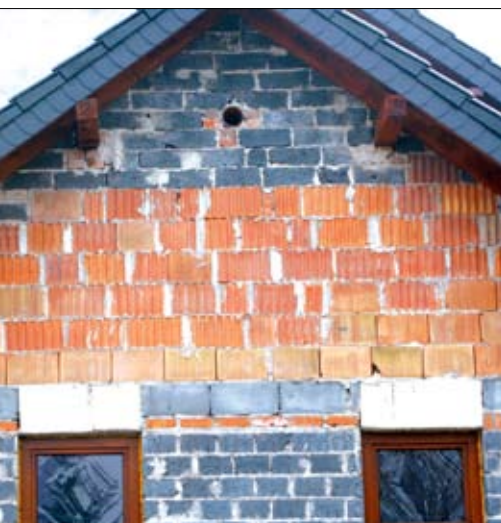
Fot. 11 | Połączenie różnych materiałów na ścianie szczytowej budynku (fot. K. Gromysz)
