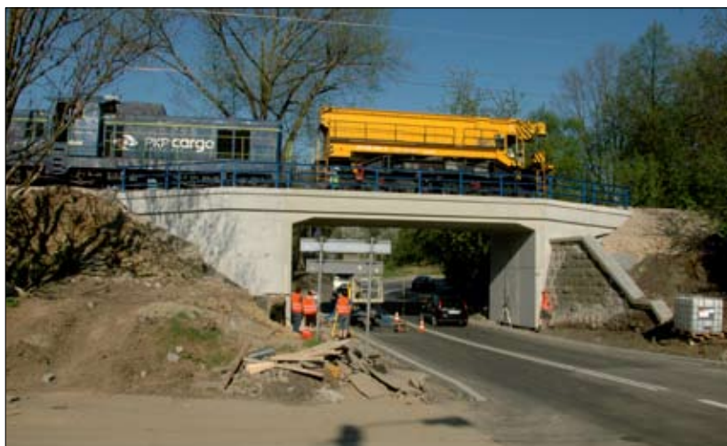
Fot. 5 | Wiadukt ramowy na linii Kraków – Wieliczka
