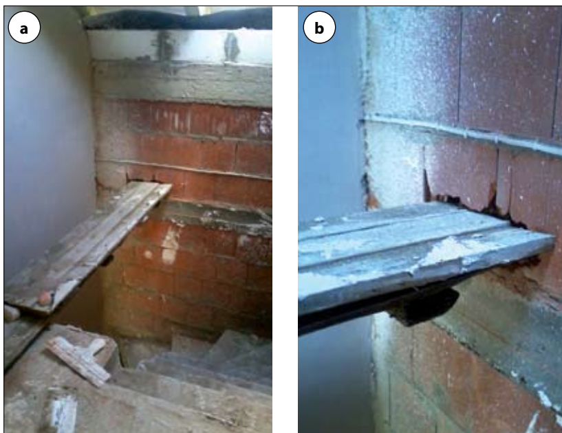
Fot. 21 | Bruzda w ścianie wykonana w celu oparcia pomostu robocznego: a) widok, b) szczegół
