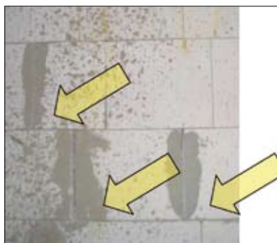
Fot. 3 | Przykład niezamkniętych zamków na skutek złej technologii murowania
