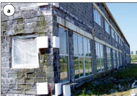
Fot. 17 | Uszkodzenia korozyjne muru spowodowane brakiem zabezpieczenia po wybudowaniu: a) widok budynku, b) i c) szczegóły uszkodzeń (fot. Z. Pająk)
