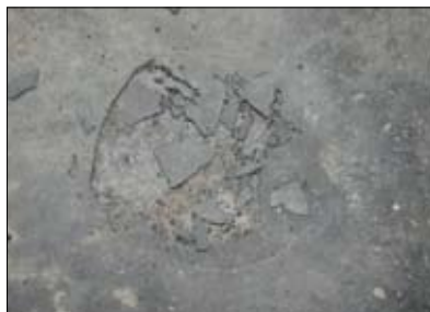
Fot. 9 | Złuszczenie cienkowarstwowe warstwy utwardzonej w miejscu występowania siatki mikrororys
