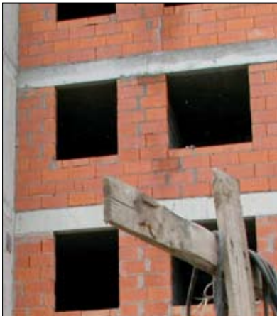
Fot. 7 | Nieodpowiednie przewiązanie muru filarków międzyokiennych (fot. R. Jasiński)
