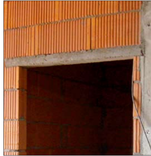
Fot. 23 | Oparcie nadproża ścianki wypełniającej na zbyt wąskim filarku (fot. L. Misiewicz)
