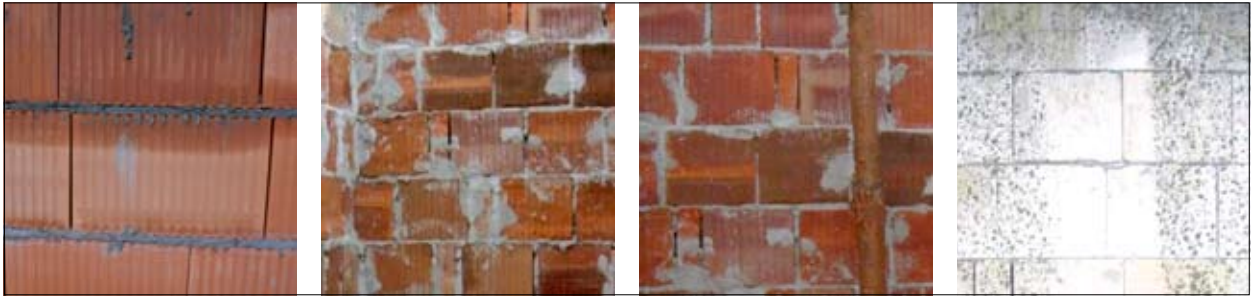
Fot. 6 | Przykłady złego przewiązania elementów murowych
