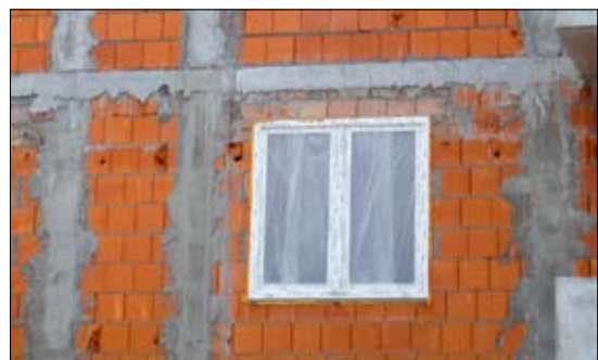
Fot. 14 | Przykład wykonania ściany z uszkodzonych elementów murowych – widoczne nieodpowiednie przewiązanie elementów (fot. L. Misiewicz)
