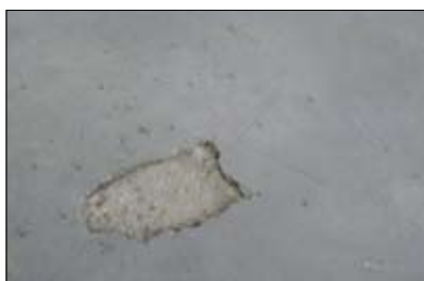
Fot. 10 | Odspojenia miejscowe warstwy utwardzonej w miejscach występowania siatki zarysowań o większych wymiarach oczek
