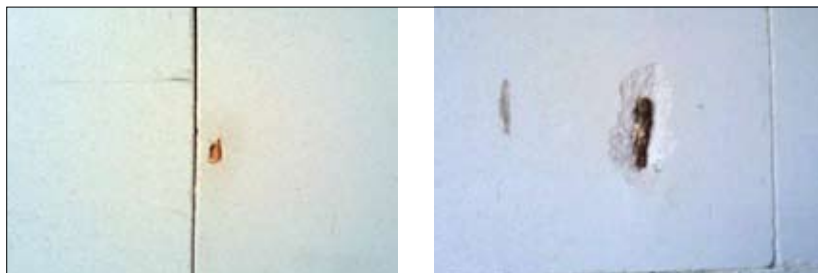
Fot. 13 | Niedopuszczalne zastosowanie elementów murowych z obcymi wtrąceniami
