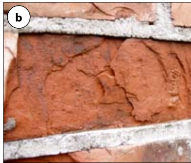
Fot. 16 | Uszkodzenia korozyjne muru na skutek braku zabezpieczenia przed wpływami atmosferycznymi po wykonaniu: a) widok muru, b) szczegół
