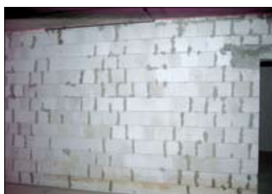
Fot. 4 | Wypełnienie zaprawą niezamkniętych zamków
