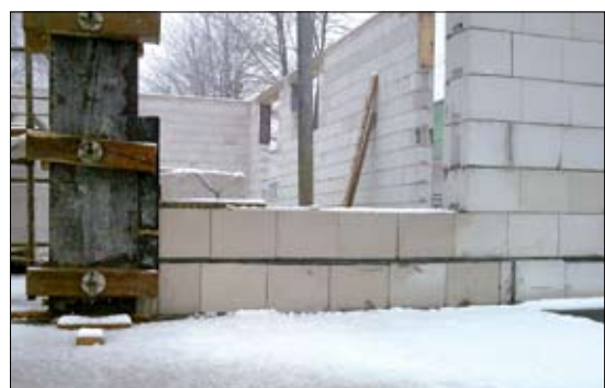
Fot. 15 | Przykład braku zabezpieczenia muru przed wpływami atmosferycznymi. Dodatkowo widoczne nieodpowiednie przewiązanie elementów murowych oraz nierówne ułożenie pierwszej warstwy muru, co skutkowało koniecznością zastosowania zbyt grubej spoiny nad tą warstwą (fot. L. Misiewicz)
