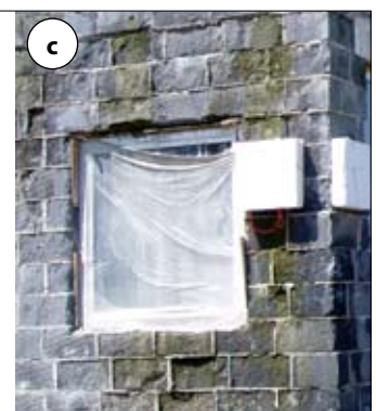
Fot. 17 | Uszkodzenia korozyjne muru spowodowane brakiem zabezpieczenia po wybudowaniu: a) widok budynku, b) i c) szczegóły uszkodzeń (fot. Z. Pająk)
