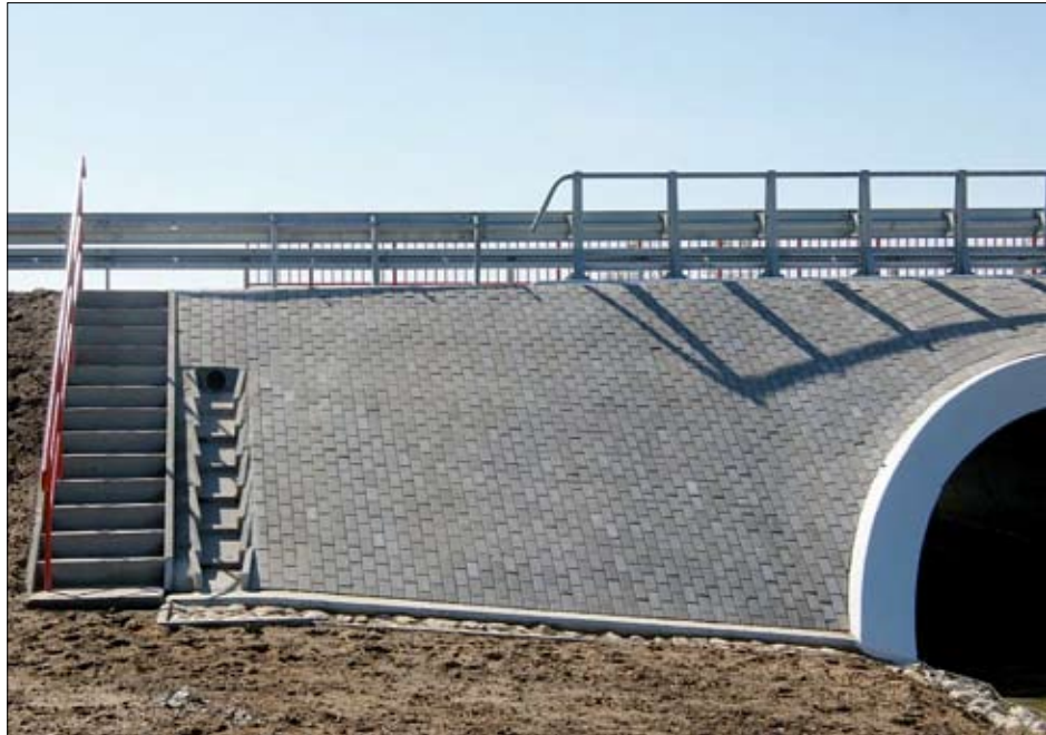
Fot. 3 | Nowy most w ciągu DK 37 w Darłowie
