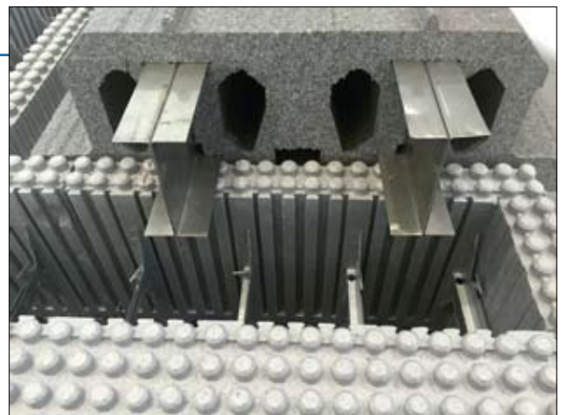
Konstrukcja budynku w technologii szalunku traconego
