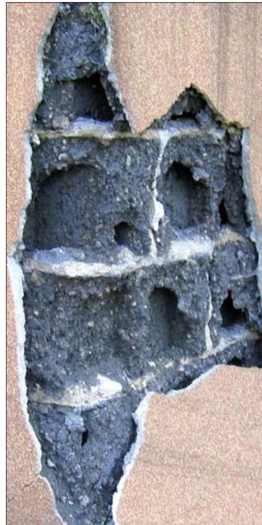
Fot. 18 | Uszkodzenia korozyjne muru spowodowane brakiem izolacji poziomej
