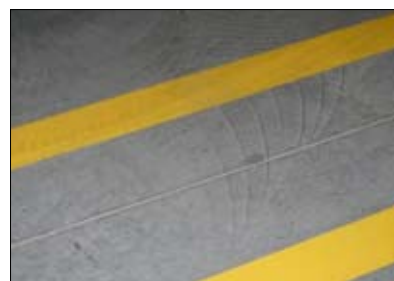
Fot. 2 | Ślady zbyt późnego zacierania posadzki
