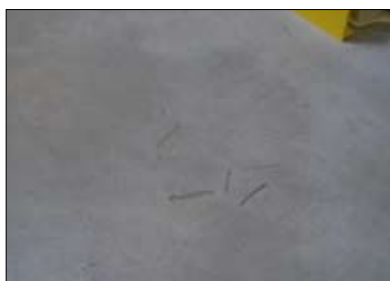
Fot. 1 | Włókna stalowe na powierzchni posadzki
