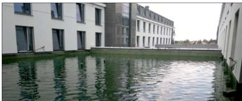
Fot. 5 | Kontrola szczelności hydroizolacji – tzw. „próba wody” (autor Jarema Andrzej Rabiński)
