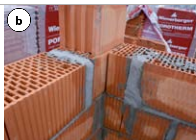
Fot. 5 | Pustaki ceramiczne „przycięte” siekierą (a) i wmurowane w ścianę (b)
