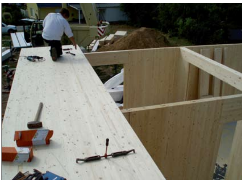
Fot. 3 | Element stropowy z drewna klejonego
