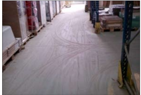
Fot. 3 Intensywne ścieranie posadzki z pyleniem
