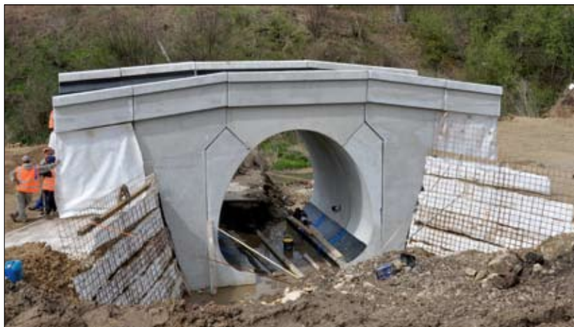
Fot. 4 | Łupinowy most kolejowy na linii Kraków – Wieliczka
