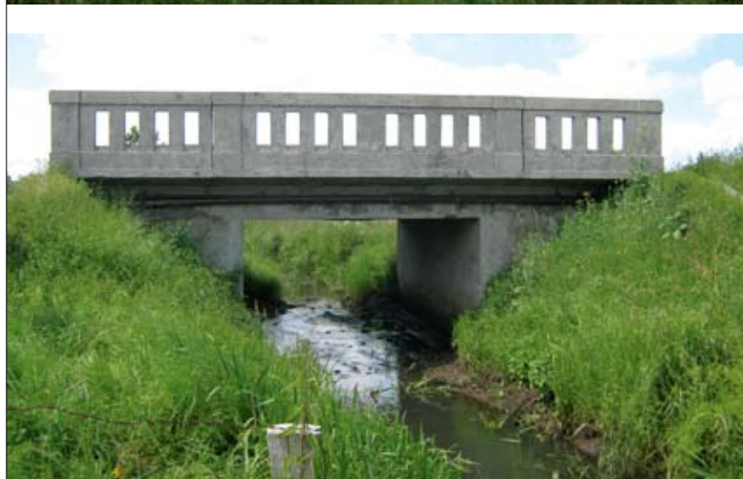
Fot. 1 | Mosty w Darłowie przed rozbiórką
