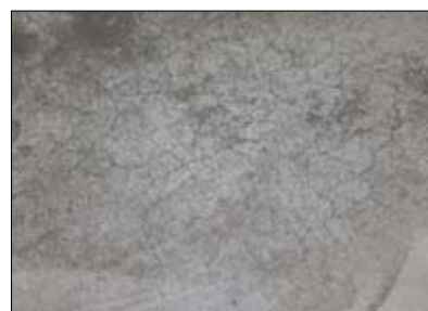
Fot. 7, 8 | Siatka mikrorys powierzchniowych na posadzce suchej i zawilgoconej
