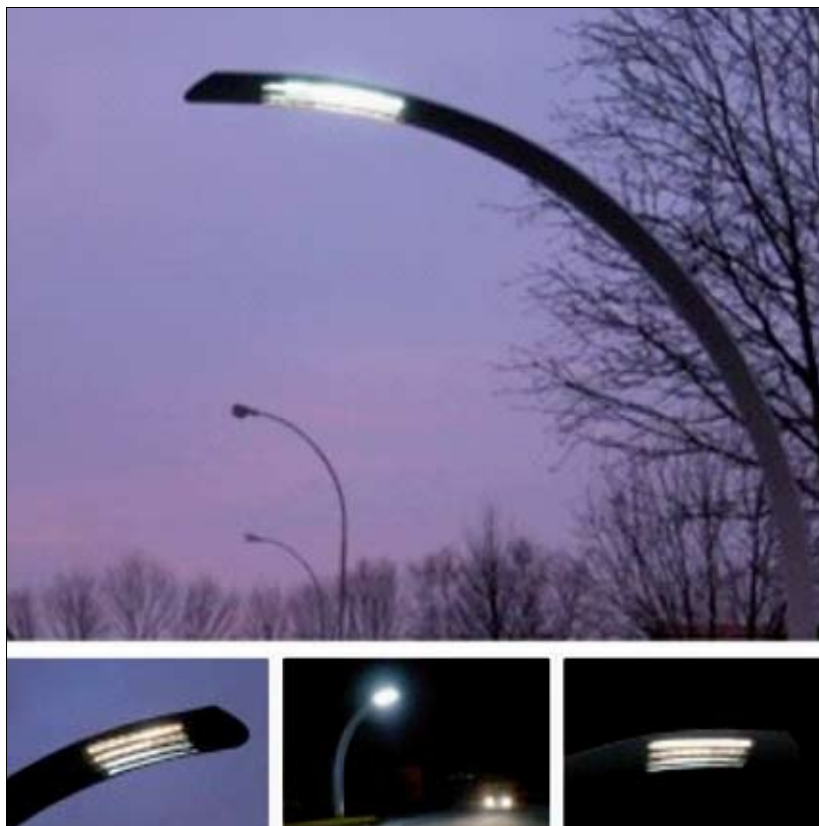
Fot. 2 | Oświetlenie uliczne z zastosowaniem LED
