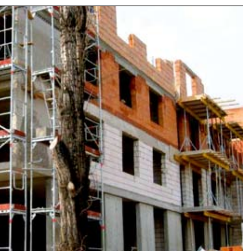
Fot. 12 | Wykonywanie kondygnacji budynku z różnych materiałów (fot. S. Gąsiorowski)
