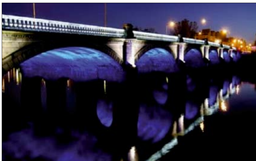
Fot. 1 | Oświetlenie LED mostu króla Jerzego V w Glasgow
