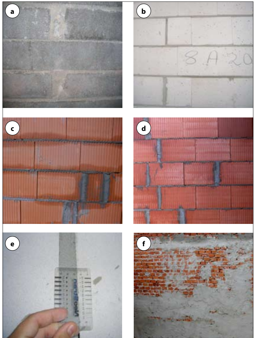
Fot. 2 | Przykłady niewłaściwego wykonawstwa murów: a)–e) zbyt grube spoiny, f) wyrównanie odchylek od pionu zaprawą
