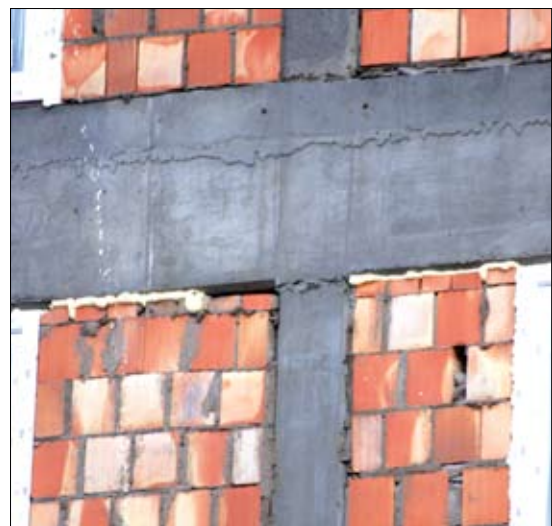
Fot. 22 | Nieodpowiednie wypełnienie szczeliny pod rygłem pianką poliuretanową – widoczne liczne niedokładności wykonania ścian (fot. S. Gąsiorowski)
