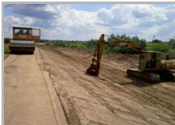
Zagęszczanie korpusu wału nad rz. Kamienną; fot. archiwum firmy ESC
