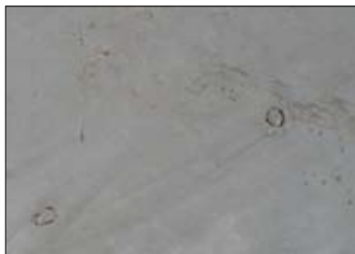
Fot. 6 | Luźne kruszywo na powierzchni posadzki
