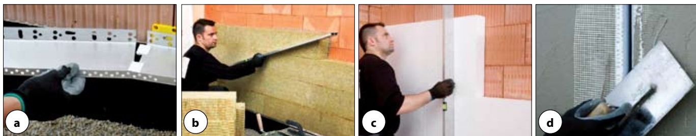
Fot 1 a) montaż listwy startowej, b) wykonanie warstwy termoizolacyjnej z wełny mineralnej c) wykonanie warstwy termoizolacyjnej ze styropianu, d) wykonanie szczeliny dylatacyjnej z wykorzystaniem profilu wykończeniowego
