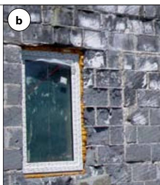
Fot. 17 | Uszkodzenia korozyjne muru spowodowane brakiem zabezpieczenia po wybudowaniu: a) widok budynku, b) i c) szczegóły uszkodzeń (fot. Z. Pająk)
