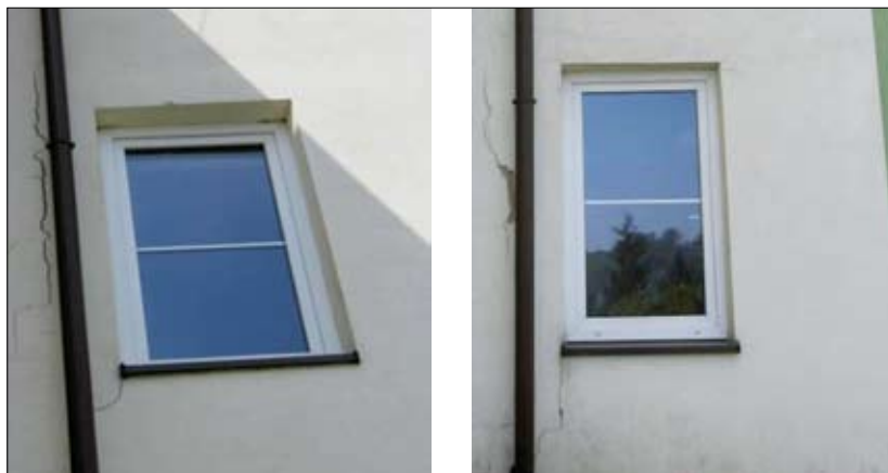
Fot. 1 | Zarysowania ścianki koło okna na skutek zmiany materiału podczas wznoszenia
