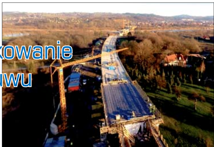
Obiekt MD-7, Nowy Sącz. Realizacja: Przedsiębiorstwo Usług Technicznych „INTERCOR”
