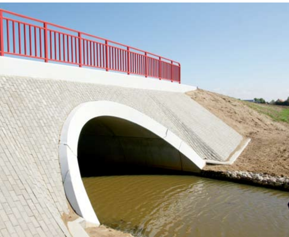
Fot. 2 | Nowe mosty w ciągu DK 37 w Darłowie
