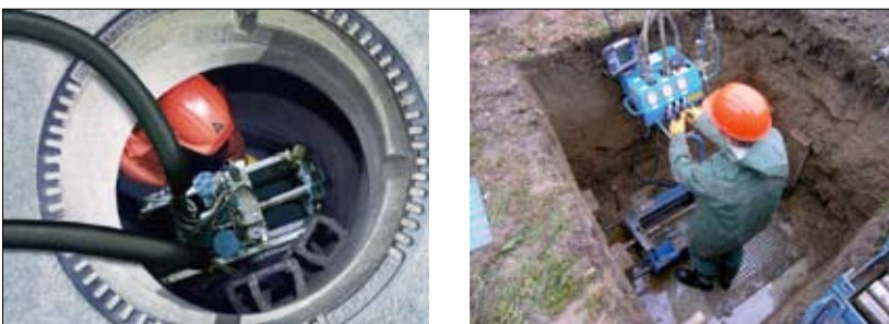
Fot. 2 | Budowa przykanalika w technologii przewiertu sterowanego ze studzienki kanalizacyjnej lub wykopu punktowego [2]
