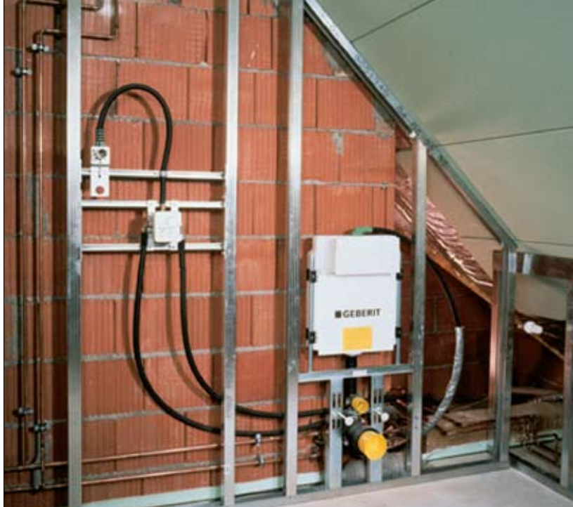
Fot. 2 | Przedścianka instalacyjna na poddaszu
