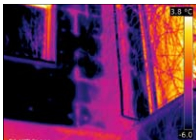
Fot. 11 | Typowe błędy – uszkodzona elewacja budynku w wyniku przeciekania tarasu
