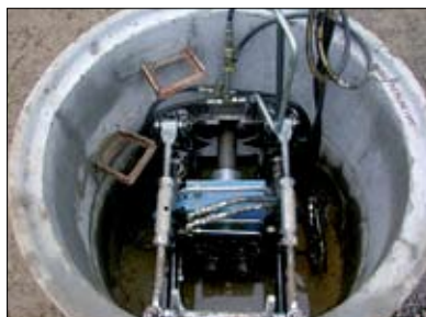
Fot. 8 | Wiertnica w wykopie początkowym, obudowanym kręgami betonowymi [2]
