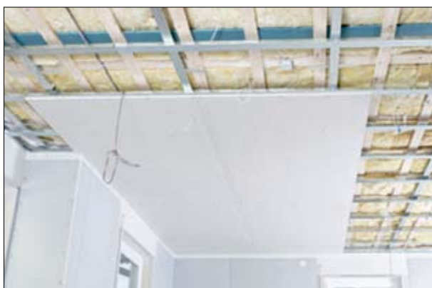
Fot. 5 | Konstrukcja sufitu podwieszanego
