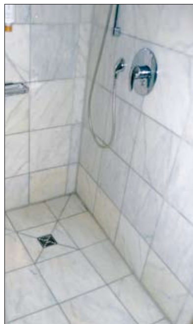
Fot. 1 | Kabina natryskowa z okładziną z kamieni naturalnych – klasyczny przykład pomieszczenia, które wymaga uszczelnienia zespolonego (fot. autor)
