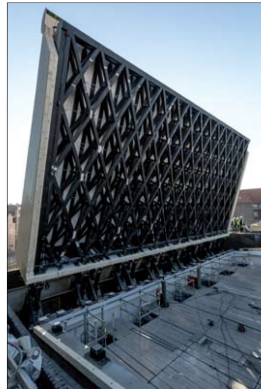
Fot. 41 Otwarta połąć dachu podczas robót wykończeniowych, 12 marca 2014 r. (materiały prasowe NDI)
