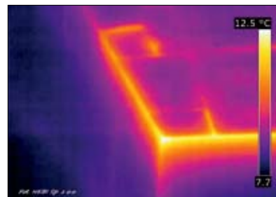
Fot. 10 | Typowe błędy – nieszczelność ułożenia płyt styropianowych
