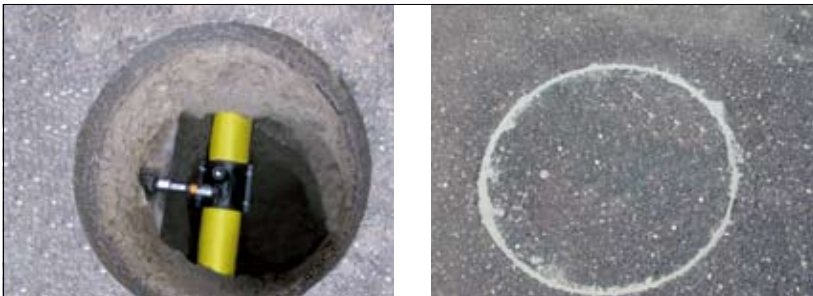
Fot. 7 | Montaż armatury oraz zasypianie wykopu [2]
