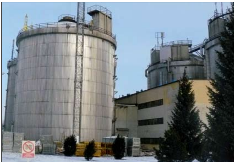
Fot. 5 | Cylindryczne komory fermentacyjne w oczyszczalni ścieków
