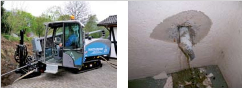
Fot. 1 | Przewiert horizontalny HDD [2]
