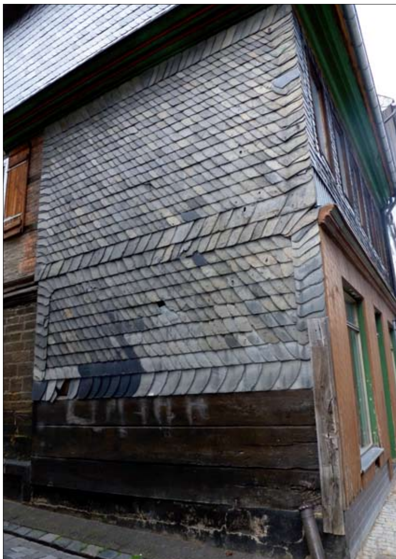
Fot. 2 | Pokrycie łupkiem na dachu i ścianie
