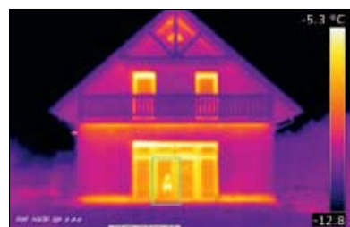
Fot. 1 | Odbicie w oknie osoby wykonującej badanie, stojącej w odległości ok. 25 m od budynku
