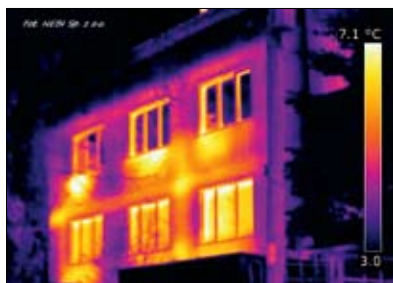
Fot. 8 | Typowe błędy – mostki cieplne na elewacji budynku
