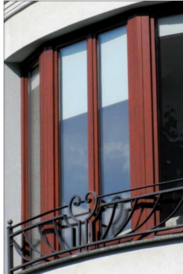
Fot. 2 | Balustrada mosiężna typu portfenetr (fot. A. Pluta)
