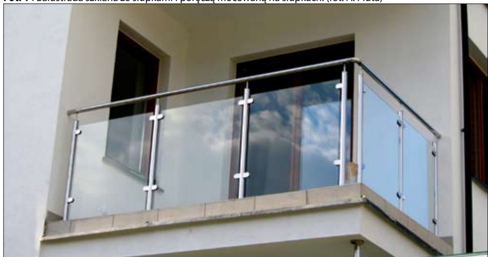
Fot. 1 | Balustrada szklana ze słupkami i poręczą mocowaną na słupkach. (fot. A. Pluta)
