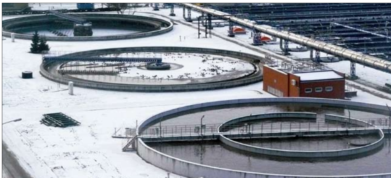
Fot. 4 | Cylindryczne osadniki w oczyszczalni ścieków
