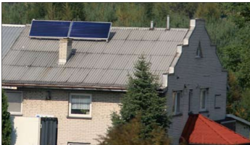
Fot. 1 | Przykład paneli zamocowanych na dachu budynku
