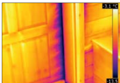
Fot. 12 | Nieszczelności stolarki – przewiewy
