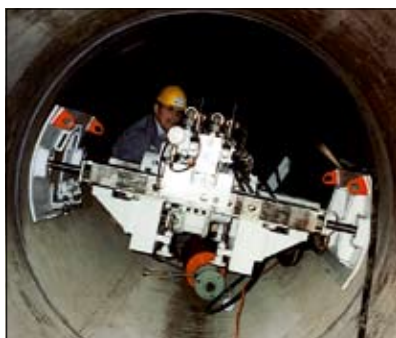
Fot. 9 | Budowa przykanalika z wnętrza kolektora [1]
