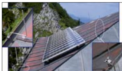
Fot. 3 | Przykład ochrony paneli PV na dachu z metalowym pokryciem
