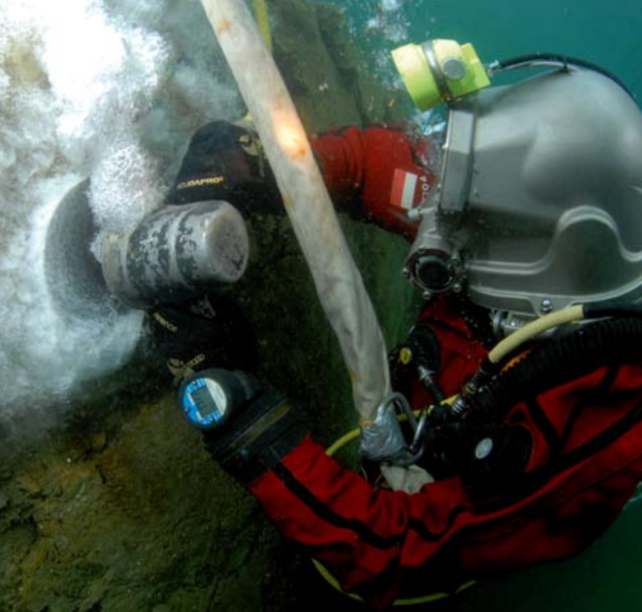
Fot. 3 | Nurek operujący szlifierką pneumatyczną
