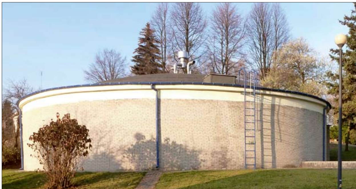
Fot. 1 | Cylindryczny zbiornik wody przekryty kopułą
