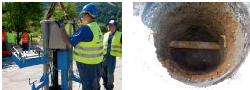
Fot. 5 | Wykonanie przewiertu [2]
