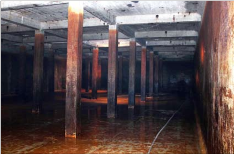
Fot. 2 | Wnętrze prostopadłościennego zbiornika na wodę, przekrytego stropem płytowo-żelaznym
