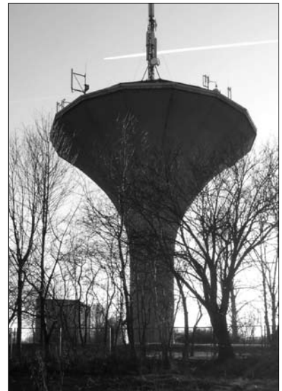
Fot. 3 | Wieża ciśnieniowa o konstrukcji powłokowej
