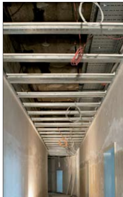
Fot. 4 | Sufit przęsłowy
