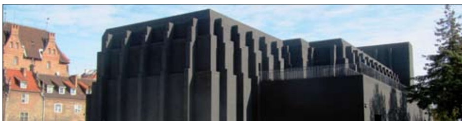
Fot. 1 | Bryła budowli od strony południowej. Elewacja zmienia barwę w zależności od oświetlenia
