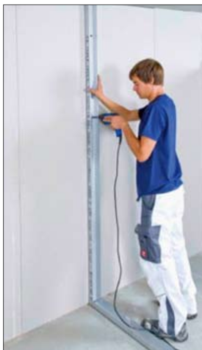
Fot. 6 | Mocowanie profili obwodowych
