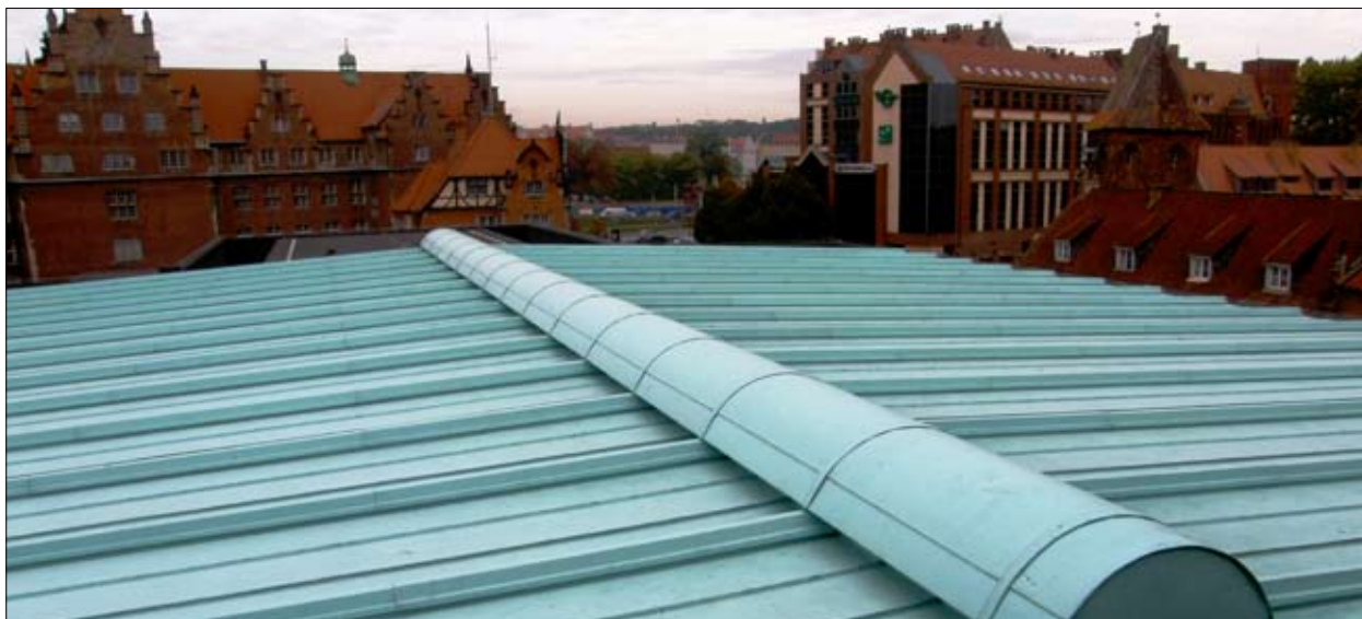
Fot. 7 | Otwierany dach pokrywa miedziana blacha ze sztuczną patyną
