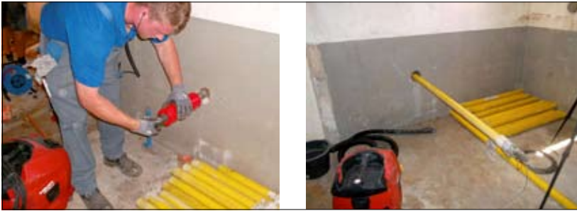
Fot. 6 | Poszerzanie otworu wraz z wprowadzaniem rur przewodowych [2]
