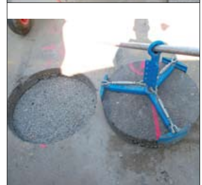
Fot. 3 | Wycinanie rdzenia z nawierzchni ulicznej [2]
