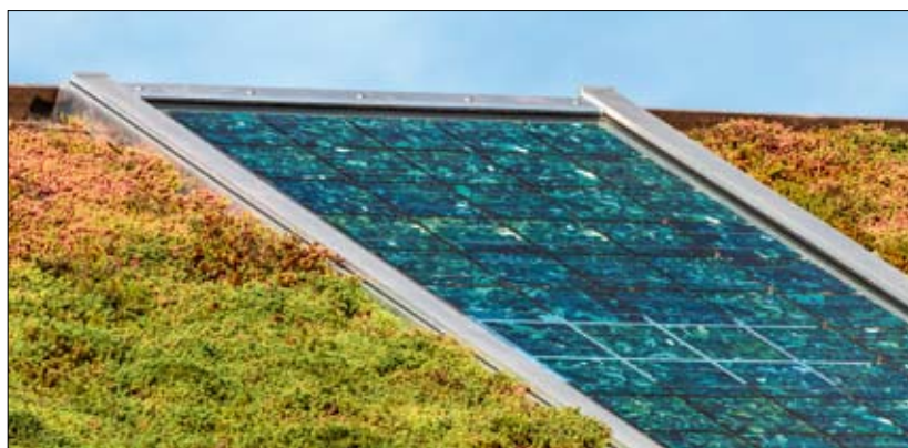
Fot. 4 | Panele fotowoltaiczne na zielonym dachu
