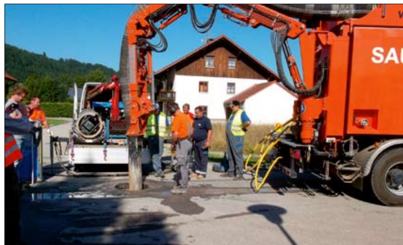
Fot. 4 | Usuwanie gruntu za pomocą koparki ssącej [2]
