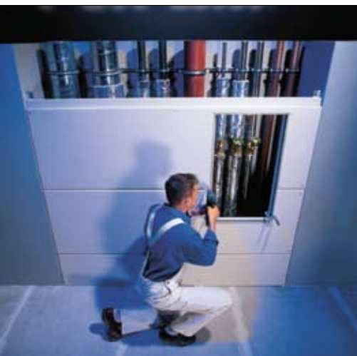
Fot. 3 | Obudowa szybu instalacyjnego
