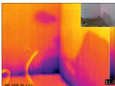
Fot. 7 | Przykłady problemów związanych ze źle wykonaną hydroizolacją fundamentów – brak prawidłowej hydroizolacji fundamentów
