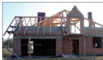
Fot. 1 | Budynek mieszkalny jednorodzinny podczas montażu krokwi
