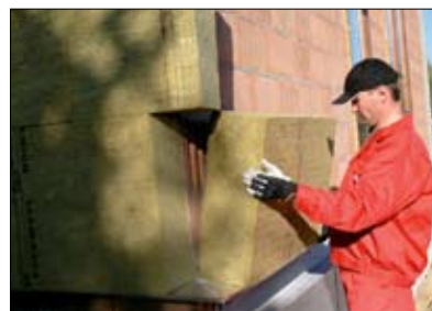
Fot. Montaż izolacji – przyklejanie płyty z wełny mineralnej (MW) do podłoża
