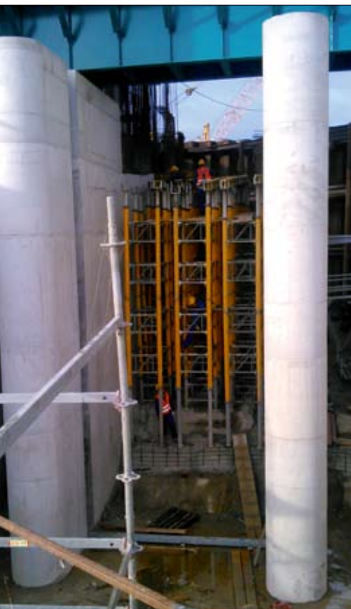
Fot. 2 | Budowla zrzutowa, sekcja upustów dennych
