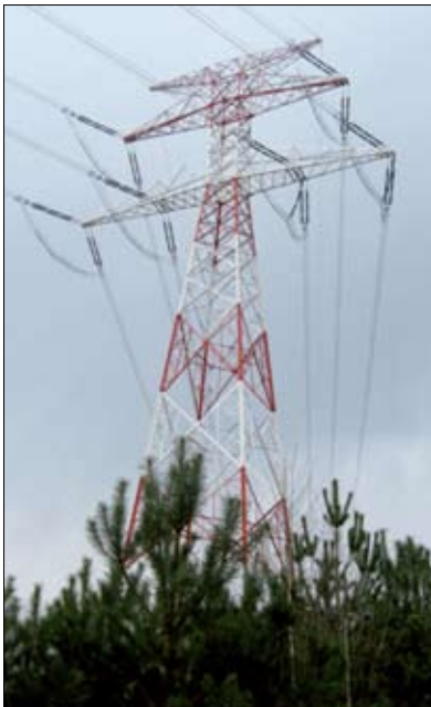
Fot. 1 | Słup energetyczny na załamaniu linii, taka konstrukcja generuje duże siły poziome
