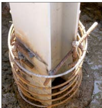
Fot. 10 | Słup stalowy osadzony w zbrojeniu pala
