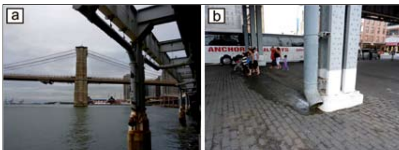
Fot. 1 | Przykład odprowadzenia wody z estakady wjazdowej Manhattan Bridge (USA) bezpośrednio z rur spustowych: a) do rzeki Hudson, b) na poziom ciągu pieszego pod estakadami
