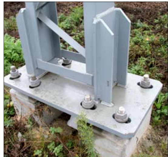
Fot. 16 | Przykład bramownicy sieci trakcyjnej posadowionej na palach prefabrykowanych. Widoczne otwory do regulacji położenia w planie
