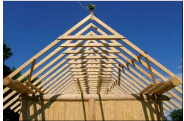
Fot. 3 | Więźba dachowa jętkowa wykonana na budynku z bali drewnianych
