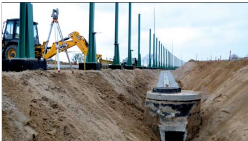
Fot. 12 | Fundamenty ekranów usytuowane na krawędzi skarpy
