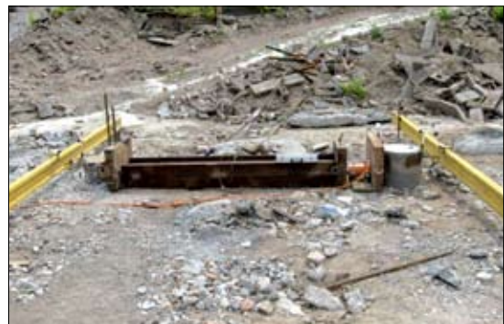
Fot. 6 | Przykład badań porównawczych – próbné obciążenie na siły poziome dwóch różnych rodzajów pali rozpartych między sobą
