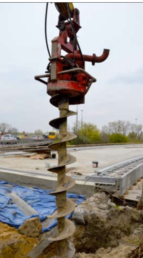
Fot. 8 | Świder CFA zamontowany na koparce z rurą rdzeniową do podawania mieszanki betonowej
