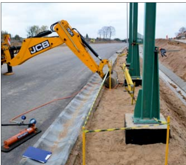
Fot. 14 | Przykład wykorzystania koparki w celu zapewnienia konstrukcji oporowej do próbnego obciążenia. Siła przyłożona jest w najbardziej niekorzystną stronę – w kierunku skarpy
