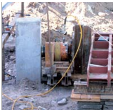
Fot. 5 | Próbné obciążenie pala – siła pozioma wywierana przez siłownik oparty na dwóch sąsiednich palach
