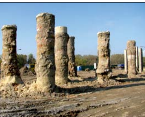
Fot. 4 | Przykład pali wielkośrednicowych, jakie przenosiły obciążenia pionowe z konstrukcji dachu. Na fotografii pale testowe, które zostały odkopane w związku z obniżeniem platformy roboczej
