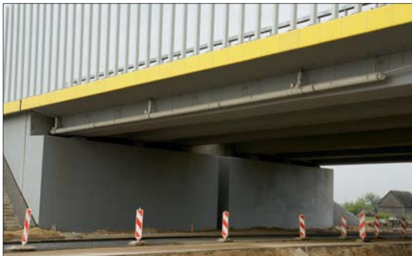
Fot. 2 | Przykładowe rozwiązanie przeprowadzenia kolektora spustowego przez przyczółek do odwodnienia wgłębego w wiadukcie w ciągu drogi ekspresowej S8
