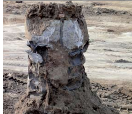
Fot. 15 | Widok odkopanego fundamentu. Widoczne docięnięcie gruntu do szkieletu zbrojeniowego
