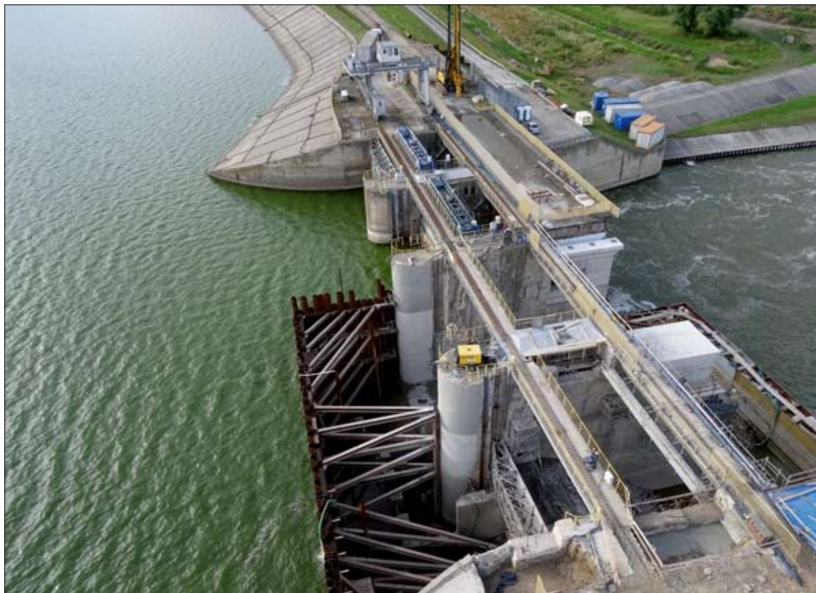
Fot. 1 Budowla zrzutowa
