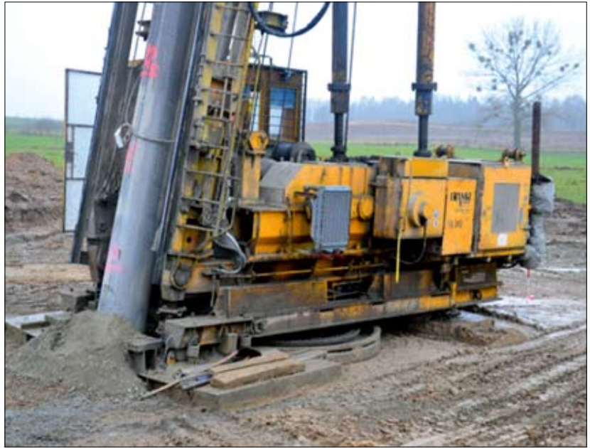
Fot. 7 | Wbijanie ukośnych pali Franki NG pod fundament wiatraka
