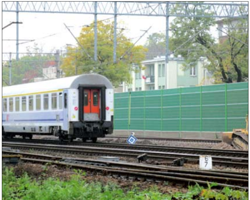
Fot. 2 | Ekran akustyczny przy linii kolejowej, którego fundamenty przenoszą siły poziome wynikające z parcia wiatru, i bramownica sieci trakcyjnej obciążona naciągiem lin
