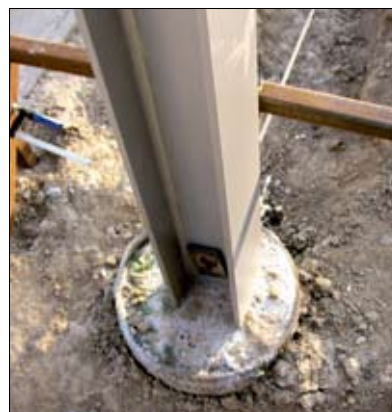
Fot. 11 | Słup ekranu zabetonowany w zwieńczeniu pala
