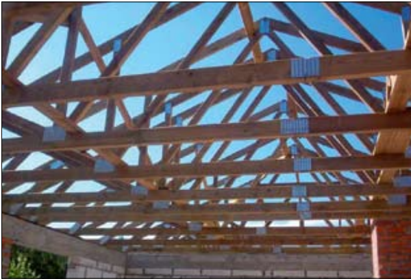
Fot. 2 | Dźwigary drewniane kratownicowe po ustawieniu na ścianach
