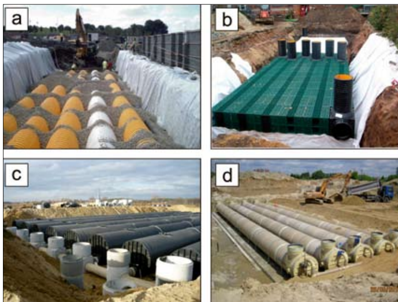
Fot. 3 | Technologie i materiały stosowane w konstrukcjach elementów zbiorczych różnych systemów odwodnienia wgłębnego obiektów mostowych: I funkcja rozsączania: a) tunele rozsączające z polipropylenu, b) skrzynki rozsączające z polipropylenu; II funkcja retencyjna wody: c) zbiorniki retencyjne z blach falistych, d) zbiorniki retencyjne z kompozytów CC-GRP
