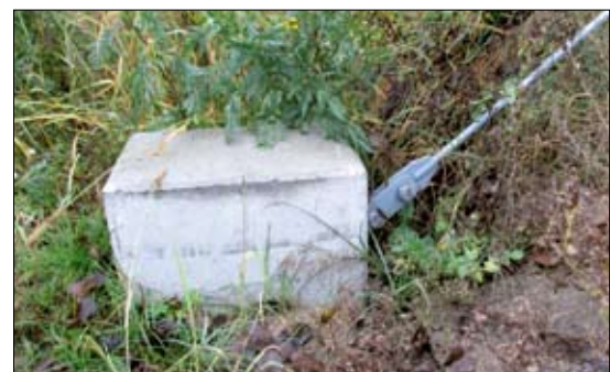
Fot. 17 | Pal odciągowy do słupa trakcyjnego
