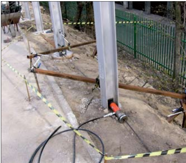
Fot. 13 | Próbné obciążenie pali za pomocą ściągu
