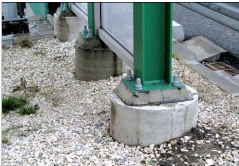
Fot. 9 | Przykład słupa ekranu akustycznego przykręconego do zwieńczenia pala
