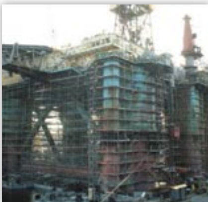
Rusztowanie modułowe i ramowe, Wieża Wiertnicza – Gdańska Stocznia Remontowa
