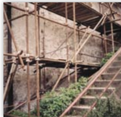
Rusztowanie rurowo złączkowe
