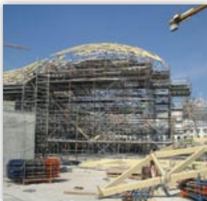
Rusztowania modułowe – Budowa Złote Tarasy w Warszawie
