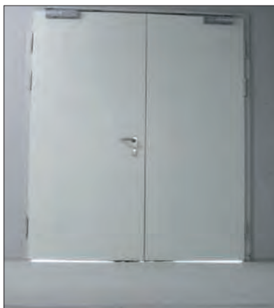
Fot. 9 | Prześwit pod drzwiami akustycznymi
