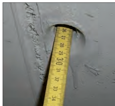
Fot. 1 | Przejście łącznika szalunkowego
