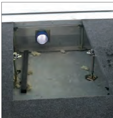
Fot. 11 | Przejście instalacyjne pod podłogą studia telewizyjnego
