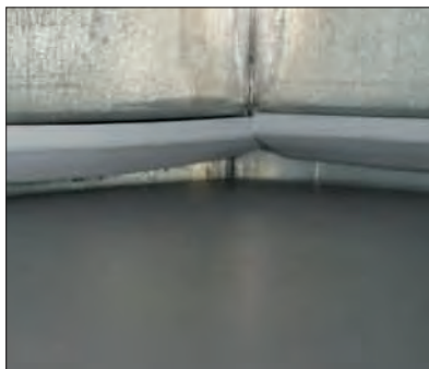
Fot. 7 | Braki przylegania skrzydła drzwi do uszczelki
