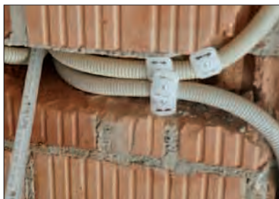
Fot. 10 | Podkucia ściany dla instalacji elektrycznych
