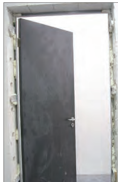
Fot. 6 | Liczne braki wypełnienia ościeżnicy kątowej
