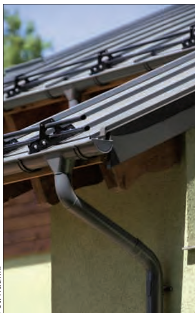
Fot. 1 | System rynnowy ze stali powlekanej
