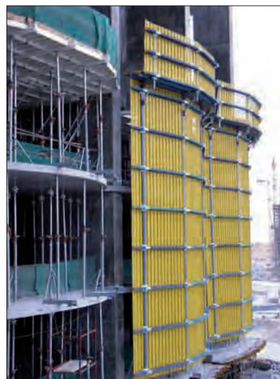
Fot. 2 | Osłona Xclimb
