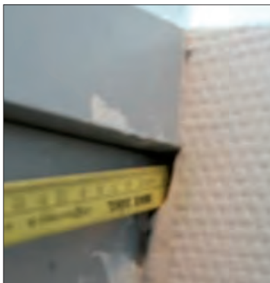
Fot. 15 | Braki w gotowej przegrodzie akustycznej na styku z elewacją
