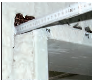
Fot. 4 | Brak pełnego wypełnienia ościeża
