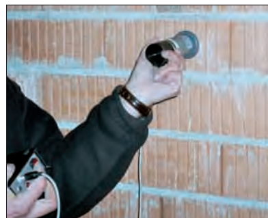
Fot. 3 | Pomiary akustyczne przegrody bez wypełnionych spoin pionowych
