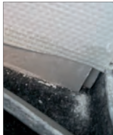
Fot. 13 | Braki w wypełnieniu przegrody akustycznej na styku z podłogą
