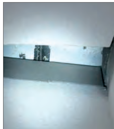
Fot. 14 | Braki w gotowej przegrodzie akustycznej na styku ze stropem
