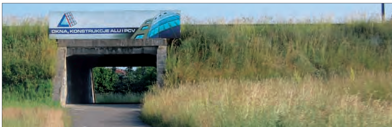
Fot. 1 | Skrzynkowe przejście pod nasypem
