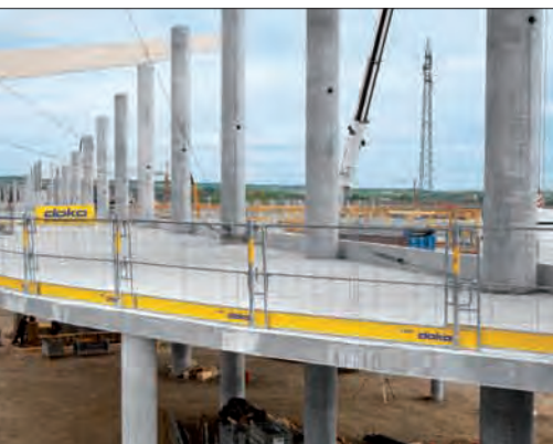
Fot. 1 | Obarierowanie gotowego stropu
