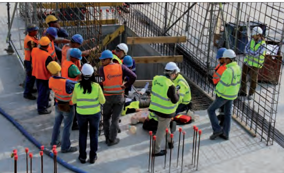
Fot. 3 | Na budowie Warbudu odbyły się ćwiczenia z udzielania pierwszej pomocy
