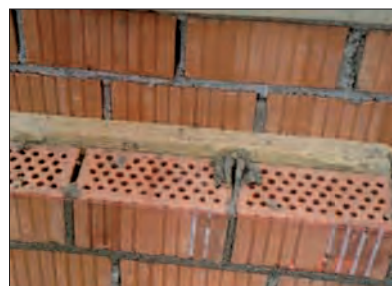
Fot. 2 | Brak wypełnienia zaprawą spoiny oraz zaprawa w styku płyt izolacji akustycznej
