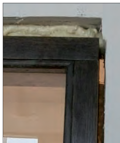
Fot. 16 | Braki w wypełnieniu przegrody akustycznej niewłaściwą wełną mineralną
