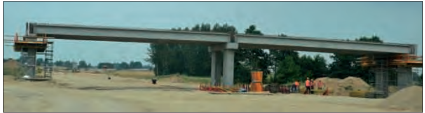
Fot. 4 | Obiekt mostowy wykonany w całości przed wykonaniem nasypów
