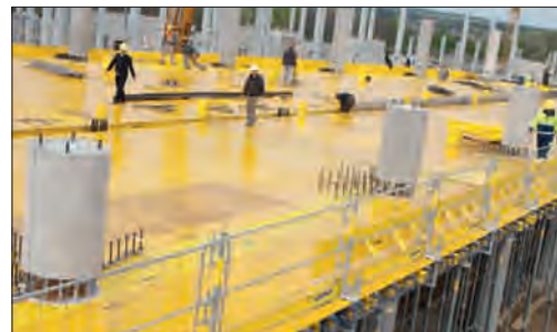
Fot. 3 | Obarierowanie deskowania
