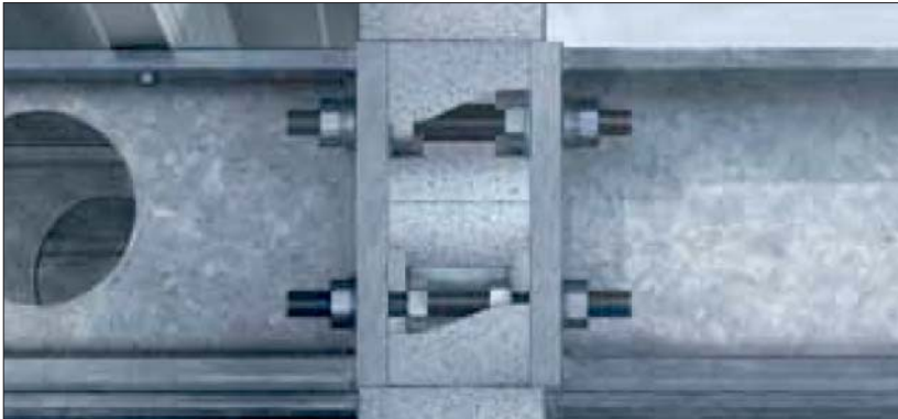
Fot. 2 | Łącznik termiczny stal-stal [5]
