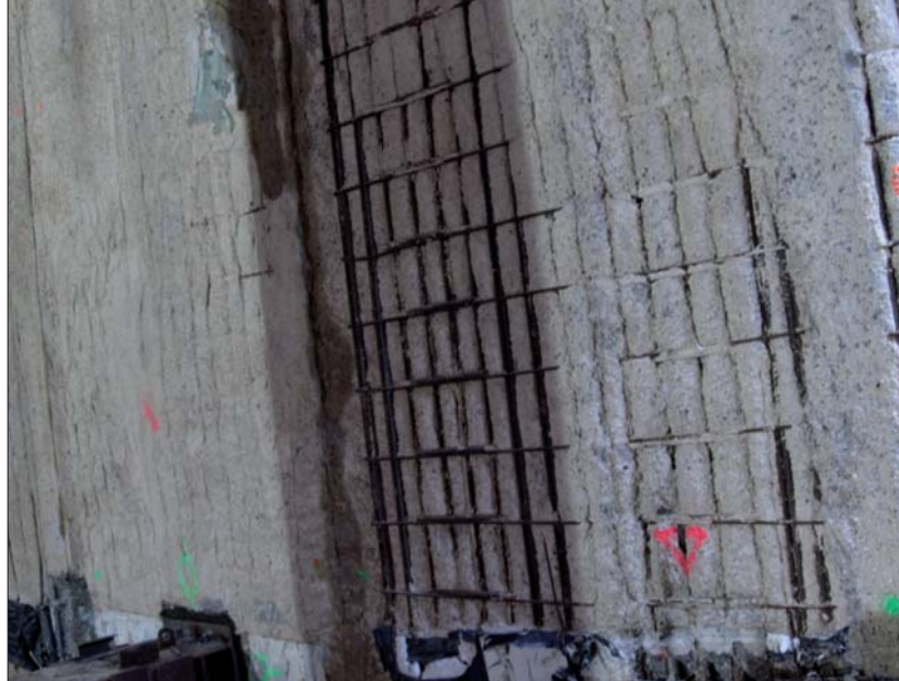
Fot. 2 | Przykład skutków betonowania ściany szczelinowej zbyt gęstą mieszanką (fot. K. Grzegorzewicz)
