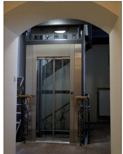
Fot. 6 | Gotowy dźwig (żeliwny spocznik jeszcze przed renowacją
