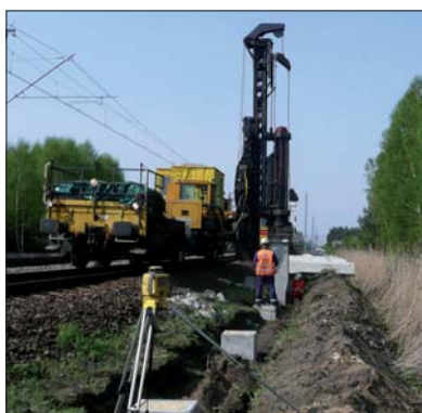
Fot. 5 | Wbijanie pali ekranowych z toru
