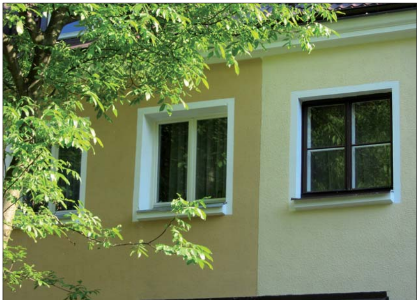
Fot. 1 | Tynk o fakturze zacieranej, chropowatej (fot. A. Pluta)
