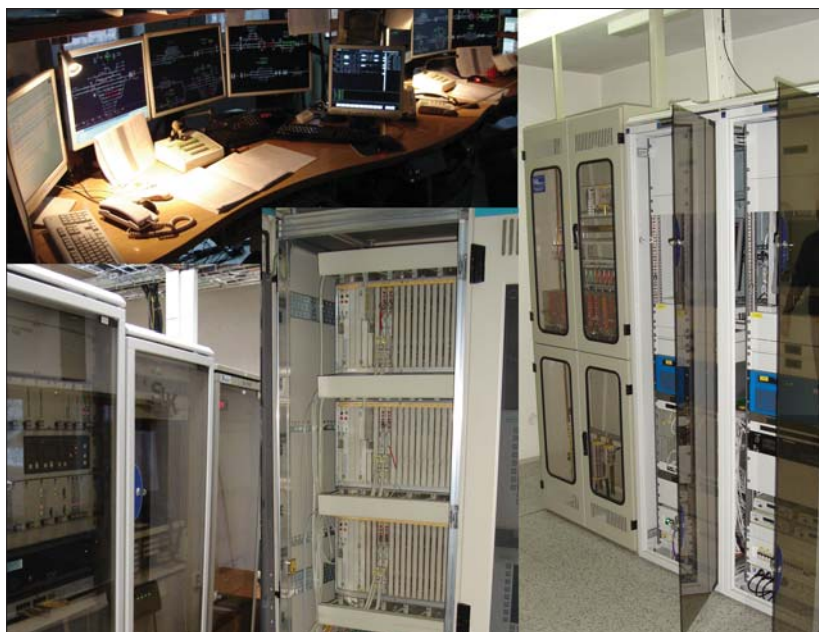
Fot. 2 | Elementy systemu SIMIS-W, stacja Żywiec
