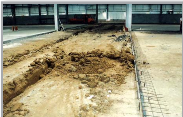
Fot. Stabilizacja w technologii „envtech” gruntu gliniastego
