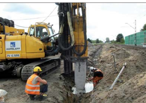
Fot. 2 | Pogrążanie pali trakcyjnych z terenu przyległego
