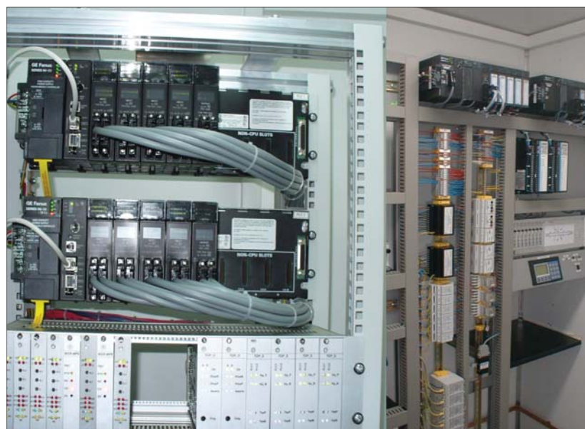
Fot. 5 | Przykładowy układ przetwarzania „2z2” oraz wnętrze kontenera
