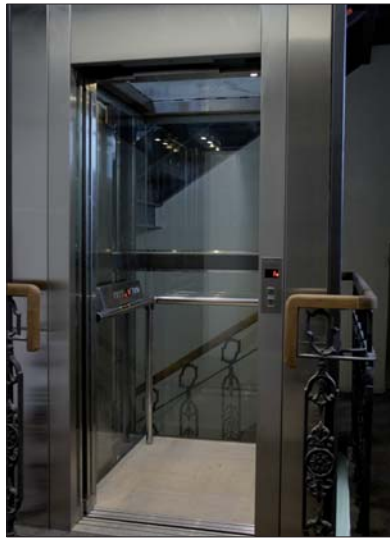
Fot. 5 | Kabina dźwigu
