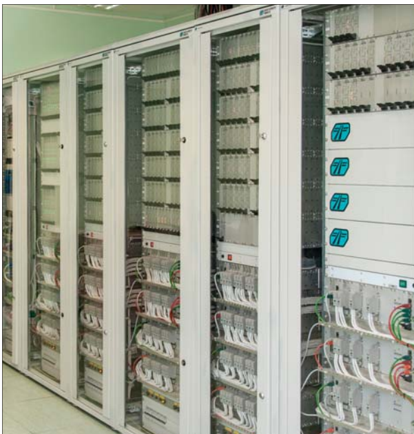
Fot. 3 | Elementy systemu MOR-3
