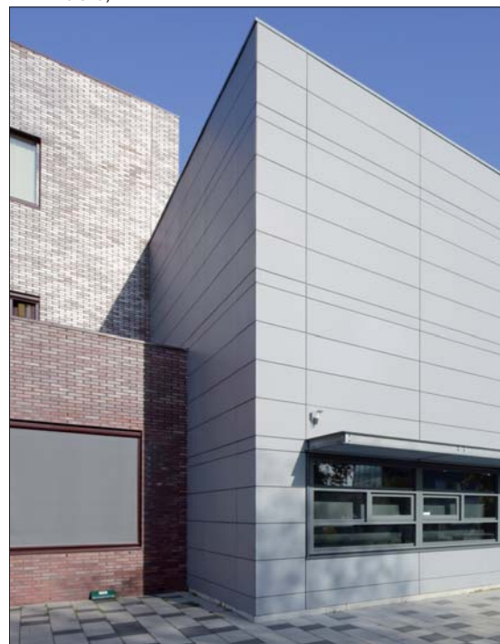
Fot. 1 Dom w Amsterdamie z elewacją z płyt włóknisto-cementowych (fot. archiwum firmy Etex Building Materials Polska)
