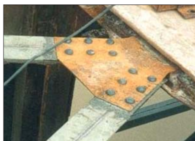
Rys. 5 | Przykład połączenia śrubowo-klejowego [2]
