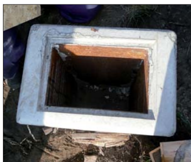
Fot. 4 | Prefabrykat ekranowy z gniazdem
