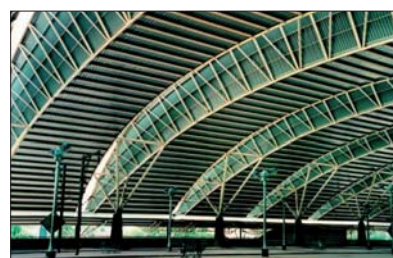
Fot. 1 | Przekrycie peronów w Navi Mumbai, Indie, wg projektu Architects Hafeez Contractor (architektura) i Sterling Engineering Pvt. Ltd (konstrukcja) [5]
