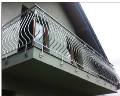
Fot. 3 | Zalecany sposób montażu balustrad ażurowych [7]
