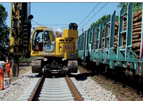
Fot. 1 | Pogrążanie pali trakcyjnych z toru
