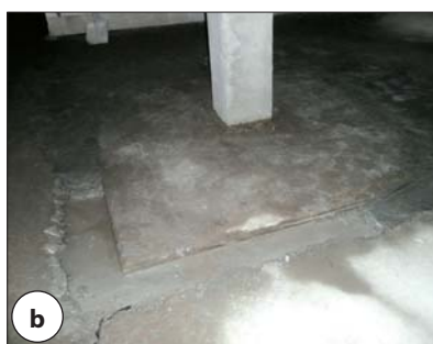
Fot. 4 | Skutki bezmyślności i stosowania niekompatybilnych materiałów
