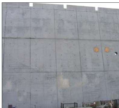
Fot. 5 | Nierówne i zbyt grube warstwy w budowywanej mieszanki betonowej, nierównomiernie nałożony preparat antyadhezyjny
