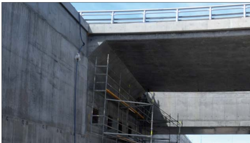
Fot. 6 | Dojazd do tunelu w technologii ścian szczelinowych – widoczna żelbetowa szczelna „wanna” wykonana od wewnątrz
