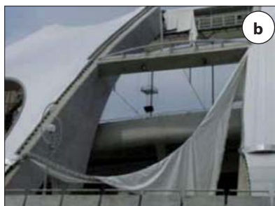
Rys. 3 | Pierścieniowo-linowe przekrycie stadionu w Busan, Korea Płd. [7]: a) przekrój poprzeczny konstrukcji przekrycia trybun z pierścieniem zewnętrznym spoczywającym na 48 żelbetonowych pochylonych słupach, b) widok zerwanej membrany w dolnej części słupów po przejściu tajfunu 28 lutego 2005 r.
