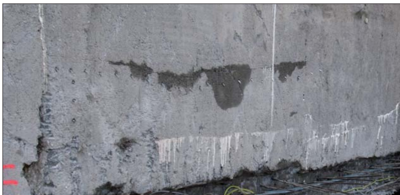
Fot. 6 | Dojazd do tunelu w technologii ścian szczelinowych – widoczna żelbetowa szczelna „wanna” wykonana od wewnątrz
