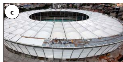
Rys. 2 | Przekrycie pierścieniowo-linowe areny Stadionu Fonte Nova w Salvador da Baia, Brazylia [18] o wymiarach 258 × 216 m i pojemności trybun 50 000 widzów, projekt: Schulitz + Partner Architekten BDA, Braunschweig (architektura) i RFR Ingenieure GmbH, Stuttgart: a) przekrój poprzeczny konstrukcji przekrycia, b) szczebel obwodowego pierścienia ściskanego, c) widok stadionu z lotu ptaka (fot. Manu Dias/World Cup Portal/Associated Press)
