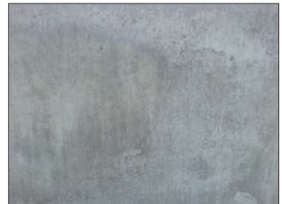
Fot. 2 | Efekt nierównomiernie rozłożonego środka antyadhezyjnego
