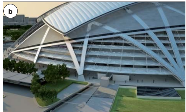
Fot. 7 Stadion Narodowy w Singapurze o pojemności 55 tys. widzów, przekryty kopułą o największej w świecie rozpiętości 312 m i wysokości od niecki 80 m, ze środkową częścią ruchomą; konstrukcja ma wysokość 5 m na górze i 2,5 m przy podstawie, konstrukcję zaprojektowała firma Arup Associates; do eksploatacji zostanie stadion oddany w 2014 r. [23]: a) model parametryczny przekrycia, b) wizualizacja części ruchomej przekrycia
