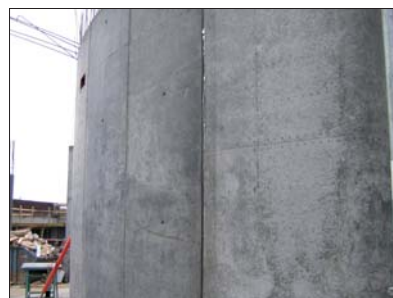
Fot. 3 | Różnicowanie właściwości mieszanki betonowej w zakresie zawartości wody zarobowej (wskaźnik w/c)
