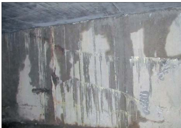
Fot. 2 | Rozwarte naroże ściany szczelinowej – widoczne przecieki
