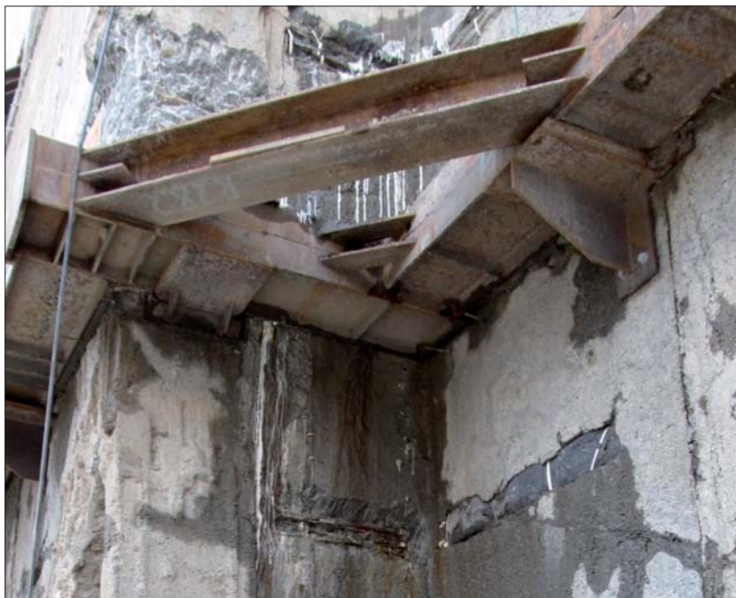
Fot. 2 | Rozwarte naroże ściany szczelinowej – widoczne przecieki
