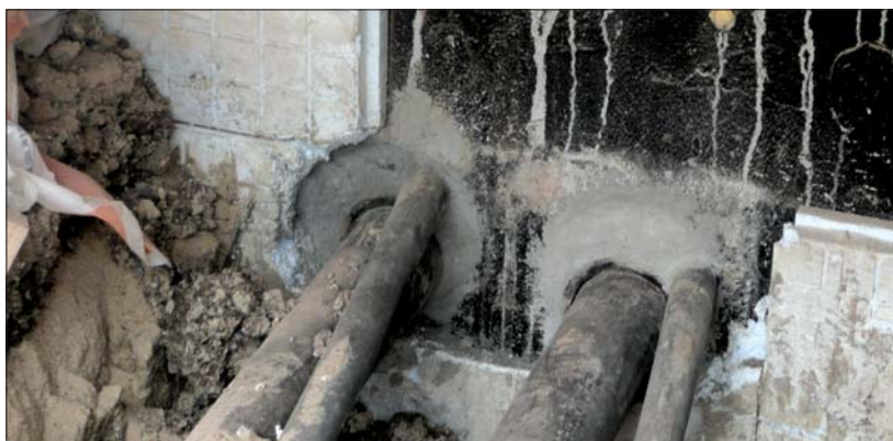
Fot. 3 | Bezmyślne „uszczelnienie” przejść rurowych
