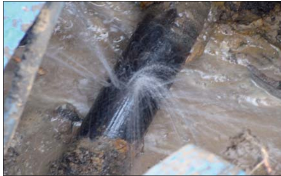
Awaria na przyłączy wody – pęknięcie obwodowe rury stalowej
