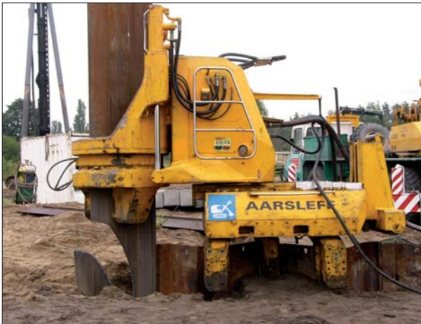
Fot. 6 | Urządzenie do statycznego wciskania ścianki stalowej. W czasie pracy maszyna zakotwiona jest do wykonanych wcześniej elementów
