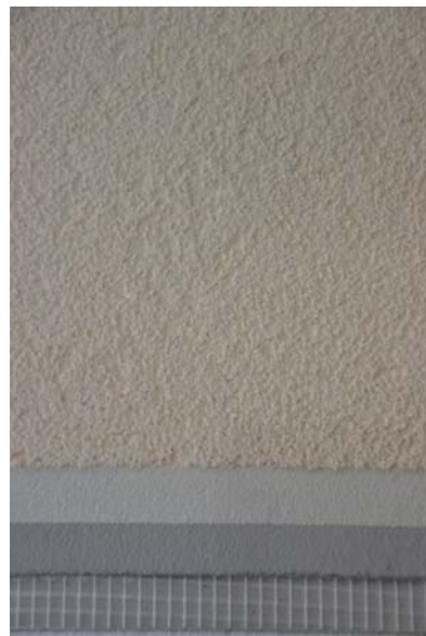
Fot. 3 | Przekrój docieplania
