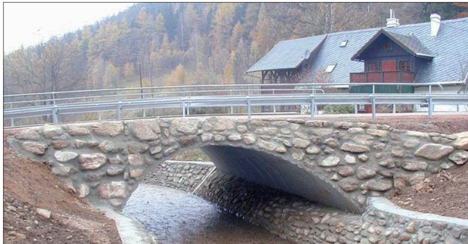
Fot. 4 | Przykład elewacji obiektu gruntowo-powłokowego z blach falistych
