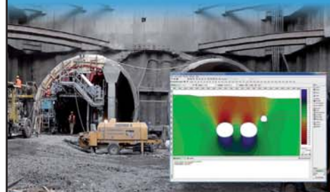
MES - tunel - przepływ wody
