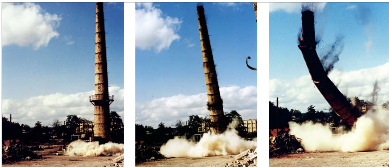
Fot. 6, 7, 8 | Wyburzanie komina ceglanoego w Turku
