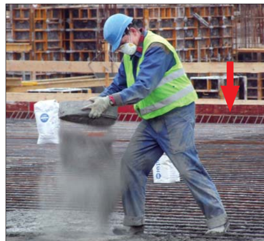
Fot. 1 | Ekspresowe uszczelnianie patio przez zacieranie izolacji krystalizującej w trakcie betonowania, Kraków, kompleks wielorodzinny
