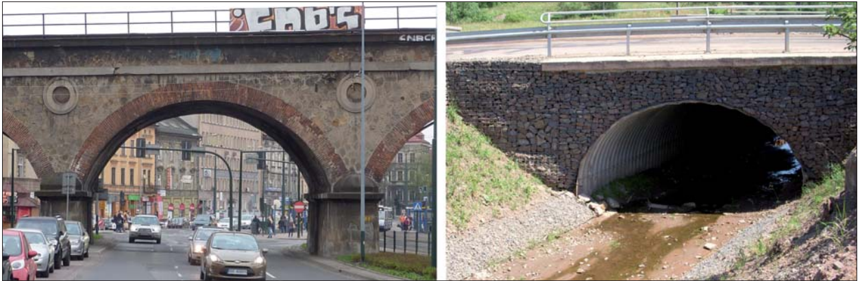
Fot. 1 | Przykłady wiaduktu sklepionego i konstrukcji gruntowo-powłokowej
