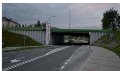
Fot. 12 | Wiadukt zintegrowany w Rzeszowie, przyczółki i skrzydełka wykonane ze ścianek stalowych
