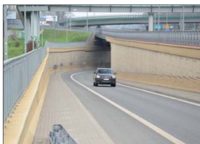
Fot. 13 | Ściany oporowe wykonane ze ścianek stalowych trwałych
