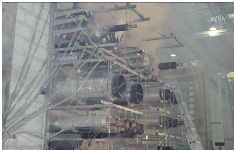
Fot. 1 | Weryfikacja szczelności i izolacyjności ogniowej przejść instalacyjnych – widok podczas próby (badania własne ITB)
