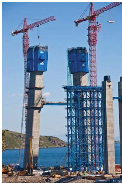
Fot. 3 | System samowznoszący SCF firmy Harsco Infrastructure (Hunnebeck) [7]
