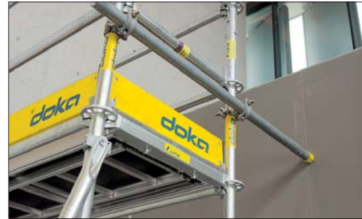
Fot. I Punkty oparcia rusztowania zbrojarskiego wykonuje się z rur połączonych ze stojakami za pomocą złączy krzyżowych
