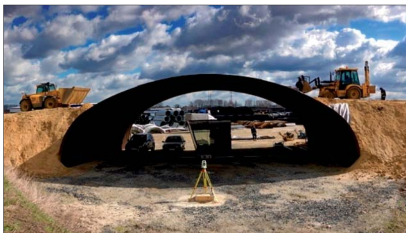
Fot. 8 | Faza pośrednia układania zasyпки gruntowej
