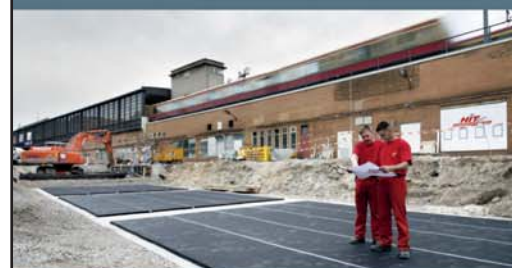
Izolacje od drgań fundamentów budynków
