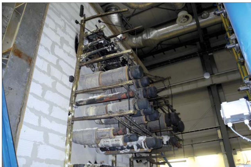
Fot. 2 | Widok przejść instalacyjnych po badaniu (badania własne ITB)
