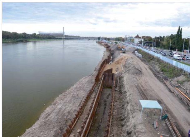
Fot. 3 | Bulwary Wiślane w Warszawie zabezpieczone ściankami stalowymi
