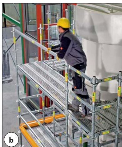
Fot. 2 a, b | System rusztowań PERI UP Rosett Flex
