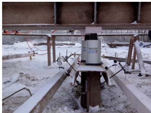
Fot. 14 | Konstrukcja do próbnego obciążenia ścianki stalowej na wciskanie
