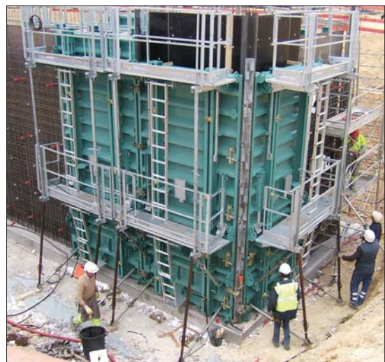
Fot. 2 | System NOE-mega pozwala na wykorzystanie gotowych modułów zaopatrzonej w pomosty z barierkami oraz drabinkami komunikacyjnymi [9]
