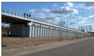
Fot. 11 | Ścianka stalowa stanowiąca trwały przyczółek oraz mury oporowe dojazdów do wiaduktu w Nowym Dworze Mazowieckim
