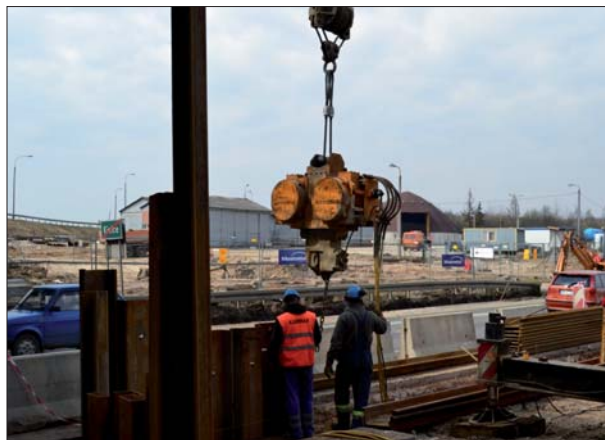
Fot. 4 | Pograżanie ścianek na budowie obwodnicy Kielc – budowa podpór
