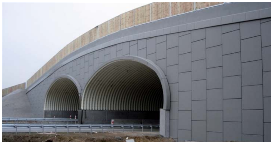
Fot. 5 | Prefabrykowana ściana oporowa
