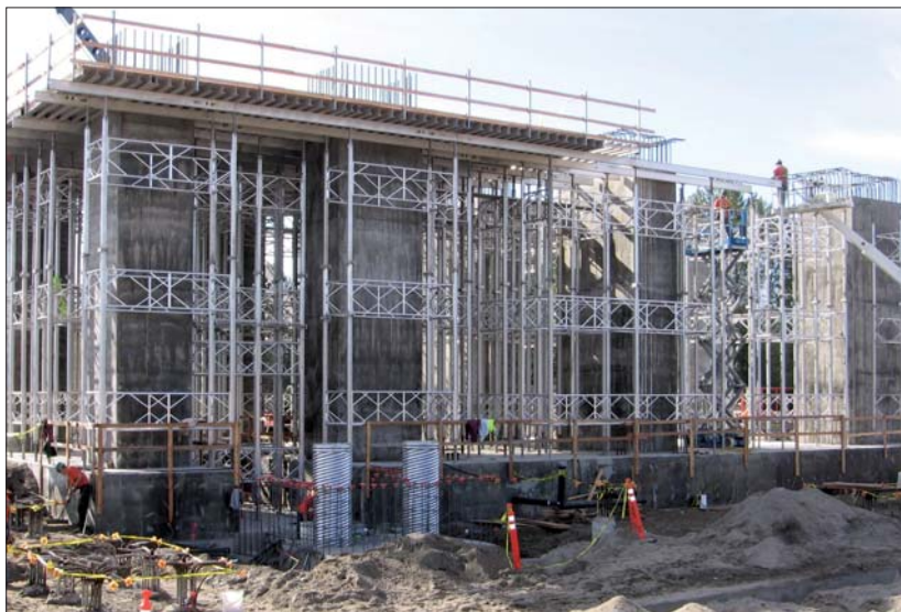
Fot. 1 | Zastosowanie lekkiego aluminiowego systemu Megashore w budownictwie inżynierskim [12]
