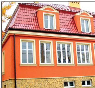
Fot. 1 | Stosowane w metodzie BSO tynki cienkowarstwowe występują w szerokiej gamie struktur i granulacji oraz w praktycznie nieograniczonej palecie kolorów
