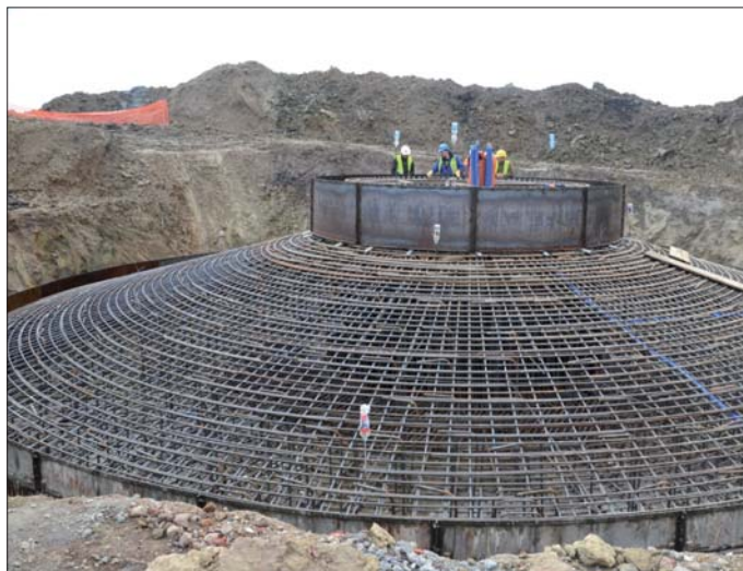
Fot. 2 | Przykład fundamentu turbiny wiatrowej posadowionej na palach Franki NG
