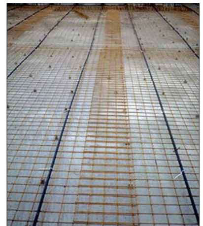
Fot. 3 | Sprężanie płyt betonowych za pomocą kabli [4]
