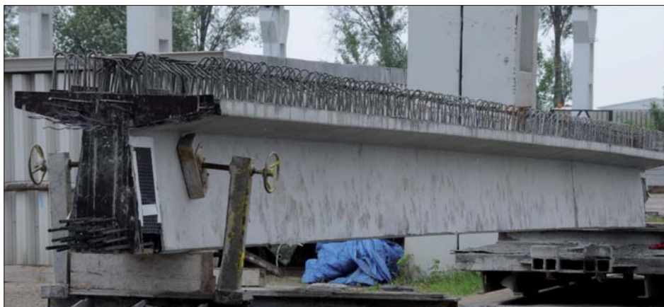
Fot. 4 | Prefabrykowana belka typu „Kujan”
