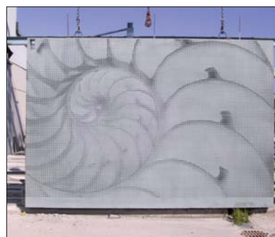
Fot. 3 | Element ścienny z betonu graficznego [5]
