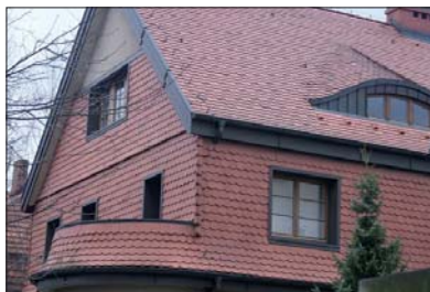
Fot. 3 | Dachówka ceramiczna karpiołka na ścianie i dachu
