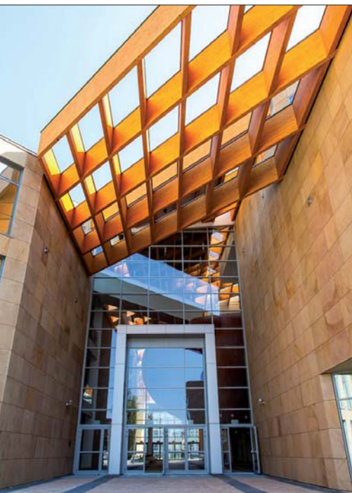
Fot. 4, 5 | Konstrukcja drewna klejonego zadaszenia budynku dydaktycznego dla uniwersyteckiego Centrum Innowacji i Nanotechnologii w Rzeszowie (źródło: www.andrewex.pl )
