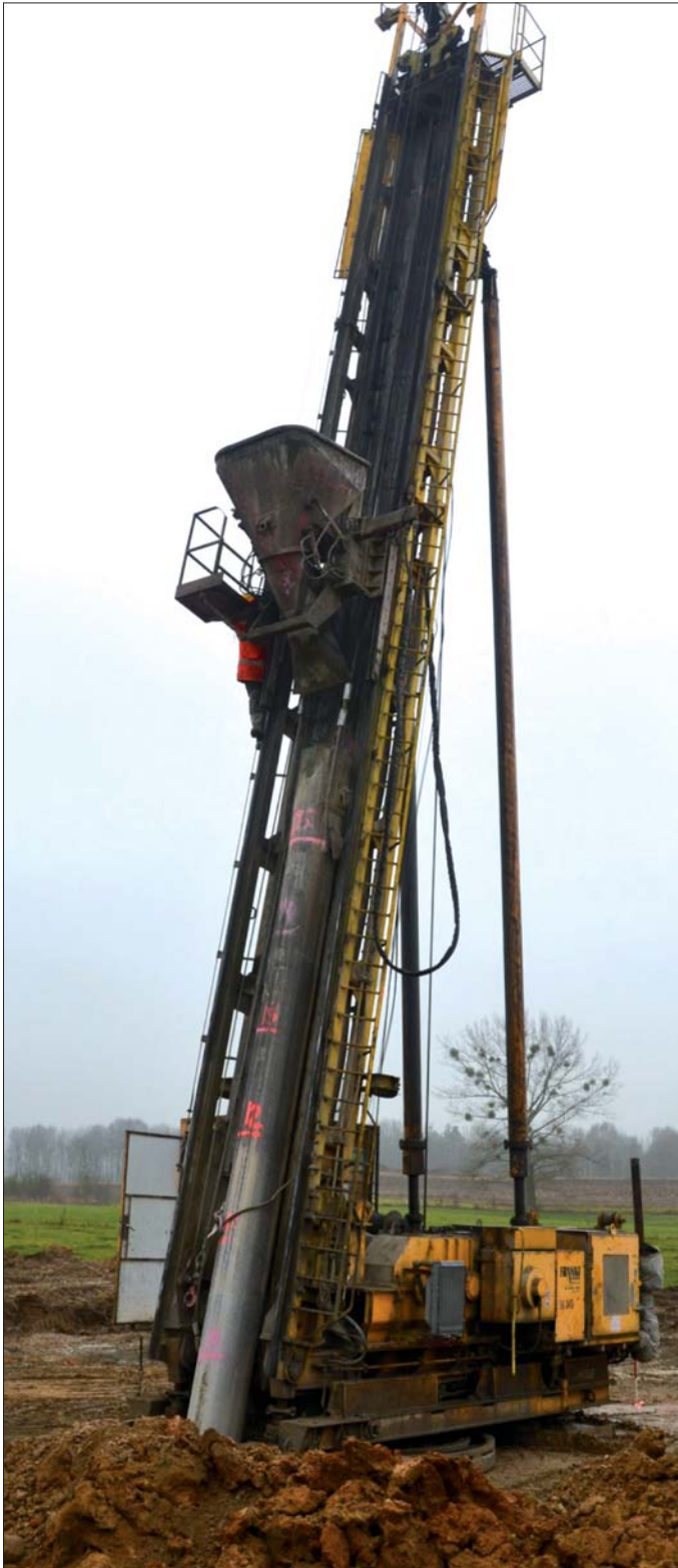
Fot. 3 | Wykonywanie pali pochylonych
