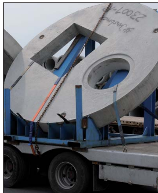
Fot. 3 | Transport prefabrykowanej pokrywy
