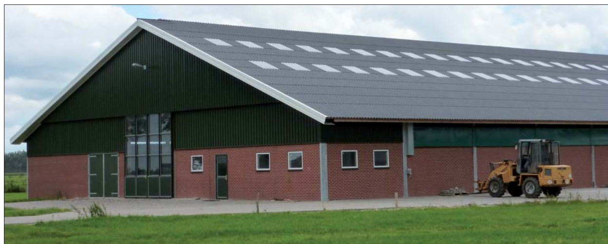
Fot. 5 | Blachy dachowe
