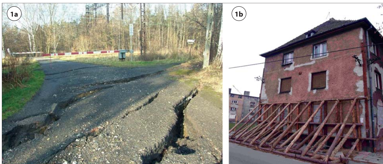
Fot. 1 a) obraz deformacji nieciągłych [10], b) wpływ nadmiernych deformacji ciągłych [6]
