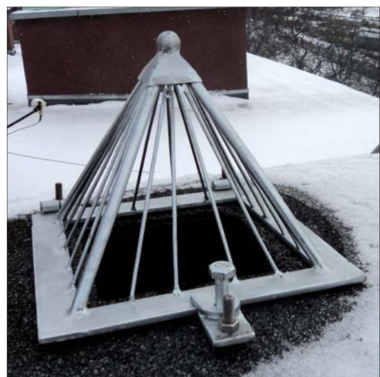
Fot. 1 | Przykład prawidłowego zabezpieczenia przewodu kominowego z wylotem górnym [1]
