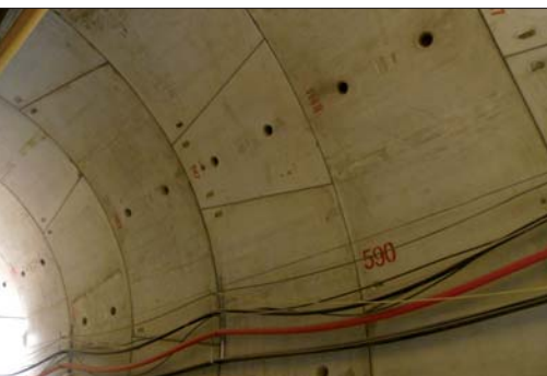
Fot. 6 | Obudowa tunelu – widoczne pojedyncze segmenty
