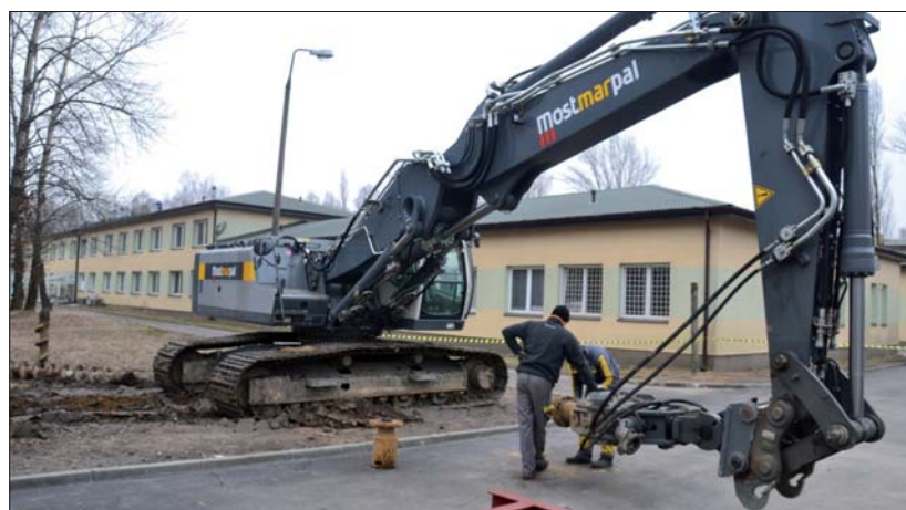
Fot. 5 Koparka umożliwiająca wykonanie pali CFA – widoczny wlot rury do podawania betonu
