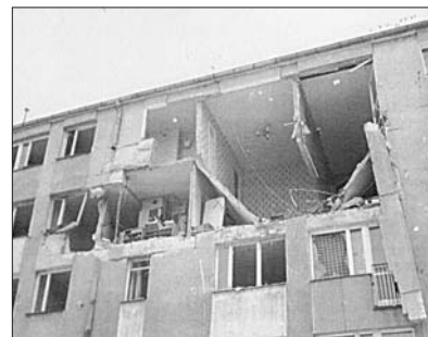
Fot. 4 | Budynek wielkopłytyowy po wybuchu gazu
