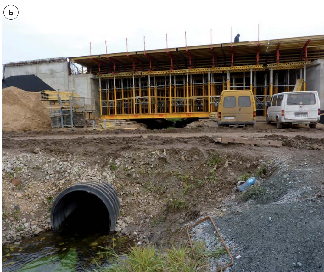
Fot. 5 | Odwodnienie dróg technologicznych: a) przykład braku odwodnienia, b) przykład wykonania odwodnienia z użyciem tymczasowego przepustu
