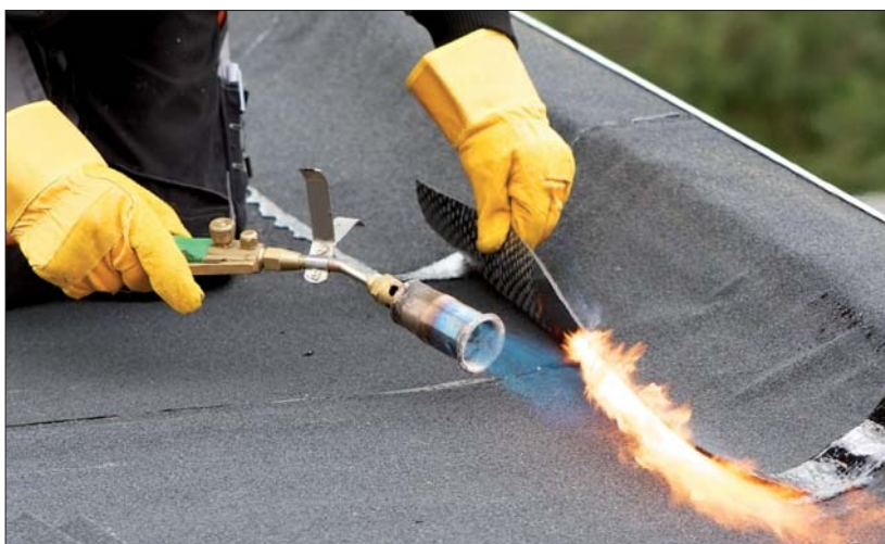
Fot. 2 | Krycie dachu papą
