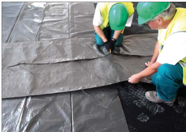
Ochrona Regupolu Ba dwuwarstwową folią PE
