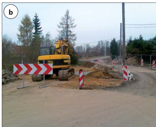
Fot. 1 | Przykłady zapewnienia przejeźdnosci z wykorzystaniem „bajpasa”: a) dla jednego kierunku ruchu, b) dla ruchu wahadłowego
