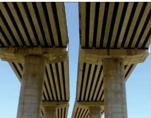
Fot. 5 | Prefabrykowane belki typu „T”
