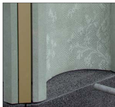
Fot. 2 | Fragment elewacji z betonu architektonicznego
