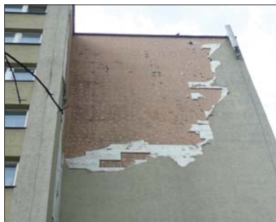
Fot. 4 | Zerwanie niepoprawnie wykonanej elewacji na skutek niekorzystnego oddziaływania wiatru
