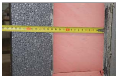
Fot. 1 | Kombinacja warstw izolacji termicznej w systemie ETICS w celu uzyskania wyższej izolacyjności przegrody
