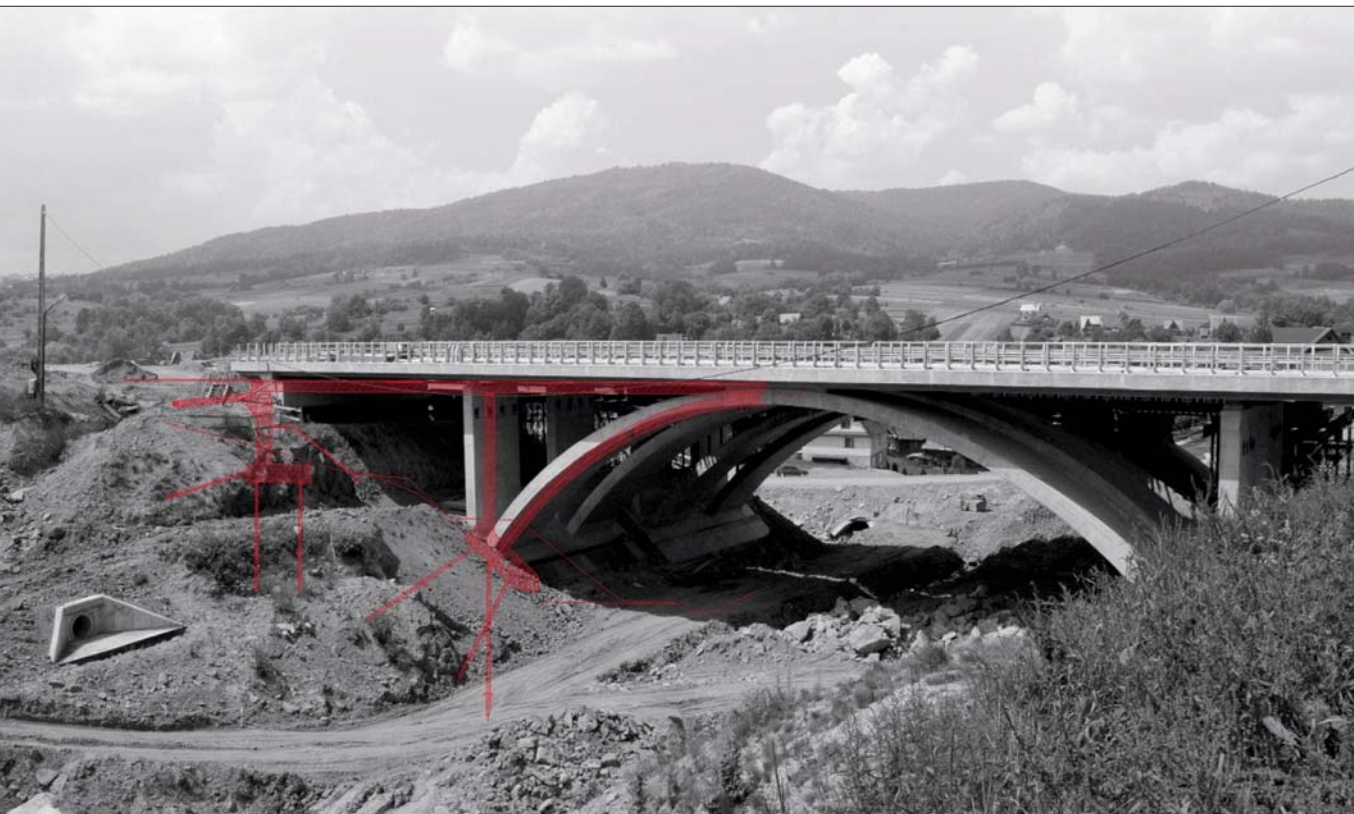
Fot. 4 | Most łukowy z jazdą górą posadowiony na mikropalach (fot. Titan Polska)
