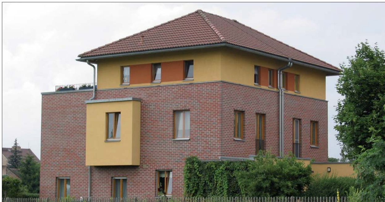
Fot. 1 | Elewacja klinkierowa łączona z tynkiem, dom mieszkalny
