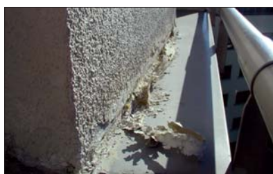
Fot. 13 | Źle wykonana obróbka blacharska – degradacja ocieplenia na skutek permanentnego zawilgocenia
