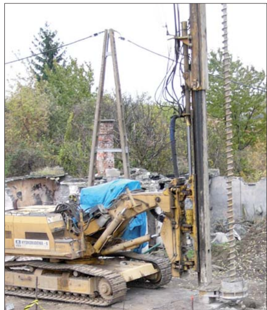
Fot. 1 | Maszyna do wykonywania mikropali świrdrem ciągłym
