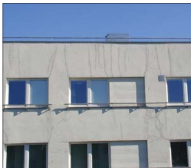
Fot. 5 | Spękania nasłonecznionej elewacji wyłącznie od strony południowej
