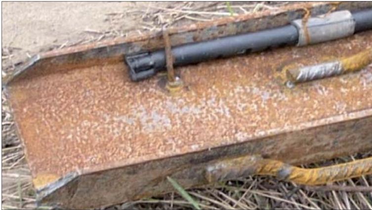
Fot. 2 | Dolna część zbrojenia mikropala z rurkami iniekcyjnymi
