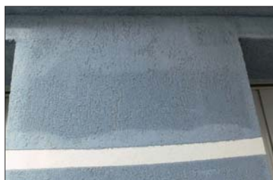
Fot. 2 | Wybarwienia na tynku silikatowym związane z niezapewnieniem optymalnego wysychania tynku po aplikacji
