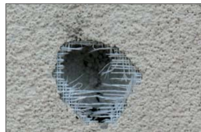
Fot. 9 | Uszkodzenie mechaniczne elewacji wykonanej w systemie ETICS
