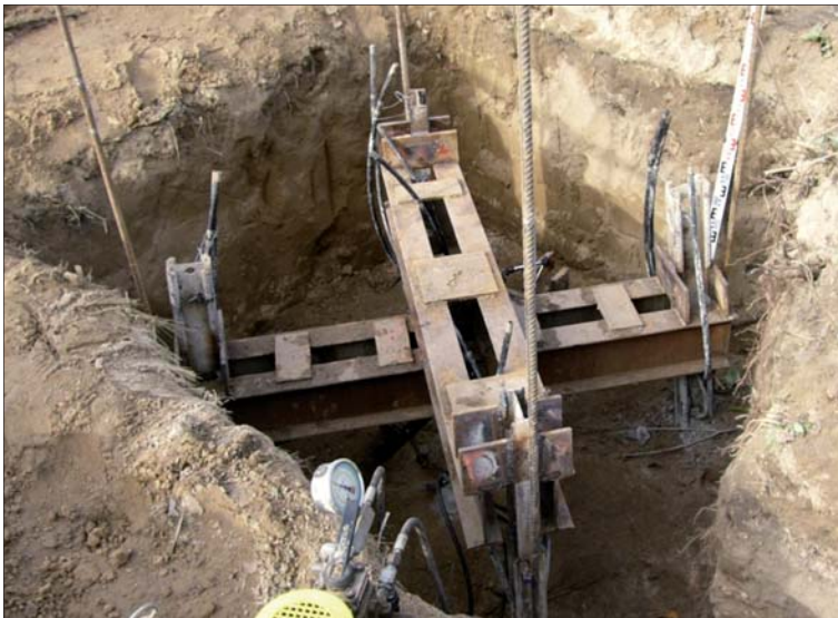
Fot. 3 | Konstrukcja do przeprowadzenia próbnego obciążenia mikropala. Widoczne rurki iniekcyjne w mikropalach kotwiących
