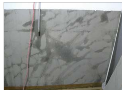
Fot. 6 | Zniszczenie systemu ETICS, w trakcie badań cykli ciepło-wilgotnościowych, ściany testowej o wymiarach ~2 x 3 m, wg procedury opisanej w ETAG 004 [6]
