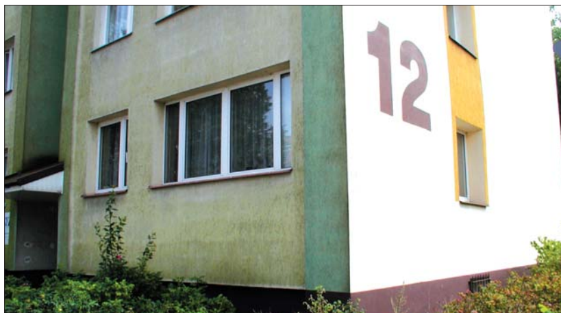
Fot. 7 | Zniszczenie nietypowego systemu ETICS, mocowanego do niestandardowego podłoża wyłącznie za pomocą łączników mechanicznych
