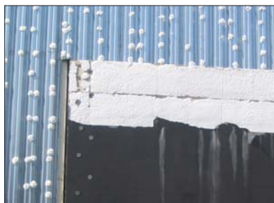
Fot. 7 | Zniszczenie nietypowego systemu ETICS, mocowanego do niestandardowego podłoża wyłącznie za pomocą łączników mechanicznych
