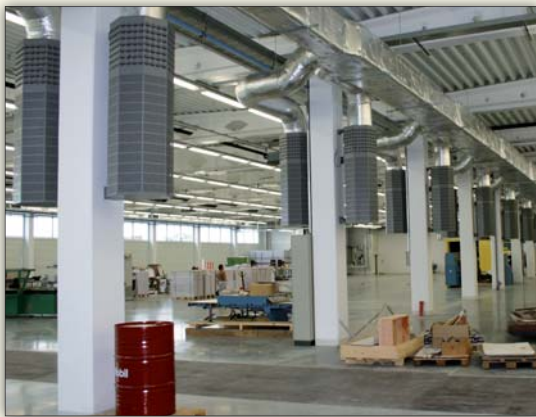
Fot. 7 | Instalacja wentylacyjna z nawiewnikami dwufunkcyjnymi BOCa firmy Swegon w fabryce INDESIT w Łodzi (fot. archiwum firmy Swegon)
