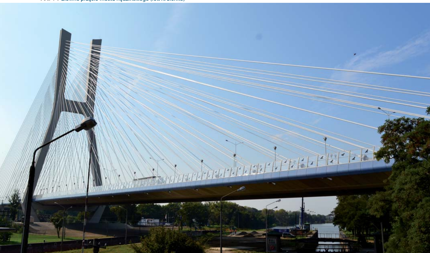
Fot. 4 | Główne przęsło mostu Rędzińskiego (fot. R. Sieńko)
