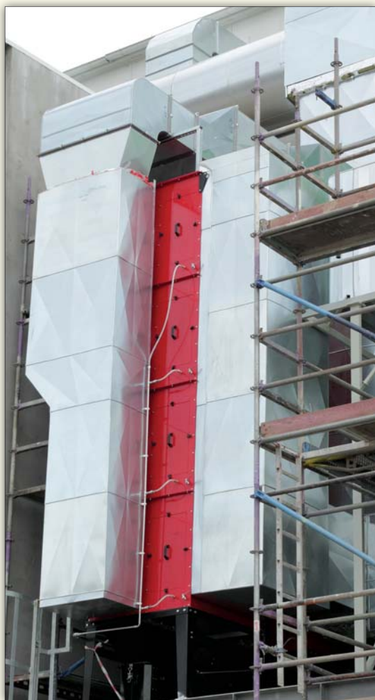
Fot. 4 | Układ filtrowentylacji z wykorzystaniem urządzeń KLIMAWENT (fot. Sandra Jasińska, archiwum firmy KLIMAWENT S.A.)
