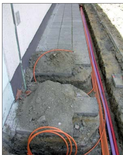
Fot. 1 | Przykład ułożenia mikrokanalizacji wzdłuż chodnika i odgałęziania kolejnych rurek do posesji (fot. Duraline)
