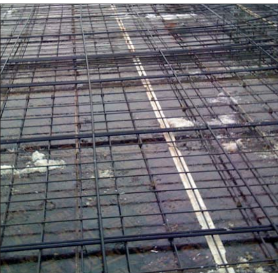
Fot. 5 | Kable w stropie sprężonym
