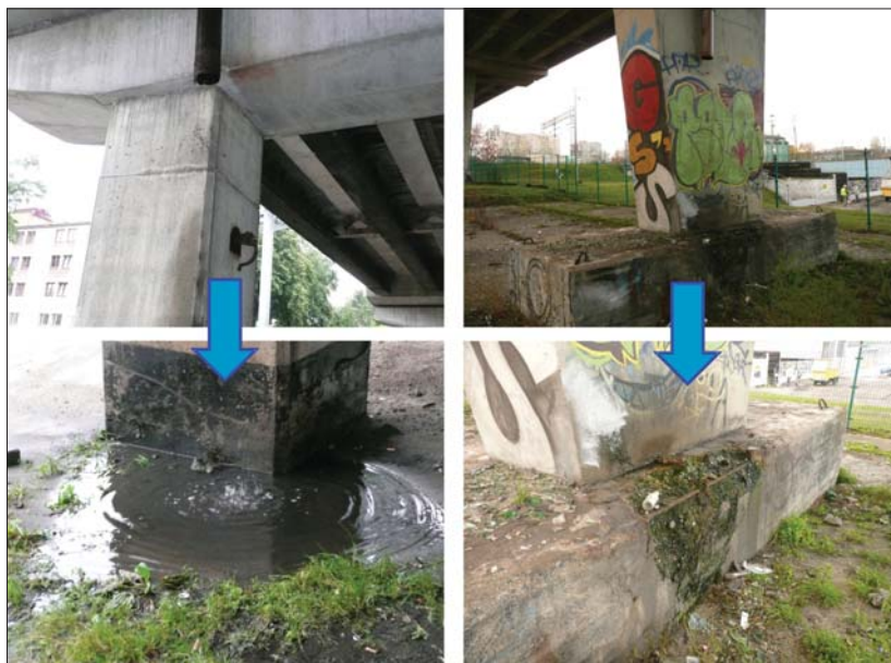
Fot. 3 | Przykłady uszkodzeń elementów konstrukcji podpór obiektów mostowych spowodowanych uszkodzeniem elementów odwodnienia (fot. autor)
