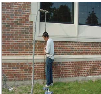
Fot. 3 | Iniekcja materiałami bentonitowymi w grunt
