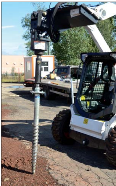
Fot. 6 | Pál śrubowy przygotowany do wkręcania
