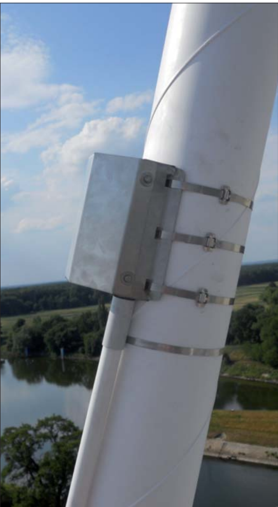
Fot. 5 | Widok z pylonu przęsła nurtowego mostu Rędzińskiego w czasie budowy oraz obudowa czujnika drgań na jednej z wąt (fot. R. Sienko)
