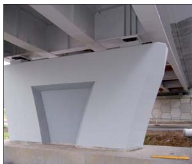
Fot. 5 Lewy filar i przyczółek południowy (podpory nr 34 i 35) estakady E4 nad ul. Rudacką (fot. A. Kowalski)
