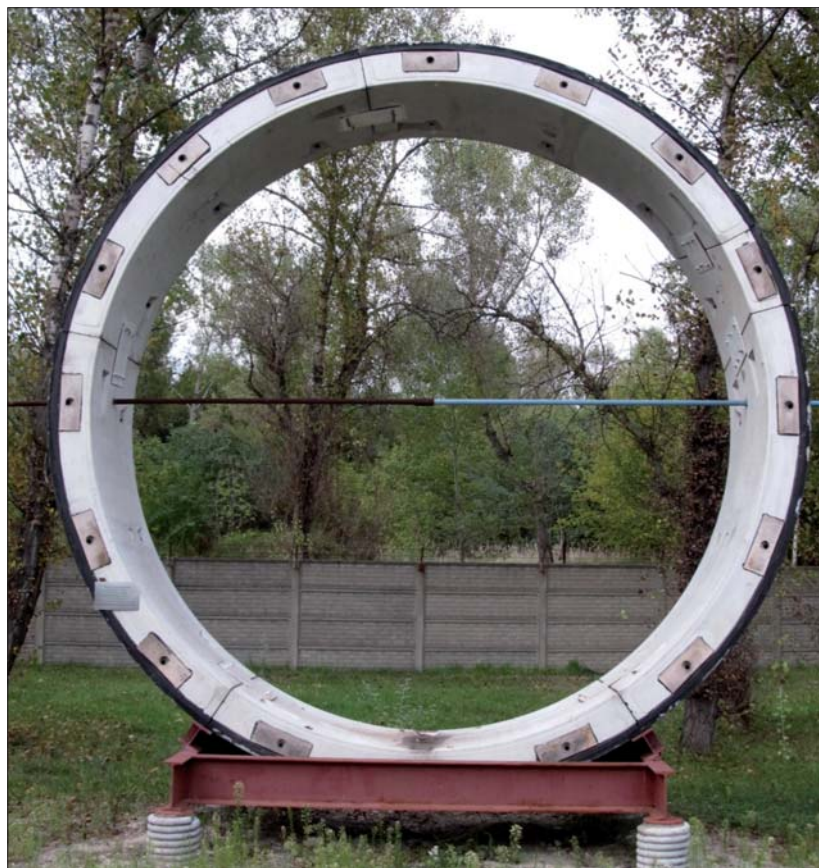
Fot. 3 | Pokazowy segment tunelu wykonanego pierwszą w Polsce tarczą TBM przez Wisłę w Warszawie posadowionego na żelbetowych palach wkręcanych
