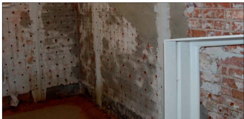
Fot. 2 | Ściana przygotowana pod iniekcję żelami akrylowymi
