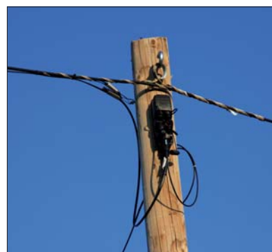
Fot. 2 | Przykład światłowodowej sieci podwieszanej. Aby wykonać odejście do budynku, na słupie musi zostać umieszczona skrzynka lub tzw. mufla, gdzie należy wykonać spawy włókien światłowodowych lub dokonać przyłączenia odpowiednim kablem z przygotowaną złączką hermetyczną (fot. autor)
