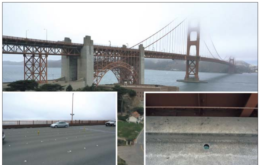
Fot. 1 | Widok ogólny mostu Golden Gate i sposób jego odwodnienia w obrębie jezdni i chodnika (fot. autor)
