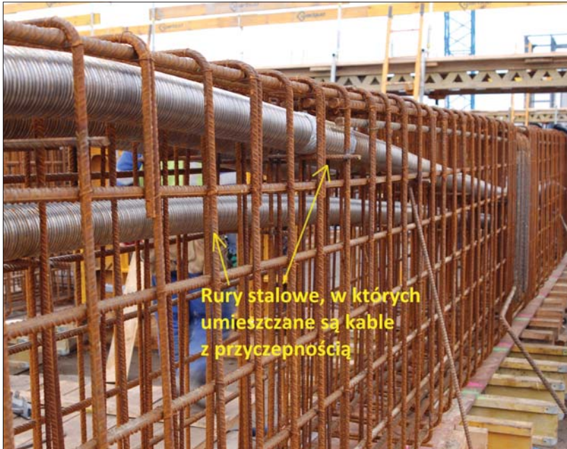
Fot. 3 | Kanały z rur stalowych w systemie przyczepnościowym
