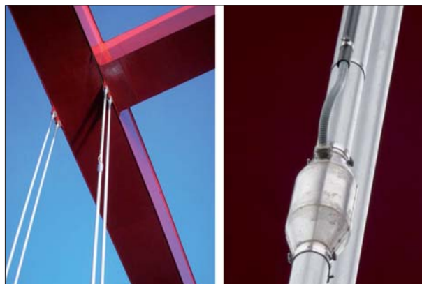
Fot. 3 | Lokalizacja czujników odkształceń i drgań na wieszaku prętowym oraz ich obudowy (fot. R. Sieńko)
