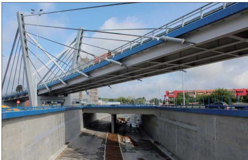
Fot. 1 | Estakada nad tunelem (fot. K. Dudek)
