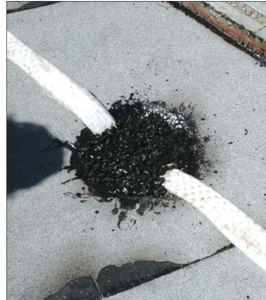
Fot. 6 | Zamontowany sącdek odwadniający hydroizolację pomostu wraz z zastosowanym drenażem (fot. autor)
