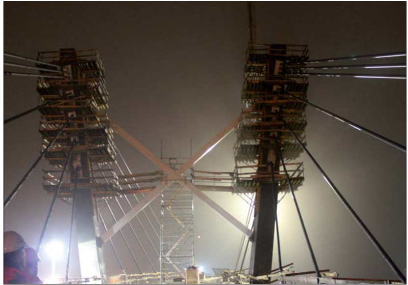
Fot. 6 | Naciąg want pylonu podpory nr P2 (fot. K. Dudek)
