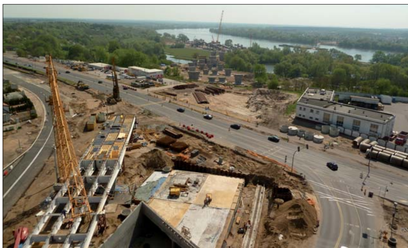
Fot. 2 | Widok na budowane obiekty w maju 2012 r. (fot. B. Glapiak)
