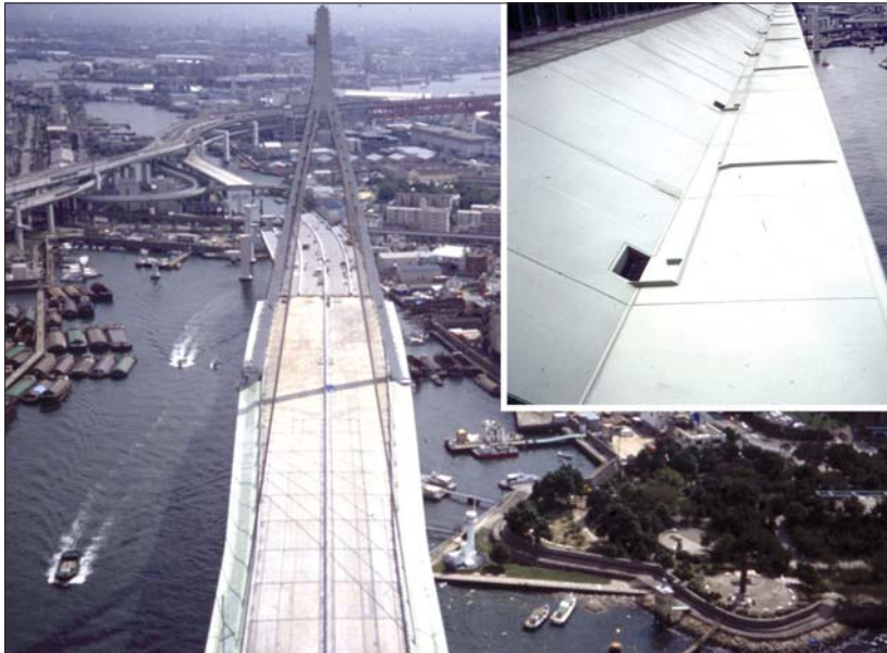
Fot. 5 | Przykład odwodnienia elementów aerodynamicznych belki usztywniającej mostu podwieszonoego w Osace, Japonia (fot. autor)
