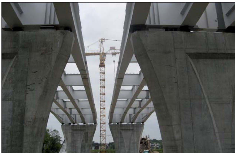
Fot. 3 | Konstrukcje stalowe przeseł ułożone na podporach nr 18 i 19 estakad E3 (fot. A. Kowalski)
