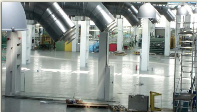
Fot. 5 | Instalacja wentylacyjna z nawiewnikami dalekiego zasięgu CKDa firmy Swegon w fabryce HUTCHINSON w Łodzi (fot. archiwum firmy Swegon)
