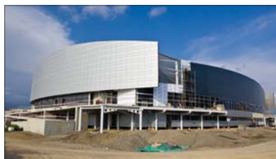
Fot. SC Olympstroy, wszystkie prawa zastrzeżone Ice Cube Curling Center w Soczi www.
