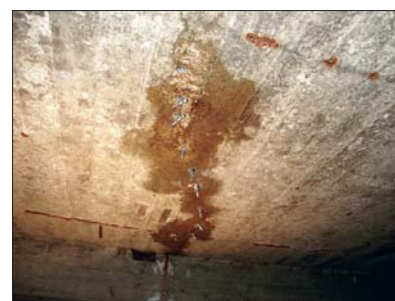
Fot. 1 | Iniekcja uszczelniająca przez pakery mocowane w rysie
