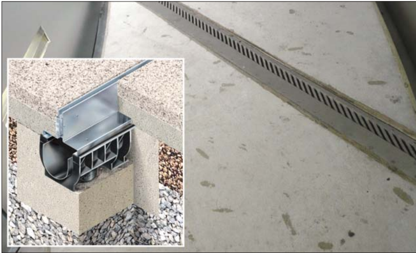
Fot. 7 Widok liniowego wpustu odwadniającego konstrukcję kładki dla pieszych prowadzącej do centrum BMW w Monachium (fot. autor). W dolnej lewej części zdjęcia pokazano widok szczelinowego liniowego systemu odwodnienia (fot. Hauraton)
