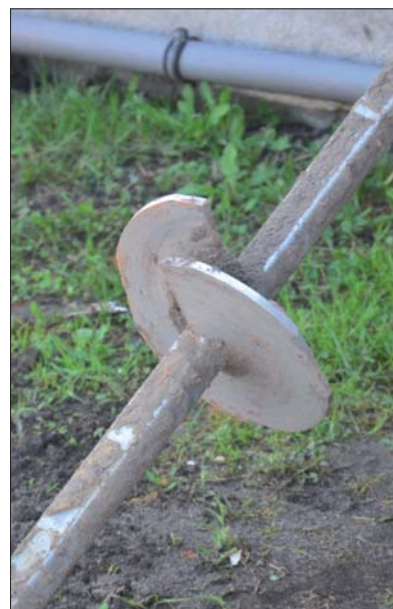
Fot. 4 | Szczegół konstrukcyjny pala śrubowego ze spiralnym elementem nośnym
