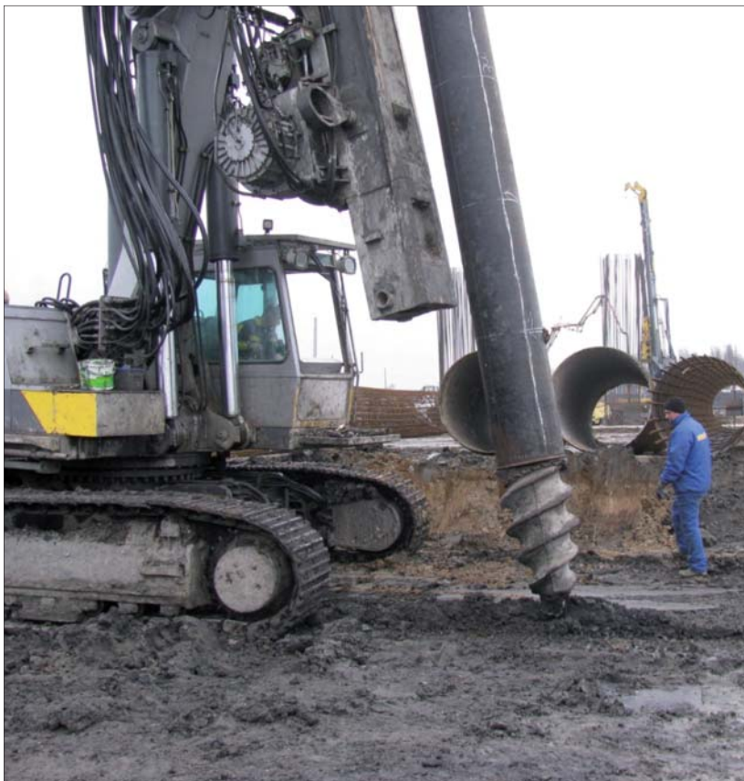
Fot. 2 | Palownica z palem wkręcanym w czasie pracy
