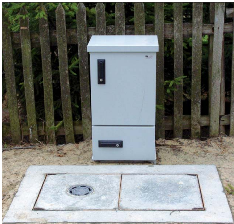
Fot. 3 | Szafka uliczna pełniąca funkcję głównego punktu dostępowego dla osiedla domów jednorodzinnych. Obok widoczna studnia, z której wykonane jest przyłącze do kanalizacji operatora. Pokazana szafka PSB-H-72 o wymiarach 450x790x355 mm dostosowana do sieci P2MP w technologii GPON pozwala na umieszczenie splitterów optycznych i przyłączenie maksymalnie 72 abonentów (fot. FCA sp. z o.o.)
