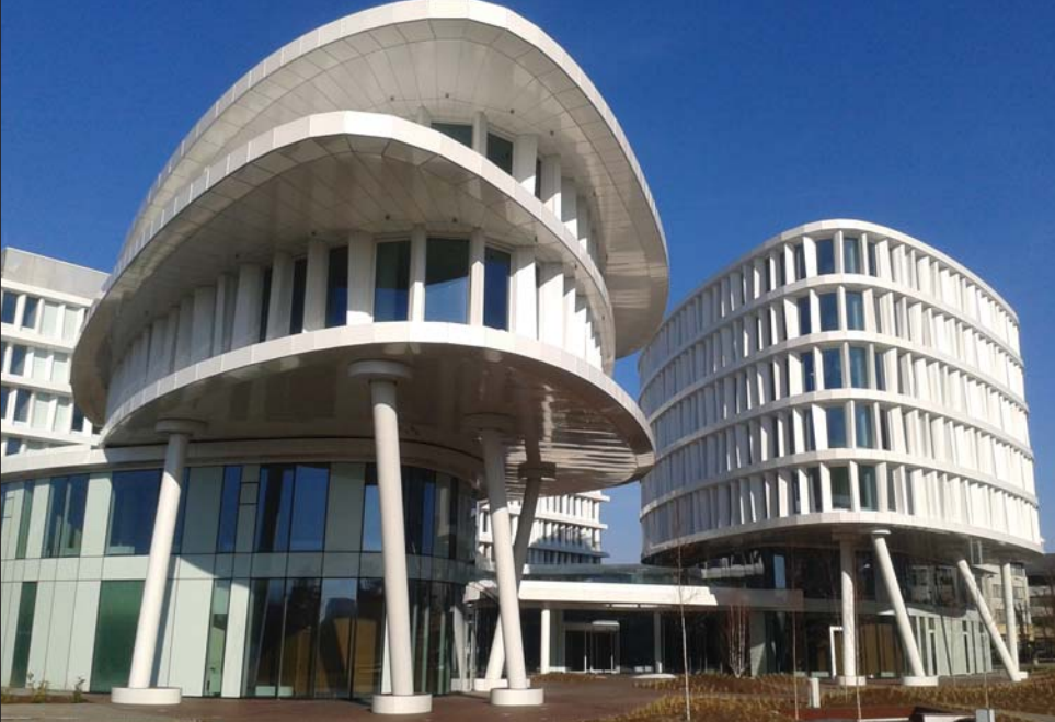
Fot. 1 | Możliwości wysięgu stropów przewieszonych wspornikowo
