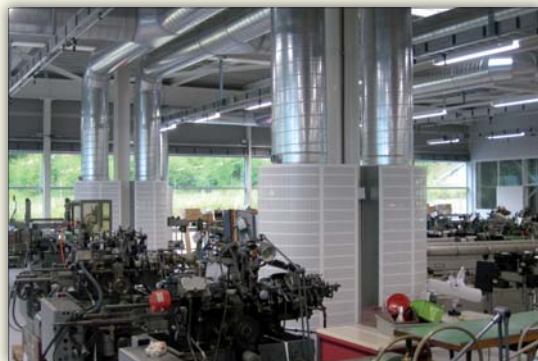
Fot. 3 | Instalacja wentylacyjna z nawiewnikami wporowymi DBCa z systemem VARIZON® firmy Swegon w hali produkcyjnej (fot. archiwum firmy Swegon)
