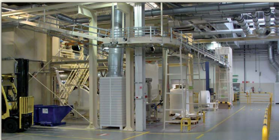
Fot. 1 | Instalacja wentylacyjna z nawiewnikami wporowymi DKCe z systemem VARIZON® firmy Swegon w fabryce SCA Hygiene w Oławie (fot. archiwum firmy Swegon)
