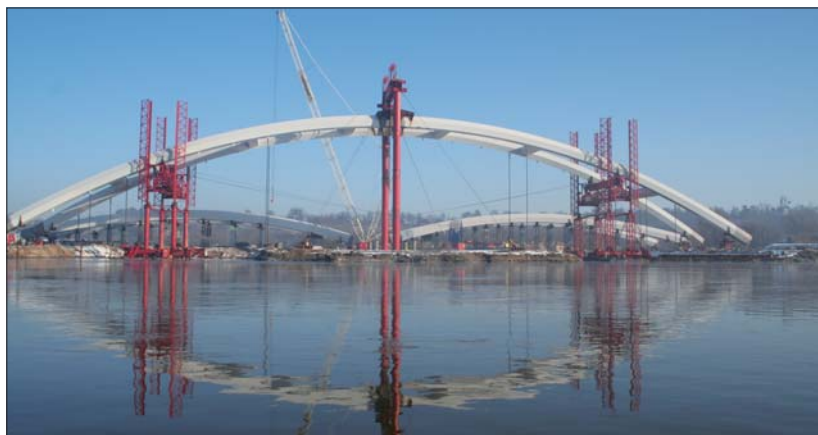
Fot. 4 Scalony dźwigar łukowy mostu na środkach pływających przed usunięciem podpory z klucza łuku w marcu 2013 r. (fot. B. Glapiak)
