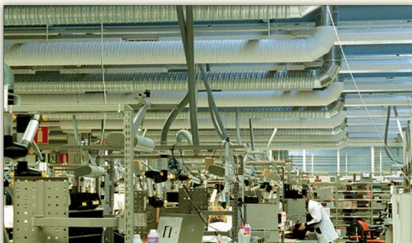
Fot. 6 | Instalacja wentylacyjna hali fabrycznej wykonana w systemie Activent – przewody wentylacyjne wyposażone są w dużą ilość małych dysz nawiewających powietrze całą długością kanału (fot. archiwum firmy Fläkt Bovent Sp. z o.o.)
