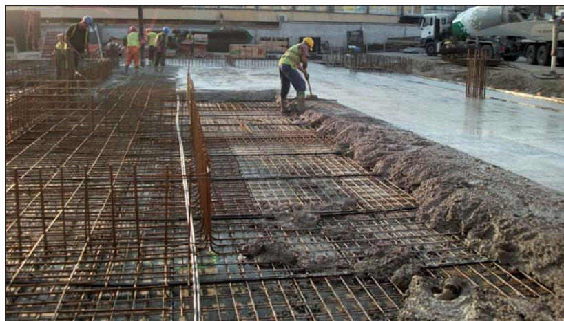
Fot. 4 | Układanie mieszanki betonowej w stropie kablobetonowym
