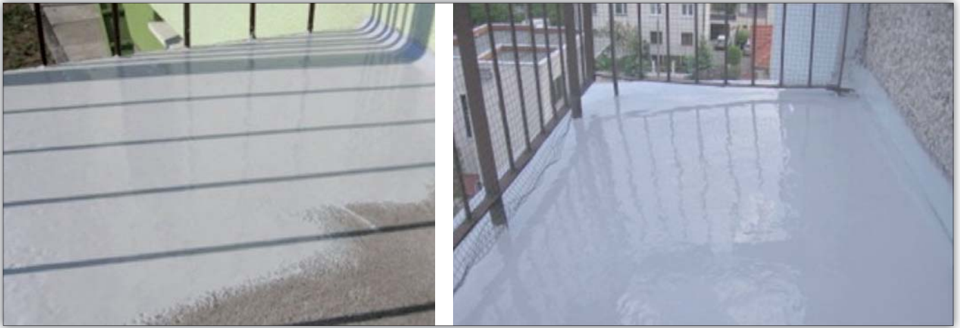
Fot. 1 | Hydroizolacja balkonów z zastosowaniem płynnych folii mineralnych (fot. materiały firmy Drizoro)
