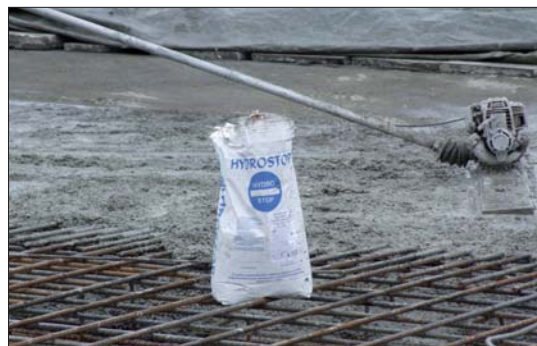
Fot. 3 | Zatarcie betonu z zachowaniem spadków narzuconych przez zbrojenie
