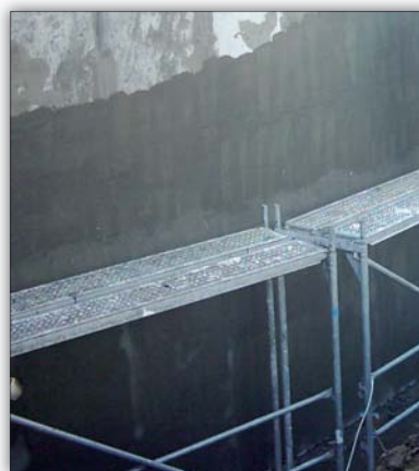
Fot. 2 | Izolacja chemoodporna z EKO 2K
