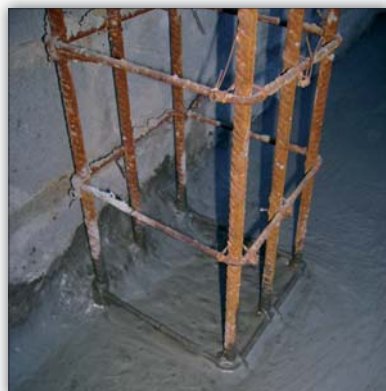
Fot. 1 | Izolacja między prętami zbrojenia
