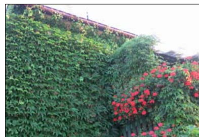
Fot. 1 | Elewacja i okap dachu porośnięte pnączem (w okresie jesiennym i letnim) – destrukcyjny porost niekontrolowany. Fot. autora
