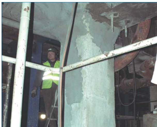
Fot. 2 | Uzupełnienie ubytków betonu w ryglu i słupach fundamentu
