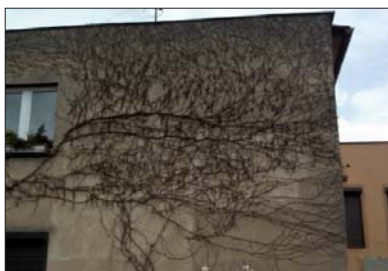
Fot. 1 | Elewacja i okap dachu porośnięte pnączem (w okresie jesiennym i letnim) – destrukcyjny porost niekontrolowany. Fot. autora
