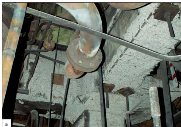
Fot. 1 | Stan fundamentu ramowego po pożarze i odkuciu uszkodzonej warstwy betonu
