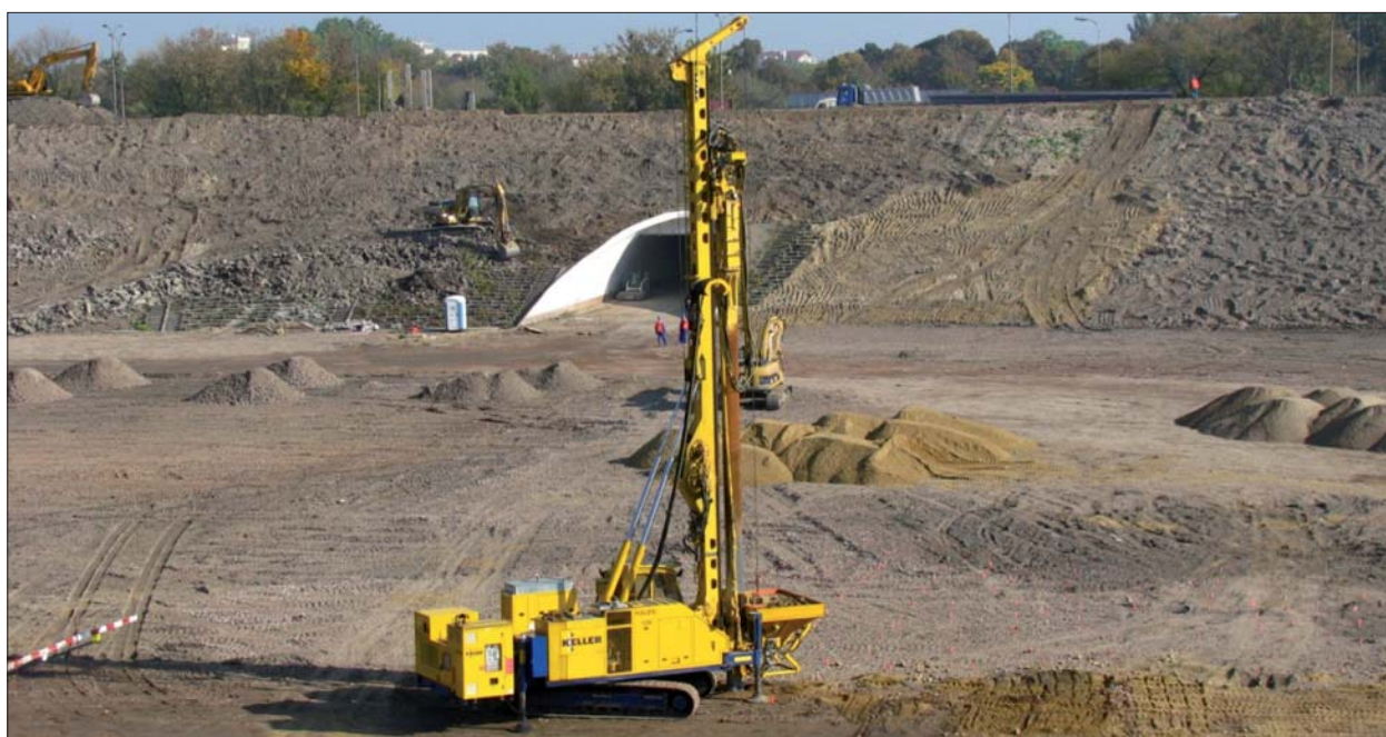
Fot. 1 | Maszyna do wykonywania wibrowymiany
