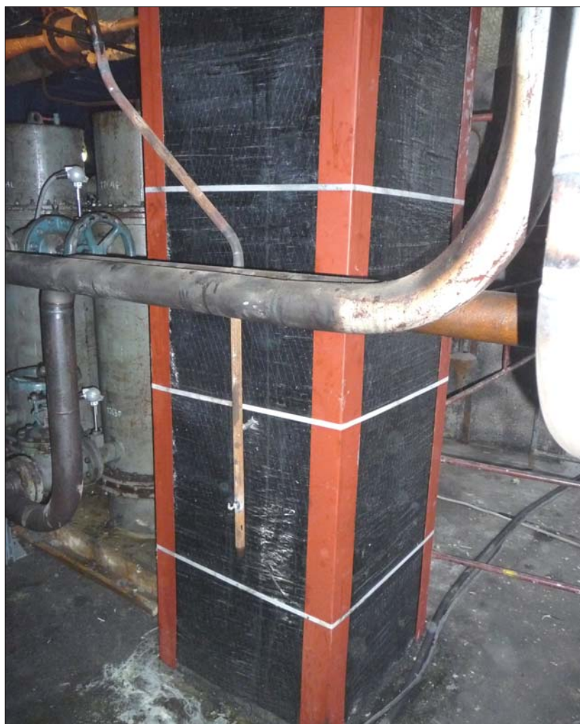
Fot. 3 | Elementy konstrukcji fundamentu wzmocnione matą węglową
