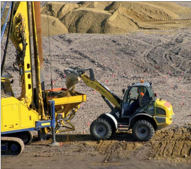
Fot. 3 | Kosz zasypowy do napełniania wibratora służowego
