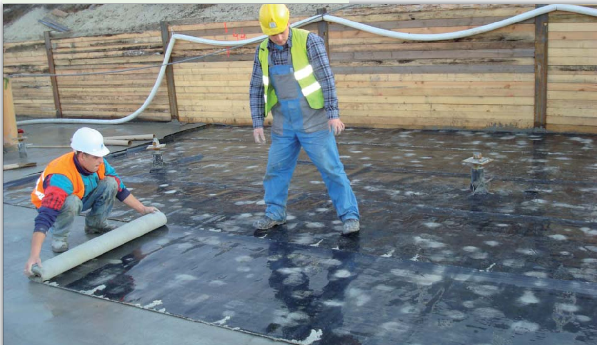
Fot. 6 | Układanie mat bentonitowych Dualseal (fot. materiały firmy Nomos-Bud)
