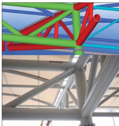
Rys. 1 Jeden z węzłów konstrukcji stadionu Arki Gdynia – widok w programie Tekla oraz po realizacji Rys. Spomasz S.A. i RCK Biuro Inżynierskie
