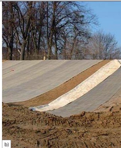
Fot. 3 | Hydroizolacje z mat bentonitowych: a) izolowanie fundamentów, b) izolowanie składowisk odpadów (fot. materiały firmy Lemax)
