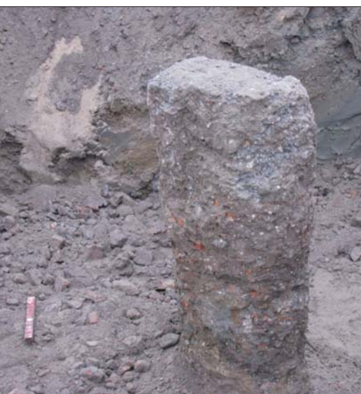
Fot. 5 | Głowica kolumny wibrocementowej wykonana w gruntach organicznych i nasypowych
