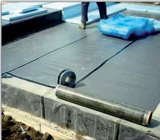
Fot. 4 | Układanie kompozytowych membran izolacyjnych (fot. materiały firmy CETCO)
