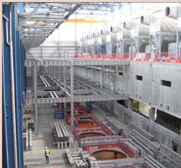
Huta magnezu w Porsgrunn w Norwegii – wewnątrz obiektu w czasie montażu Fot. PROMOSTAL
