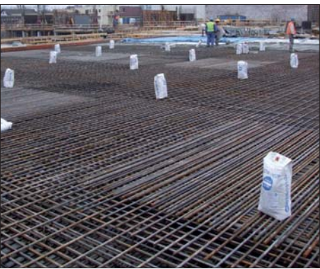
Fot. 1 | Podział płyty na pola powierzchni; gotowość do zalania betonem
