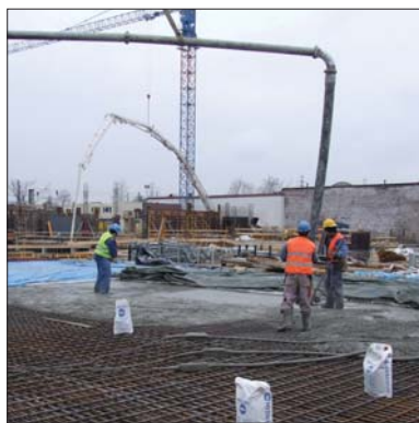
Fot. 2 | Wylewanie płyty stropowej i aplikacja produktu Hydrostop nr 209 na powierzchnię stropu
