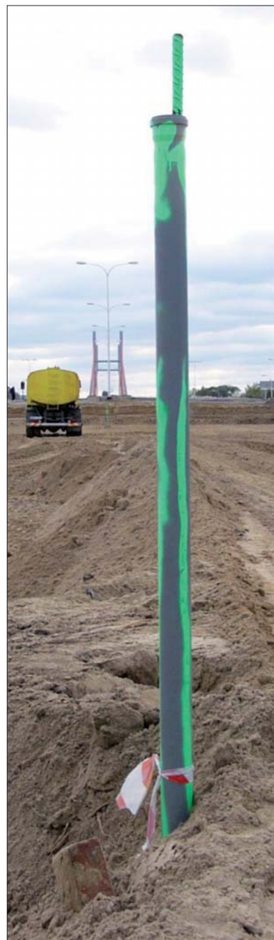
Fot. 7 | Reper do pomiaru osiadań podstawy nasypu
