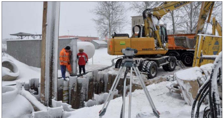
Renowacja kanalizacji sanitarnej
