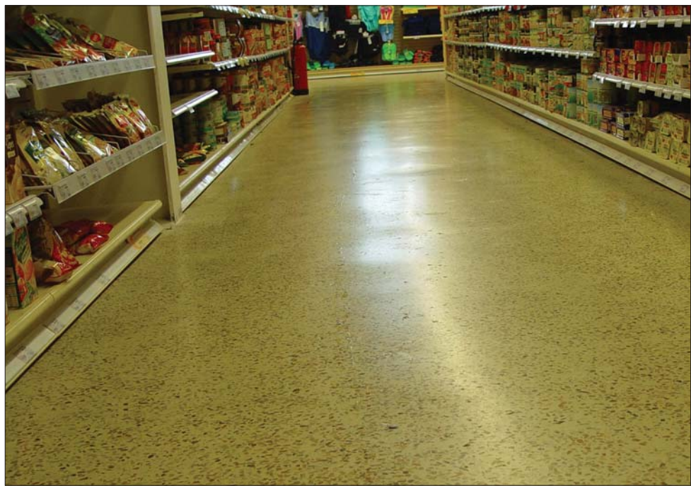
Fot. 10 | Posadzka szlifowana barwiona na zapleczu budynku handlowo-usługowego
