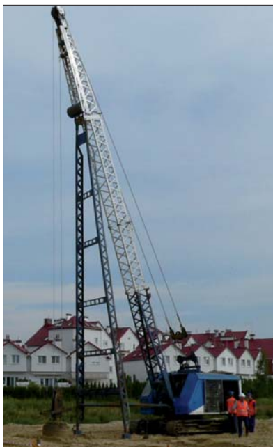
Fot. 1 | Maszyna umożliwiająca zrzucanie bijaka z wysokości kilku metrów
