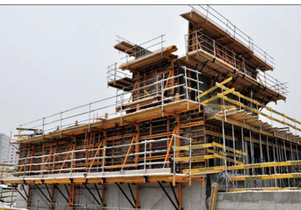
Fot. 1 | Konsole BMK na budowie Parku Ostrobramska w Warszawie
