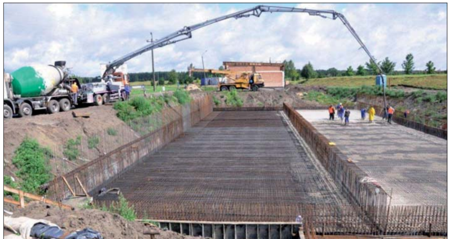
Budowa komór stabilizacji tlenowej (oczyszczalnia ścieków)
