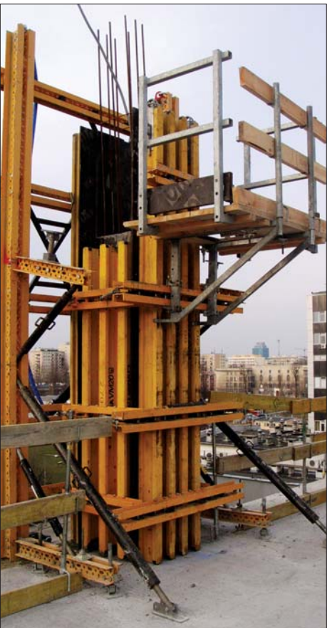
Fot. 3 | System elewacyjny MK na budowie szpitala pediatricznego WUM w Warszawie
