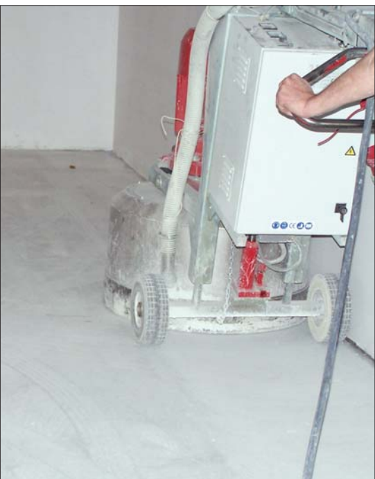
Fot. 7 Szlifowanie posadzki wykonanej z betonu posadzkowego samozagęszczalnego
