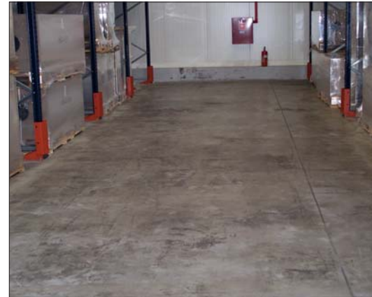
Fot. 1 Uszkodzona posadzka żywiczna przeznaczona do naprawy
