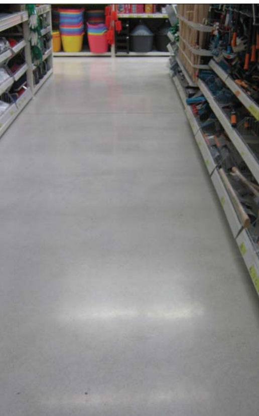
Fot. 9 | Posadzka szlifowana niebarwiona w pomieszczeniu hurtowni
