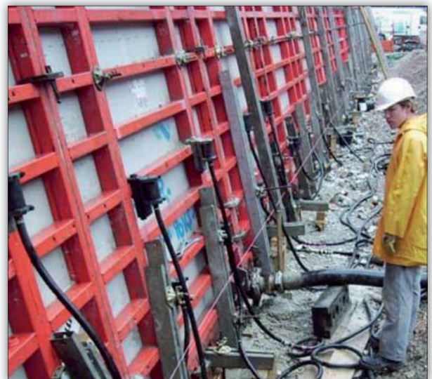
Fot. 2 | Betonowanie „oddolne”; a) widok podłączonego rurociągu pompy do króćca usytuowanego w deskowaniu ramowym, b) widok betonowanej ściany sposobem „oddolnym” (MEVA)
