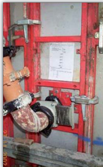
Fot. 2 | Betonowanie „oddolne”; a) widok podłączonego rurociągu pompy do króćca usytuowanego w deskowaniu ramowym, b) widok betonowanej ściany sposobem „oddolnym” (MEVA)
