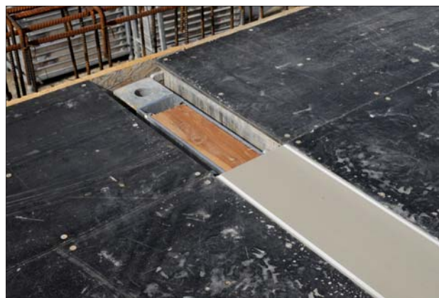
Fot. 4 | Powierzchnia deskowania - systemowe pasy uzupełniające wypełniające przerwy między panelami
