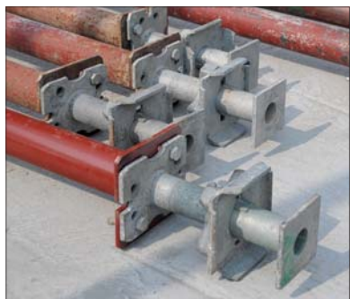
Fot. 3 | Głowice opadające zamontowane wstępnie na podporach
