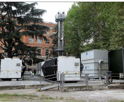
Fot. 3 | System chłodzenia adiabaticznego TraneCare™ zainstalowany na agregatach chłodniczych chłodzących powietrzem
