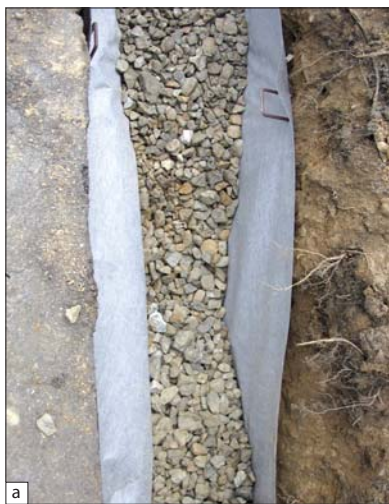
Fot. 1 | Drenaż francuski: a) wyłożenie wykonanego wykopu odpowiednio dobraną geowłókniną igłowaną; b) zamknięcie drenu za pomocą metalowych szpilek typu U (fot. Inora).
