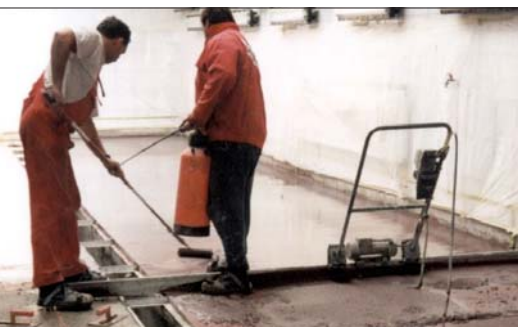
Fot. 5 | Układanie posadzki z betonu prawie samozagęszczalnego
