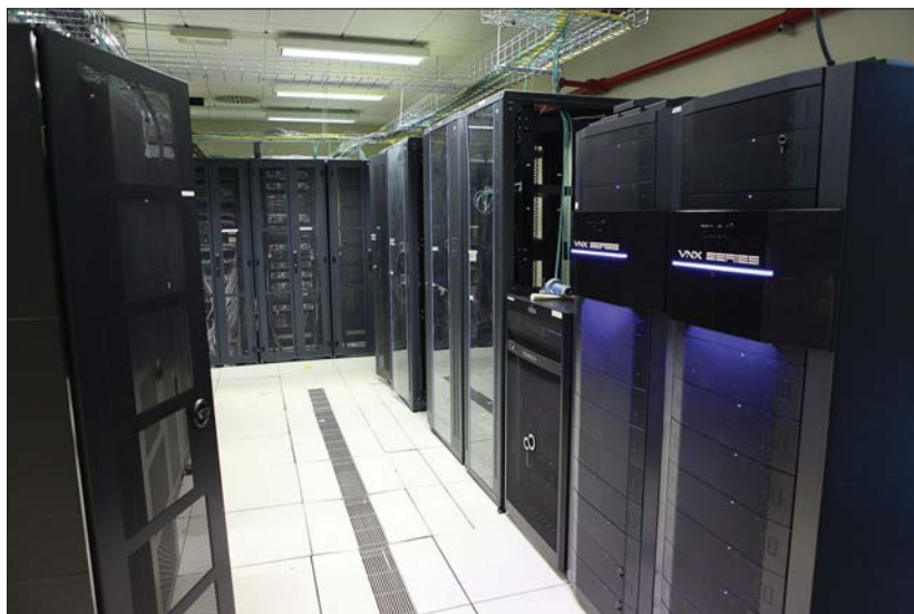
Fot. 1 | Serwerownia w banku Intesa Sanpaolo w Parmie
