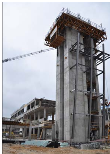
Fot. 2 | System samowznoszący ATR na budowie wieży widokowej w CK Targi Kielce
