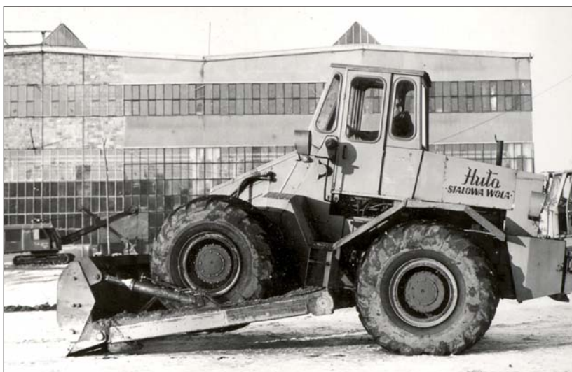
Fot. 1 | Spycharka S3 produkowana w latach 70. w Stalowej Woli
