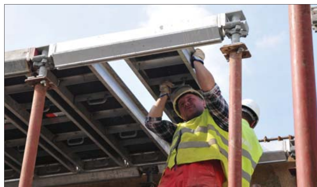
Fot. 5 | Układanie paneli HV na dźwigarach
