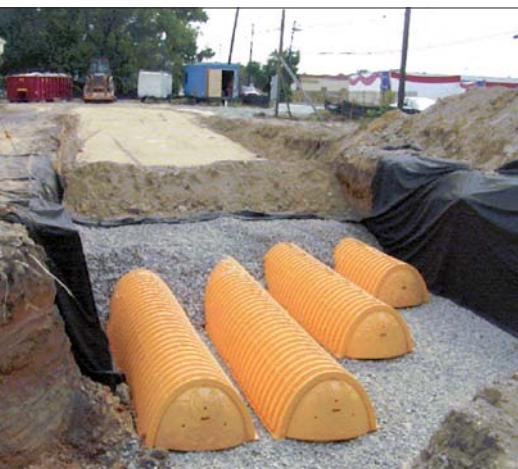
Fot. 5 | Montaż komór drenażowych StormTech (materiały informacyjne Ekobudex)
