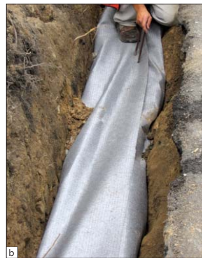
Fot. 1 | Drenaż francuski: a) wyłożenie wykonanego wykopu odpowiednio dobraną geowłókniną igłowaną; b) zamknięcie drenu za pomocą metalowych szpilek typu U (fot. Inora).
