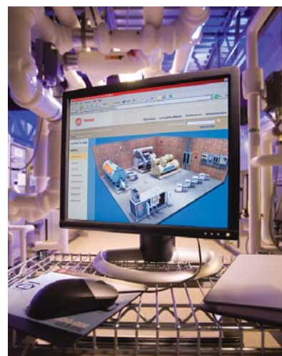
Fot. 2 | Kontroler automatyki budynku
