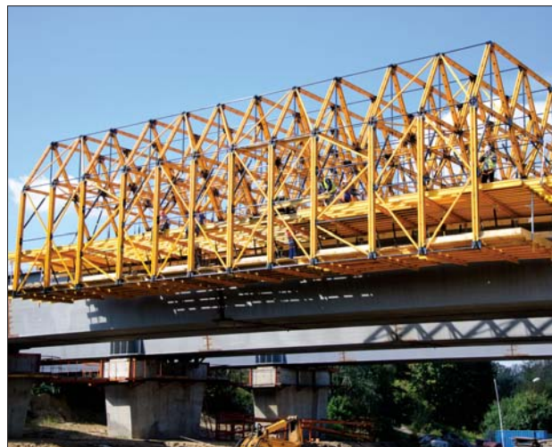
Fot. 4 | Wózki przejazdne podczas budowy mostu Marii Curie-Skłodowskiej
