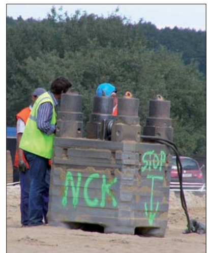
Fot. 3 | Bijak o przekroju kwadratowym
