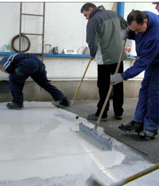
Fot. 6 | Wykonywanie betonowej posadzki samozagęszczalnej
