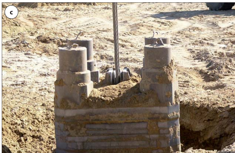
Fot. 4 a, b, c | Zagłębianie bijaka w czasie formowania kolumny
