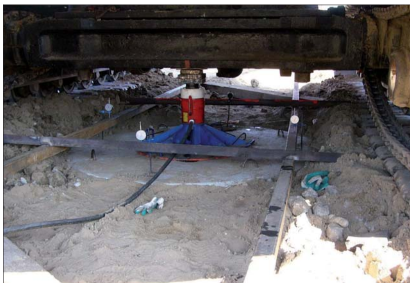
Fot. 6 | Próbné obciążenie płytą statyczną z wykorzystaniem dźwigu używanego do wykonania kolumn
