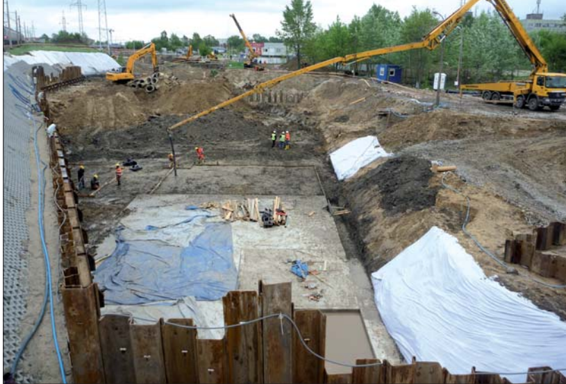
Fot. 7 | Beton podkładowy pod płytę ślizgową
