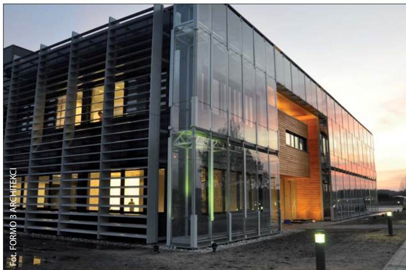
Fot. 5 | Siedziba Schüco International Polska (energooszczędny budynek biurowy), Sierpnie koło Warszawy
