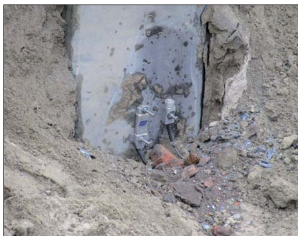
Fot. 3 Czujniki do pomiaru odkształceń i przyspieszeń w badaniu dynamicznym pala
