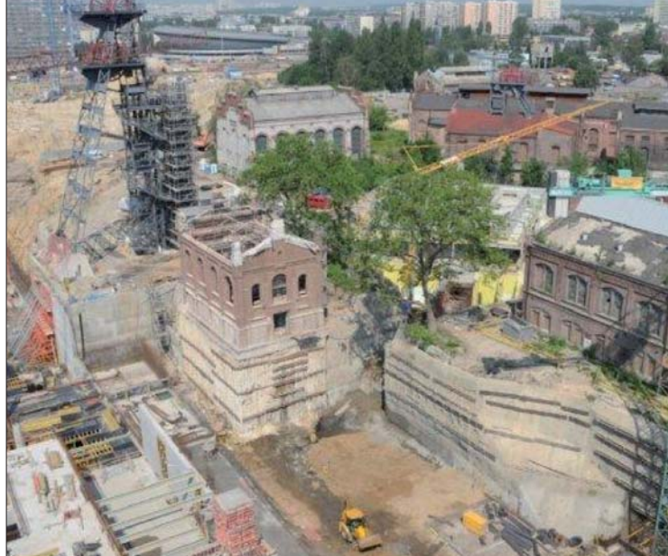
Fot. 1 | Panorama budowy
