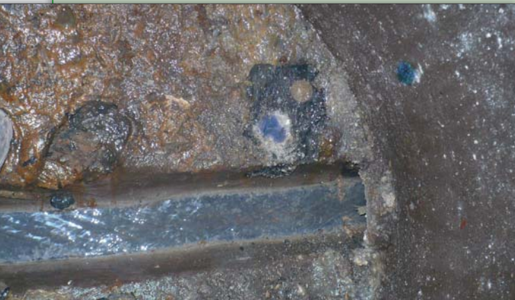
Fot. 2 | Eksploatowana studzienka z dennicą wyposażoną fabrycznie w kinetę (źródło: archiwum SPEBK)
