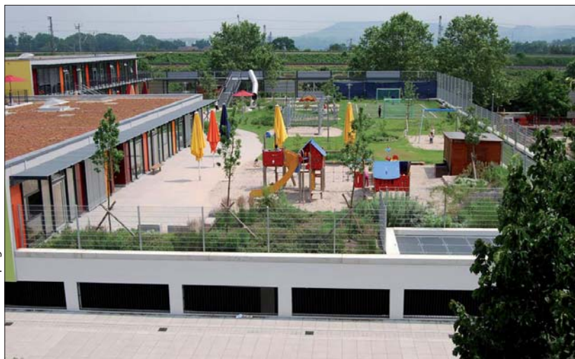
Fot. 6 | Wykorzystanie zieleni w przestrzeni półpublicznej; zagospodarowanie dachu nad garażem wspólnym dla kilku budynków mieszkalnych na osiedlu strzeżonym
