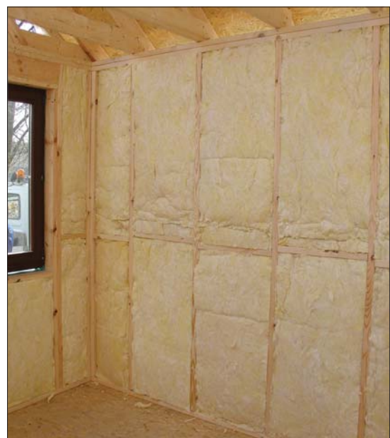
Fot. 2 | Izolacja cieplna ściany
