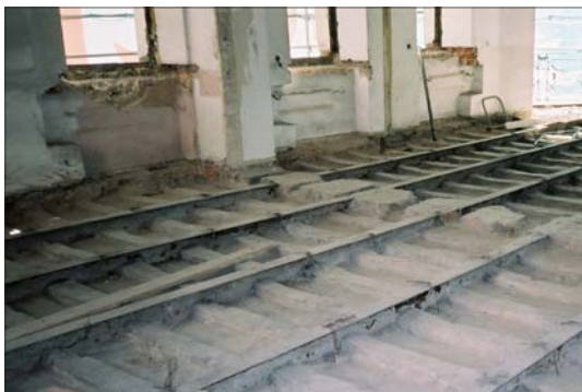
Rys. 2 | Strop WPS z podłogą na płytach suchego jastrychu
