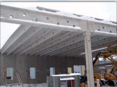
Fot. 1 | Płyty STT o rozpiętości 21,57 mb – budowa budynku PolHun w Koluśkach
