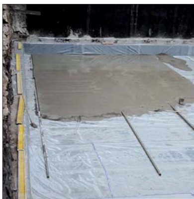
Fot. 2 | Wykonanie warstwy ochronnej
