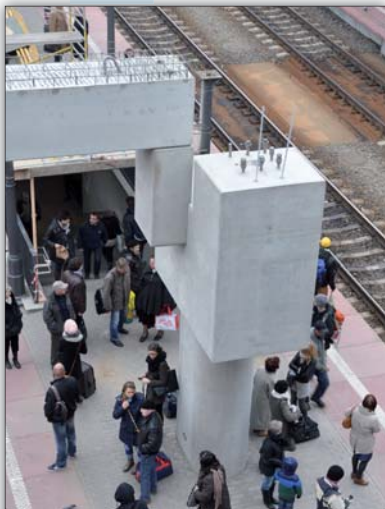
Fot. 1 | Słup pod konstrukcją stalową – peron 2
