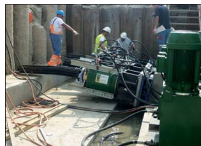
Fot. 4 | Prasy hydrauliczne, przygotowanie do nasuwki
