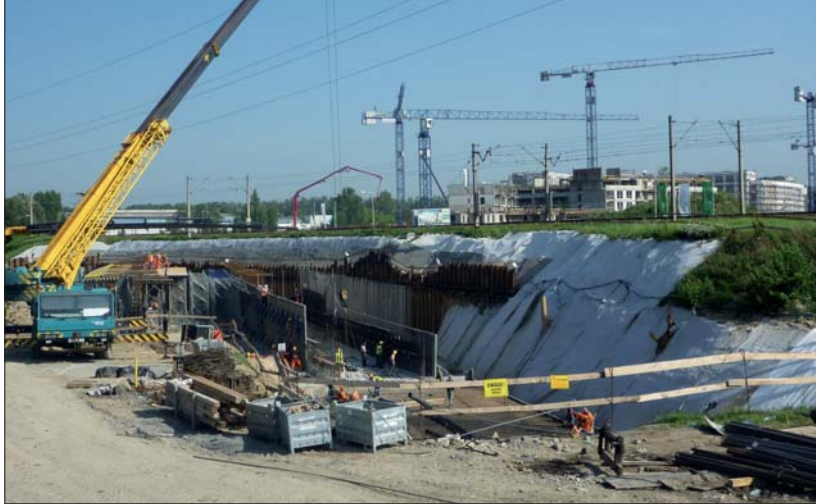
Fot. 8 | Prefabrykacja tunelu
