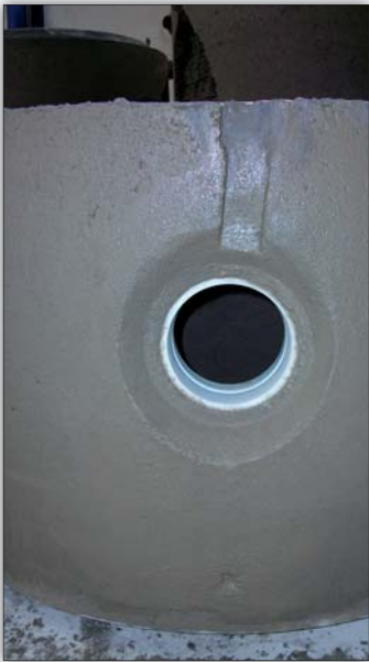
Fot. 4 | Dennica po rozformowaniu z zawi-browanym przejściem szczelnym. Przejścia o większych średnicach wklejane są po procesie formowania dennicy
