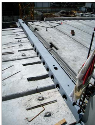
Fot. 1 | Podciąg Deltabeam® ukryty w wysokości płyt HC (Katowice Business Point, Ghelamco)
