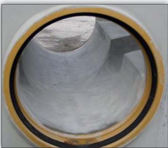
Fot. 5 | Wklejone w zakładzie prefabrykacji przejście szczelne i kineta
