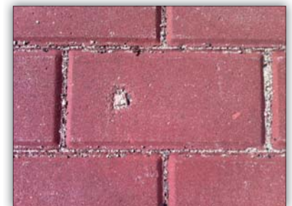
Fot. 5 | Kostka z odpryskiem – element nie spełniający wymagań normowych
