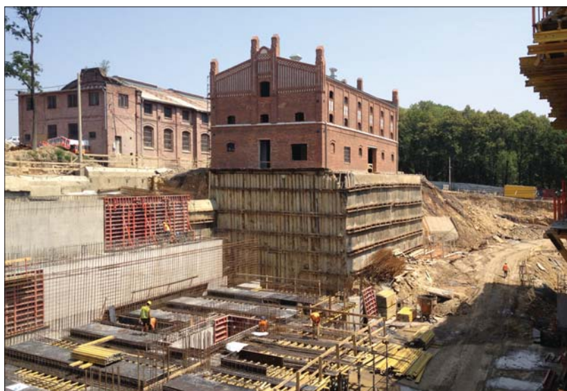
Fot. 5 | Widok w kierunku budynku MS-15
