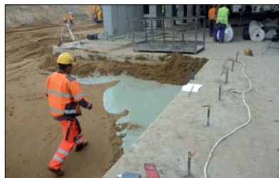
Fot. 2 | Wypychany spod konstrukcji grunt i zawieszina
