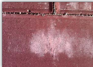
Fot. 6 | Wykwyty na elementach kostki brukowej
