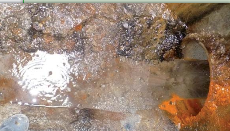
Fot. 3 | Studzienka z dennicą wyposażoną w kinetę poza zakładem prefabrykacji (źródło: archiwum SPEBK)
