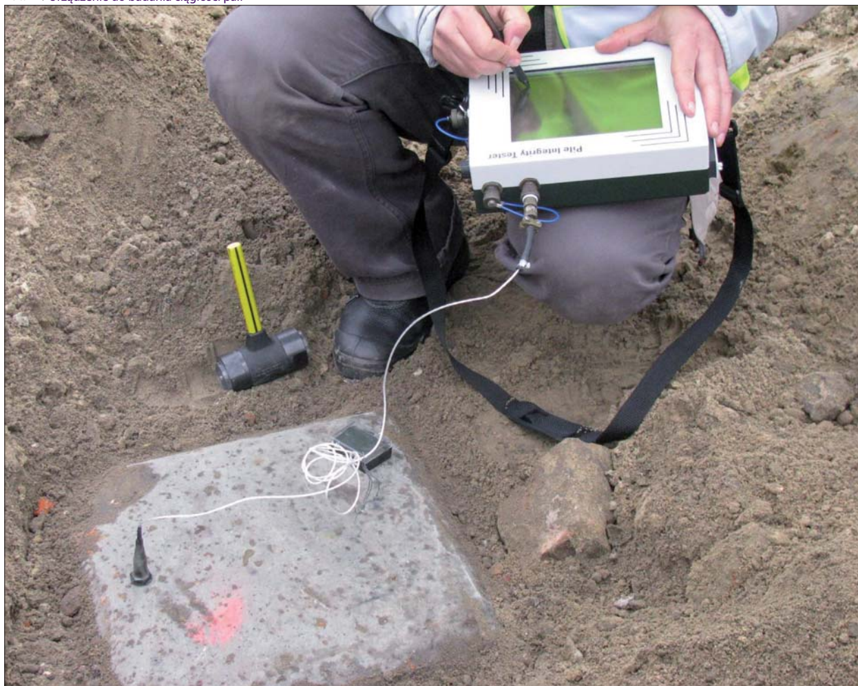
Fot. 2 | Urządzenie do badania ciągiłości pali
