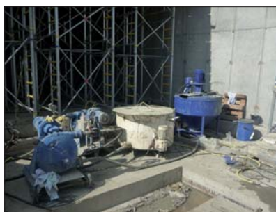
Fot. 1 | Urządzenie do wytwarzania zawiesziny bentonitowej
