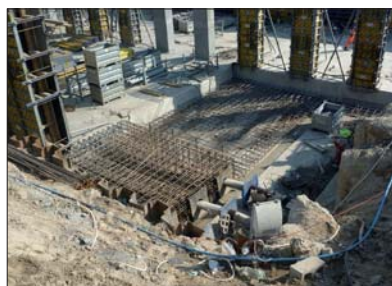
Fot. 3 | Wykonanie dodatkowego elementu dla zakotwienia czynnego
