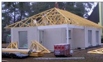
Fot. 4 Współczesne budynki energooszczędne o tradycyjnych kształtach (Fot. archiwum autora)
