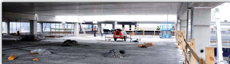
Fot. 2 | Parking nad peronami stacji Poznań Główny – przeszła 15,70+16,45 m, z prawej montaż przeszła 24,32 m
