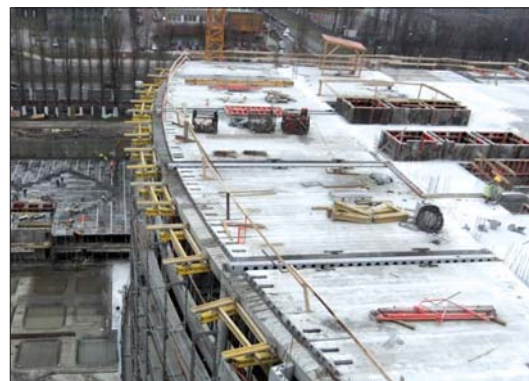
Fot. 5 | Ukryte w stropie belki Deltabeam®, na których umieszczono słupy ostatniej kondygnacji (Mokatów Nova, Ghelamco)
