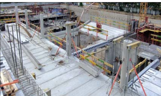
Fot. 4 | Budowa biurowca przy ul. Marynarskiej 12 w Warszawie (Ghelamco)
