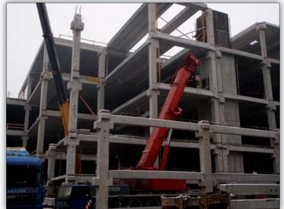
Fot. 2 | Płyty Hc 500 o rozpiętości 16,14 mb – budowa Galerii Handlowej Trzy Korony w Nowym Sączu
