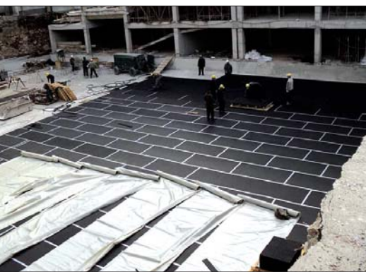
Fot. 1 | Układanie elastomerów i ich zabezpieczenie folią budowlaną
