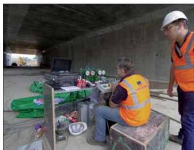
Fot. 6 | Stanowisko sterowania nasuwką
