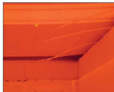
Fot. 2 | Pas dolny Deltabeam® po 180 minutach w warunkach pożaru standardowego
