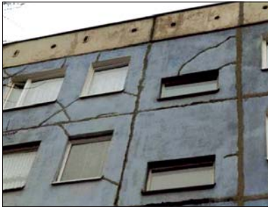
Fot. 1 Znaczne spękania warstwy fakturowej trójwarstwowej płyty ściennej powstałe na skutek degradacji wzajemnych połączeń z warstwą konstrukcyjną (nośną) płyty. Widoczne prowizoryczne naprawy i uszczelnienia spękań oraz wyszczerbienia płyt
