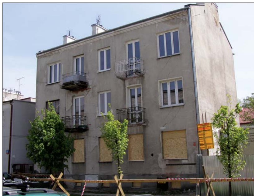
Fot. 1 | Widok budynku od strony ulicy po wykwaterowaniu
