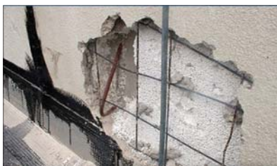
Fot. 4 Odkrywanie w miejscu występowania wieszaka trójkątnego. Widoczne wadliwe połączenie warstwy fakturowej z warstwą konstrukcyjną (nośną) płyty – brak pręta kotwiącego
