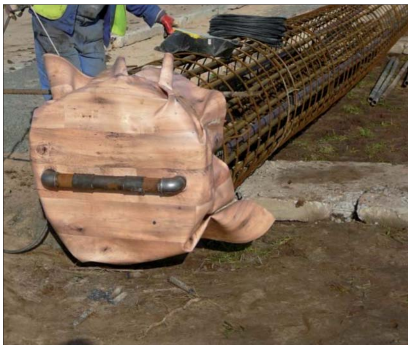
Fot. 2 | Instalacja do iniekcji bezkomorowej przymocowana do zbrojenia pała wielkośrednicowego
