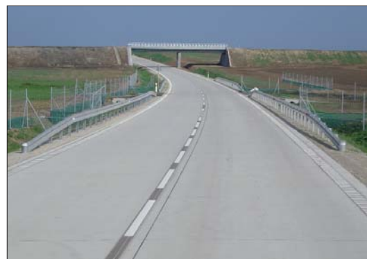
Fot. 3 | Wiadukt WDK-2 (przecięcie z drogą Bożanów-Nowice)
