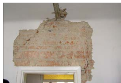
Fot. 8, 9 | Pęknięte nadproża. Uszkodzone płyty stropowe
