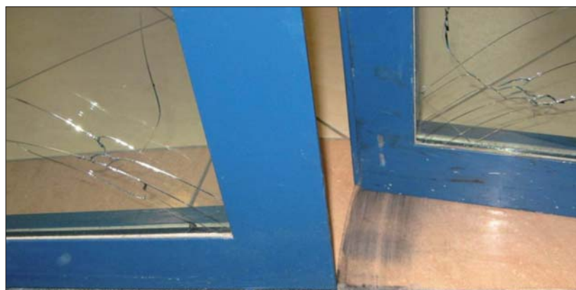
Fot. 2 | Uszkodzenie przeszklenia drzwi; wskutek osiadania narożniki drzwi ocierały o posadzkę, co wywoływało powstanie obciążenia skręcającego przekraczającego wartości dopuszczalne
