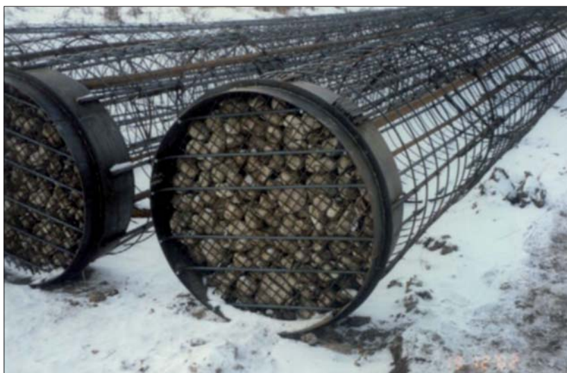
Fot. 1 | Sztywna komora iniekcyjna na budowie obwodnicy Ostrowi Mazowieckiej
