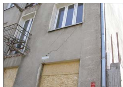
Fot. 2, 3 | Pęknięcia na elewacji frontowej
