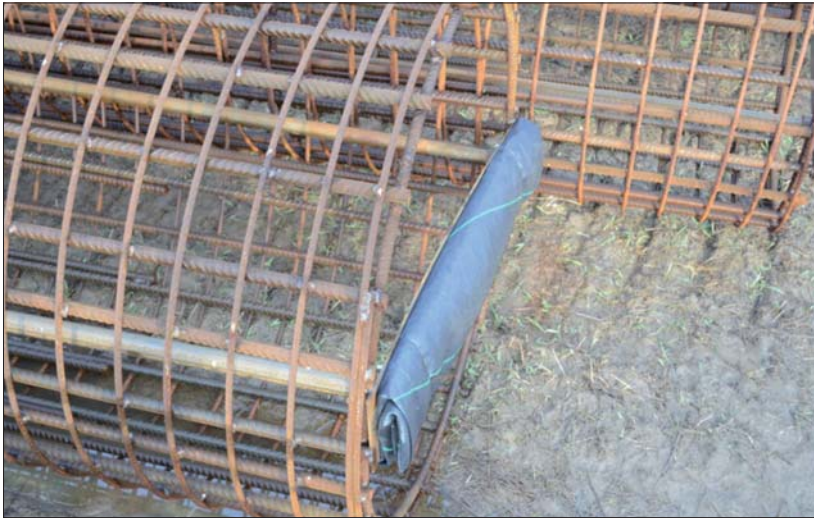
Fot. 4 | Przykład zbrojenia pała z instalacją z komorą elastyczną
