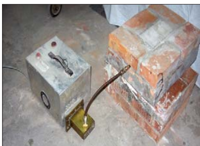
Fot. 3 | Generator mikrofalowy służący do osuszenia pasa muru w strefie iniekcji
