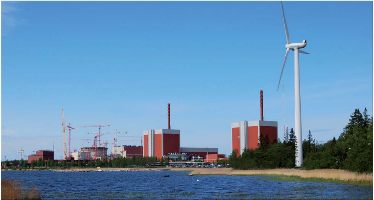
Fot. 2 | Elektrownia Olkiluoto 3 w budowie, Finlandia 2011 r. (źródło: www.wikipedia.org)
