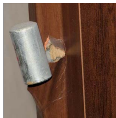
Fot. 1 | Wyrwanie zawiasów drzwi wskutek nieodpowiedniej wytrzymałości na obciążenie pionowe
