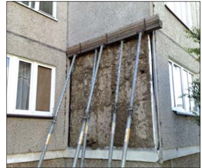
Fot. 3 Awaria płyty (stan zagrożenia życia, zdrowia i mienia). Odspojenie warstwy fakturowej płyty powstałe na skutek utraty wzajemnych połączeń z warstwą konstrukcyjną (nośną) płyty
