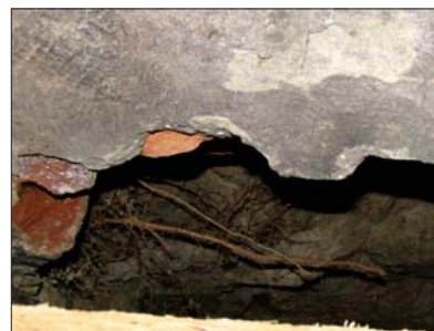
Fot. 12 | Bardzo niestarannie wykonane podbicie ławy fundamentowej
