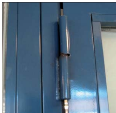
Fot. 3 | Przykład przyspieszonego zużycia zawiasów wskutek zastosowania drzwi o klasie trwałości mechanicznej nieodpowiadającej warunkom użytkowania
