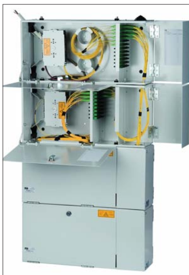
Fot. 2 | Przykład modułowej przełącznicy światłowodowej. Pierwszy moduł stanowi zakończenie włókien abonenckich (z każdego lokalu). Kolejne moduły to moduły operatorskie – dostawców usług. Przez kanał z prawej strony dokonywane jest tzw. krosowanie abonenta z wybranym przez niego operatorem (źródło: www.fca.com.pl)
