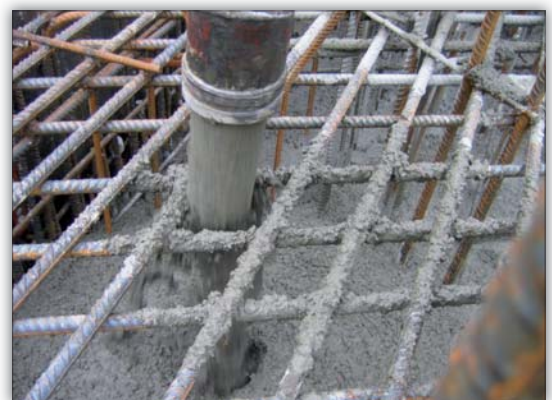
Fot. 1. Płynna konsystencja mieszanki betonowej – efekt działania superplastyfikatora
