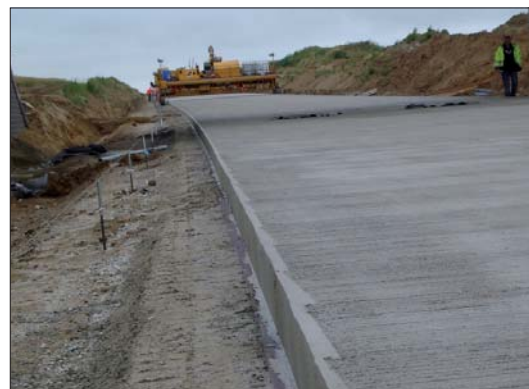
Fot. 2 | Układanie betonu
