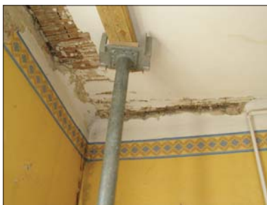
Fot. 11 | Uszkodzony strop drewniany
