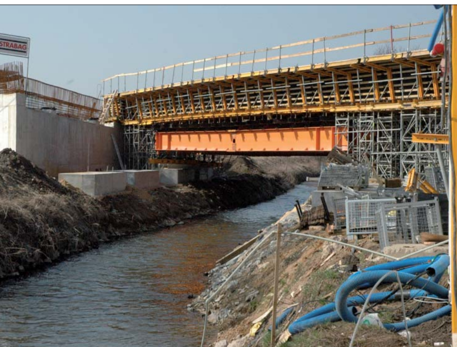
Fot. 4 | Montaż deskowania ustroju nośnego
