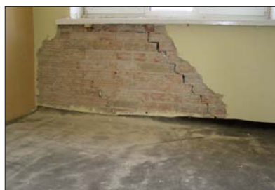
Fot. 6, 7 | Pęknięcia ścian podokiennych
