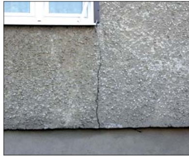
Fot. 2 Typowe, występujące w narożu otworu w płycie, spękanie warstwy fakturowej trójwarstwowej płyty ściennej powstałe na skutek degradacji wzajemnych połączeń z warstwą konstrukcyjną (nośną) płyty
