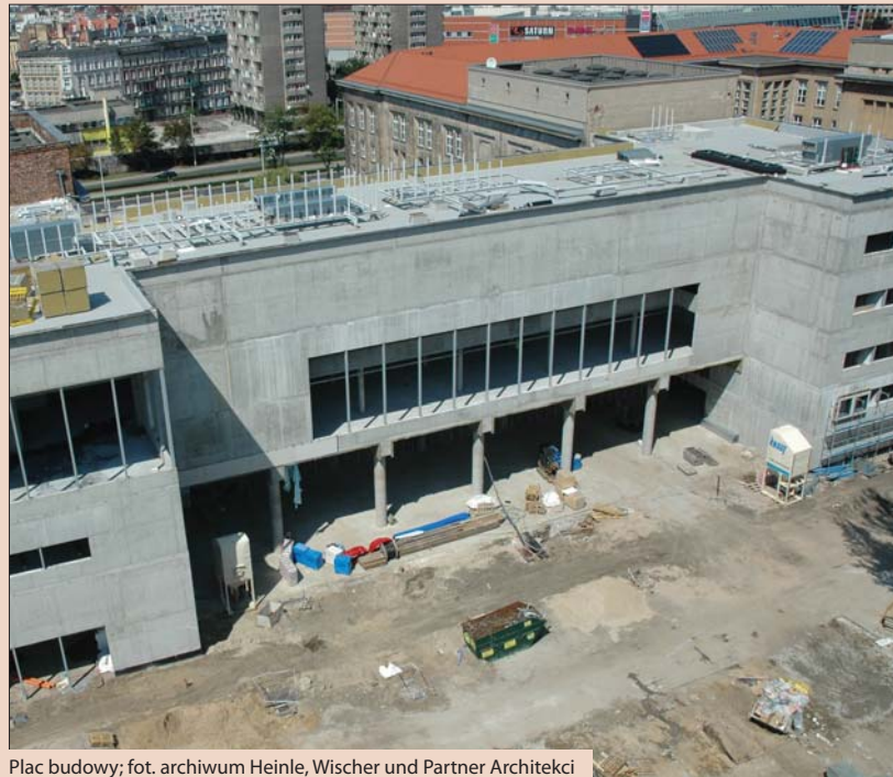
Plac budowy; fot. archiwum Heinle, Wischer und Partner Architektki
