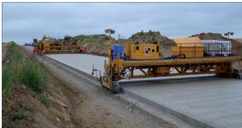
Fot. 1 | Układanie betonu w ciągu głównym drogi przy zastosowaniu układarki
