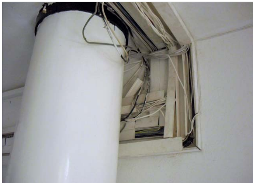
Fot. 1 Bałagan kablowy na klatce schodowej typowego bloku mieszkalnego (źródło: Ekspertyza Stowarzyszenia Teletechników Polskich XXI dot. instalacji kablowych – www.teletechnika.org.pl )
