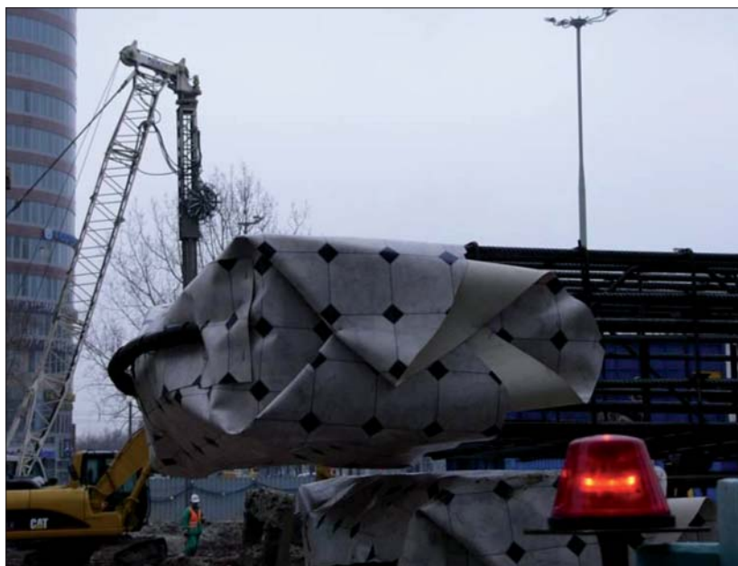
Fot. 3 | Przykład instalacji bezkomorowej do iniekcji baret w wieżowcu Rondo 1 (rondo ONZ) w Warszawie
