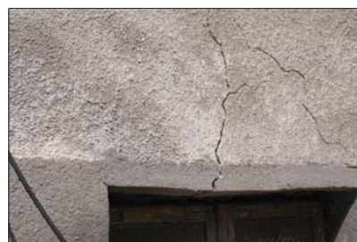
Fot. 4, 5 | Pęknięcia widoczne na elewacji od strony podwórka
