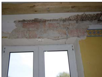
Fot. 10 | Pęknięte nadproże
